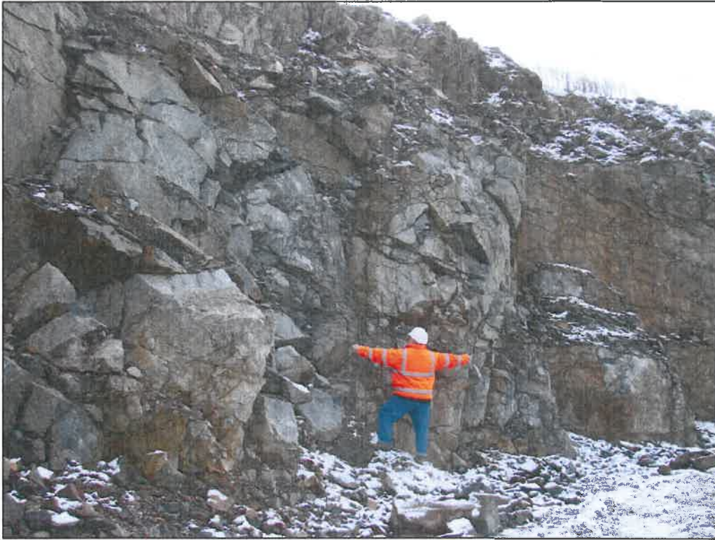
Bild 9: große Kluftabstände im Flammengneis auf der 5. Sohle
