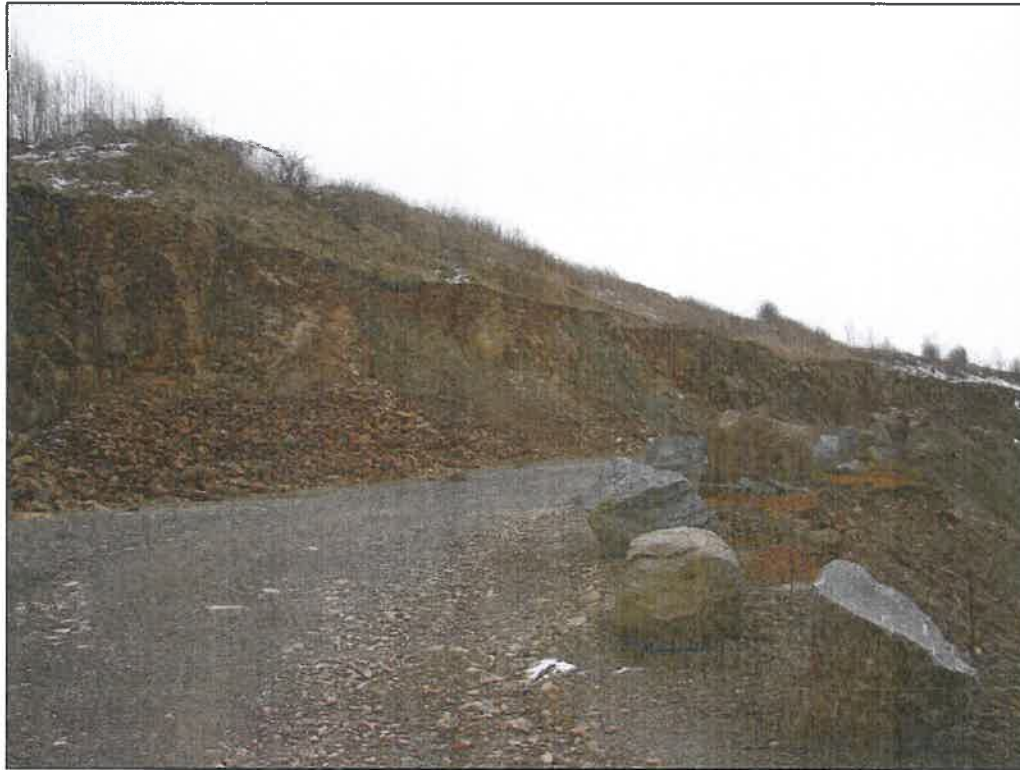
Bild 17: Überblick der 1. Sohle mit kleinstückig verwittertem Steinfall
