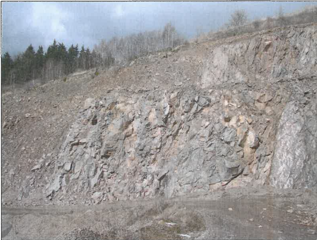
Bild 7: Blick von der 5. Sohle auf die Nordböschung mit eng geklüftetem Muskovitgneis
