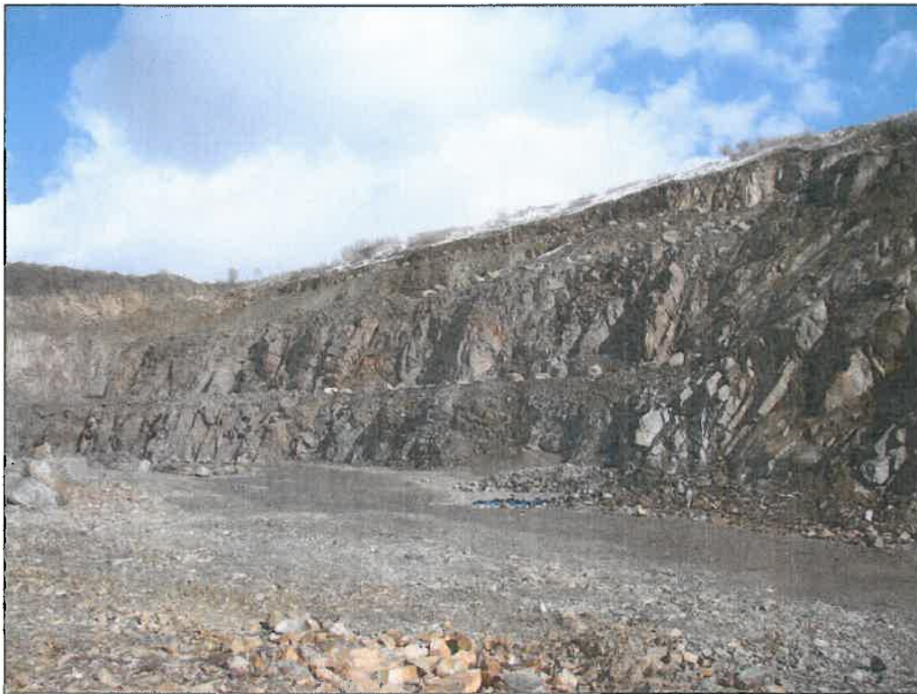
Bild 15: Überblick zum Böschungssystem im nördlichen Bereich - Zustand Februar 2015 -
