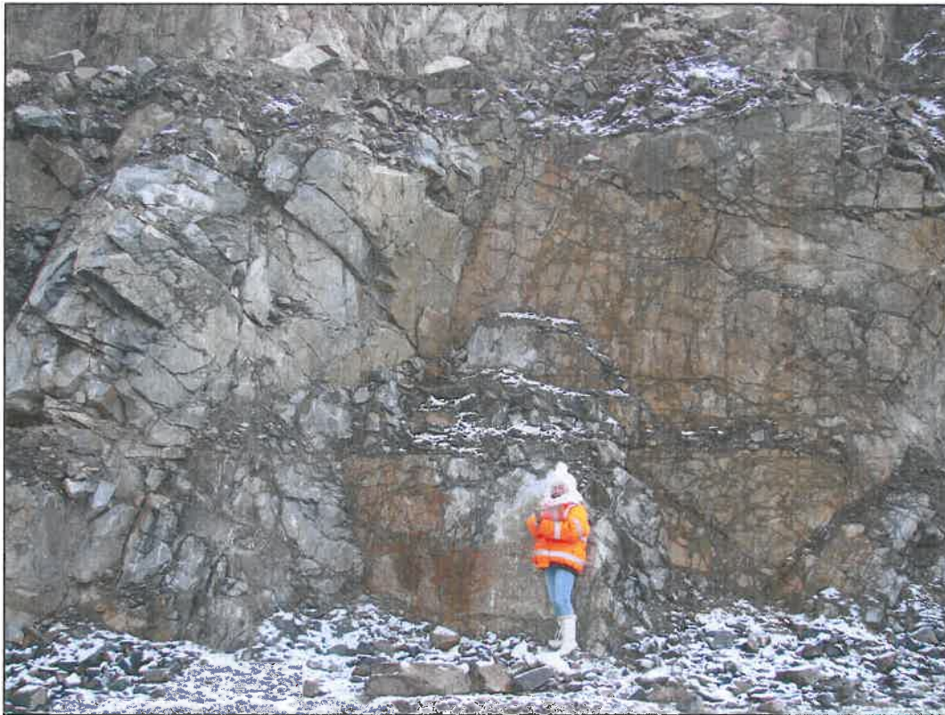
Bild 11: Flammengneis mit deutlich großen Trennflächenabständen
