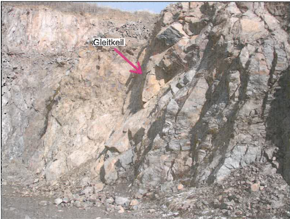
Bild 24: Gleitkeilbildung und Steinfall auf der 5. Sohle
