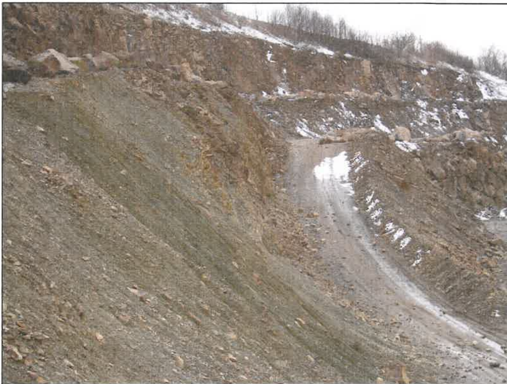
Bild 20: Steinfall nach Frostaufgang auf der Zufahrt zur 2. Sohle - Februar 2015 -
