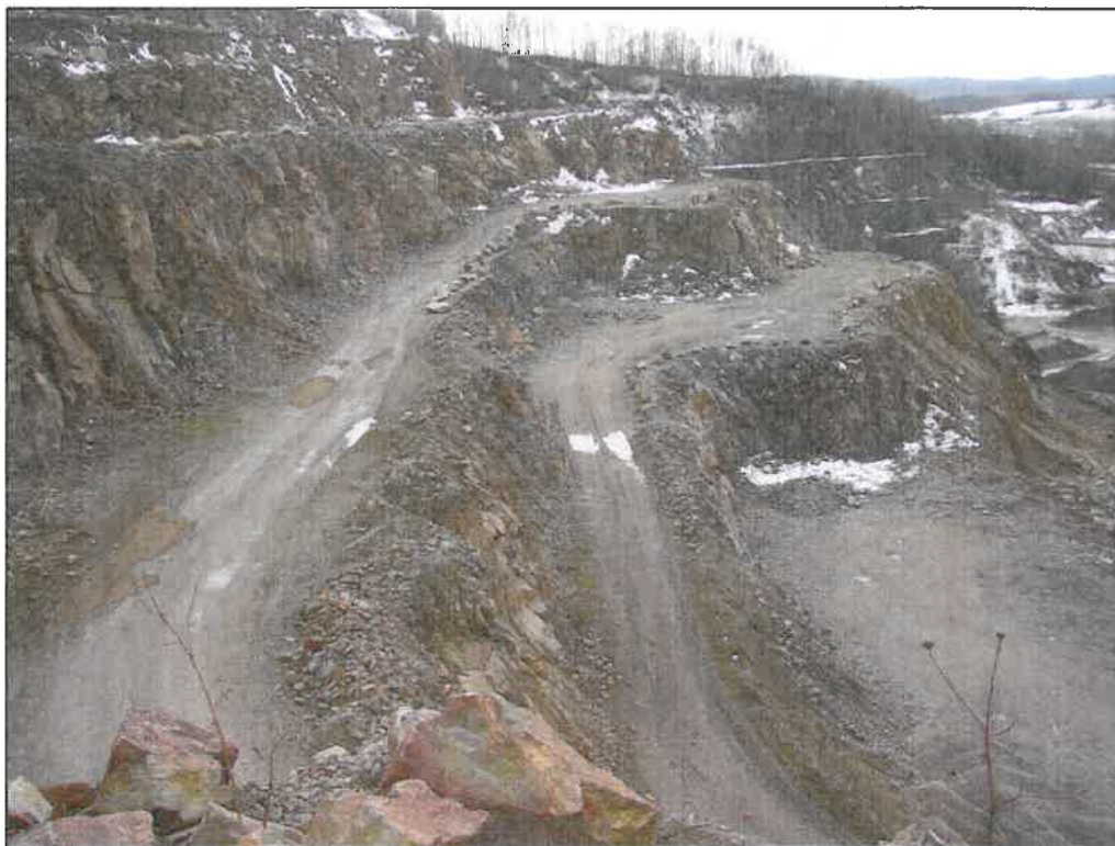
Bild 21: Panoramablick auf 4. und 5. Sohle mit geringem Steinfall am Ostböschungssystem
