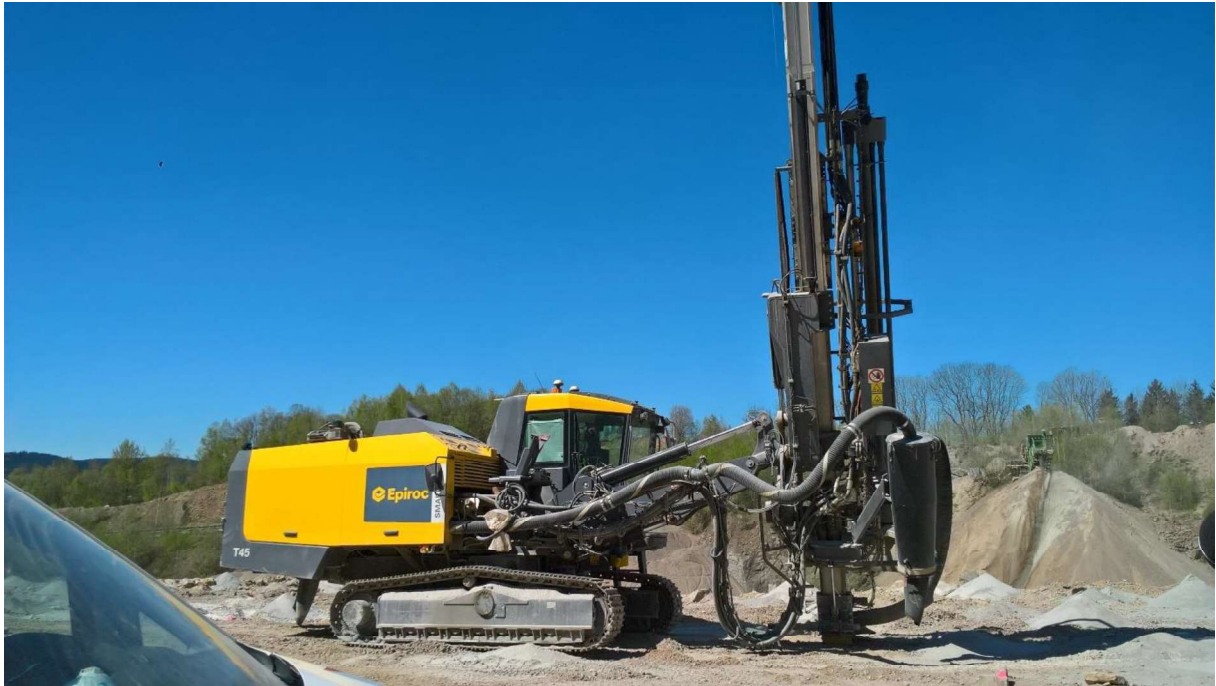
modernes Bohrgerät mit Filteranlage
