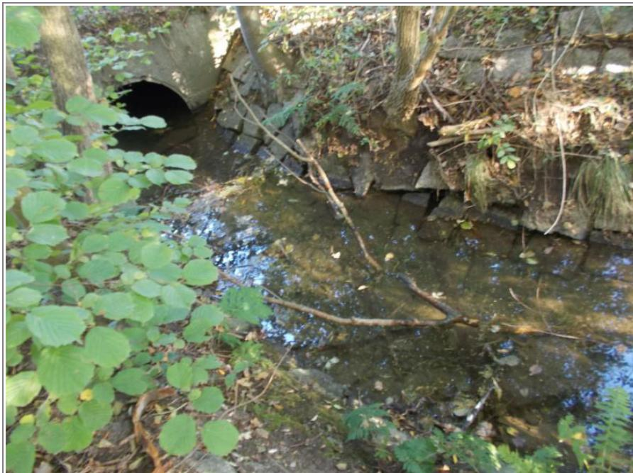
**Abb. 3** Verrohrte und befestigte Einmündung des Grabens am Gewerbepark in die Spree.
