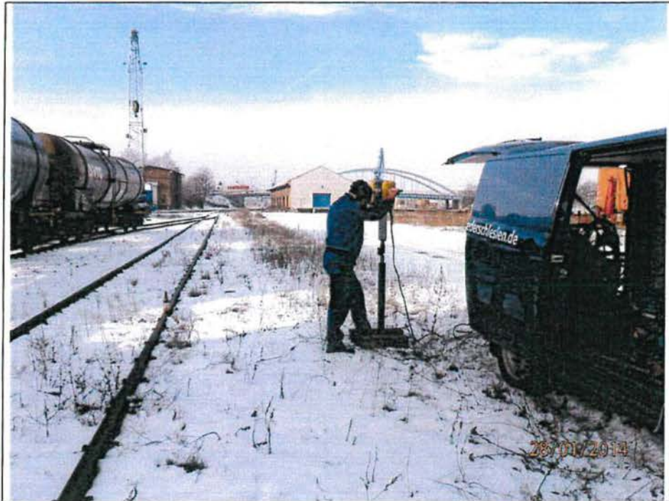
Foto 3: Das am 28.01.2014 aufgenommene Foto dokumentiert die Aus-/ Durchführung der RKS 4/ BG 05 - 2014 im Plangebiet. Im Hintergrund gut erkennbar die Hafenbrücke Riesa.
