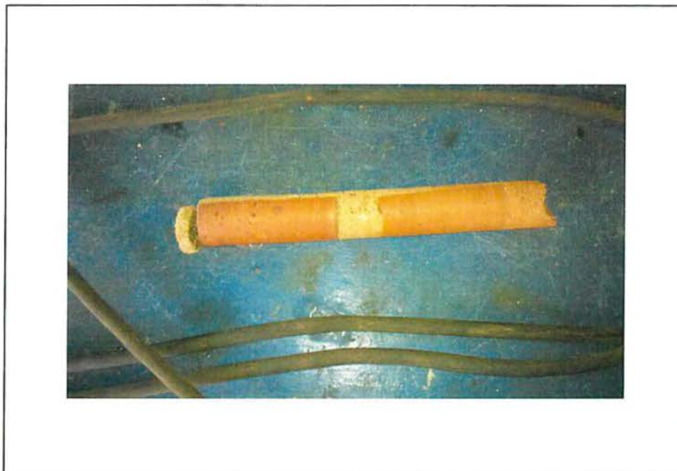
Bohrkern Innenwand Schmiede / Werkstatt
