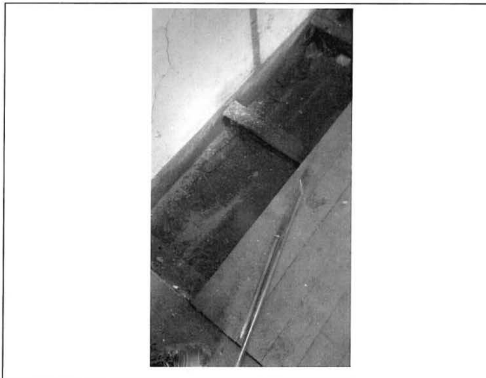
Probenahme Holz Fußboden 1. OG Kopfanbau
