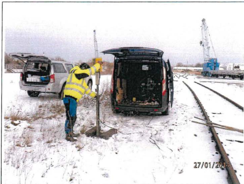
Foto 1: Das Foto vom 27.01.2014 dokumentiert das Abteufen der Rammkernsondierung mit der Kurzbezeichnung RKS 1/ BG 05 - 2014 durch das im Auftrag BIB tätige Fachbohrunternehmen GEO-SERVICE NIEDERSCHLESIEN, Brunnenbauermeister Frank Stein aus 02943 Weißwasser.
