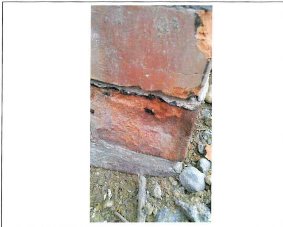
Probenahme Sperrschicht Außenwand Trafogebäude
