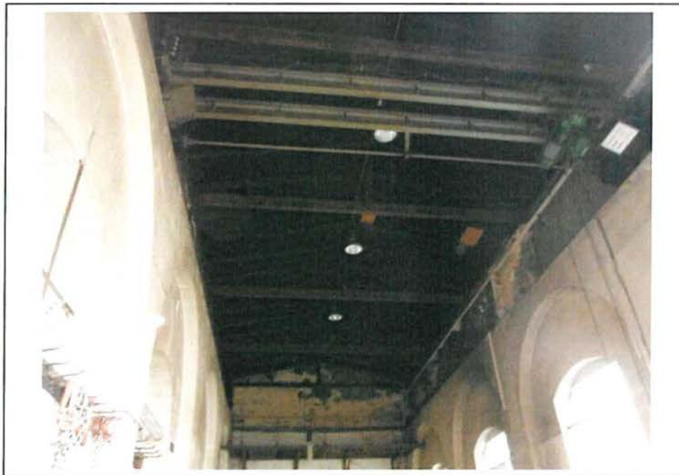
Innenaufnahme Dach im Schmiedeanbau
