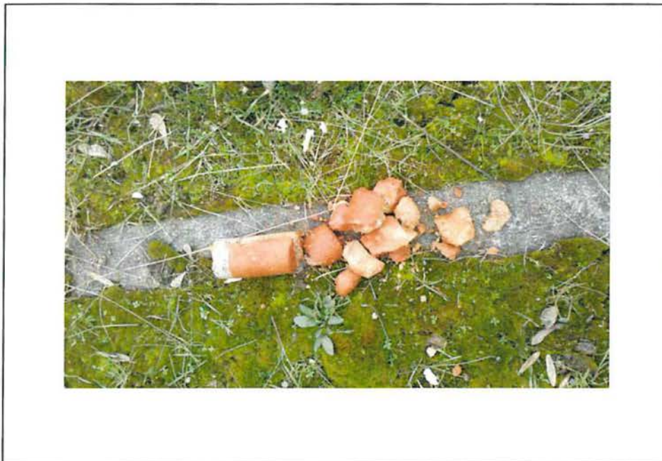
Bohrkern nördliche Außenwand
