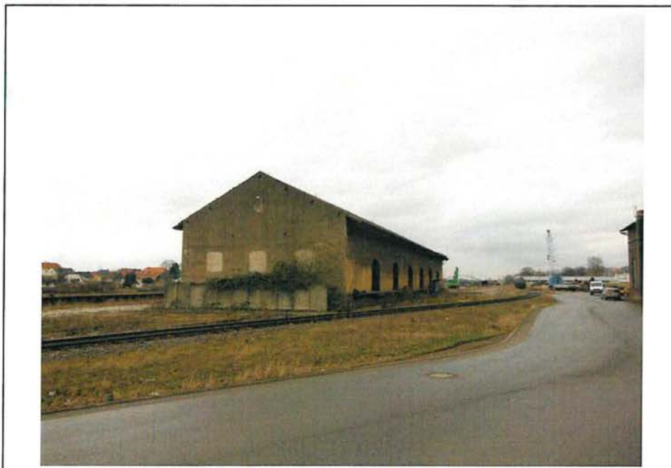
Blick auf den Schuppen C aus südwestlicher Richtung
