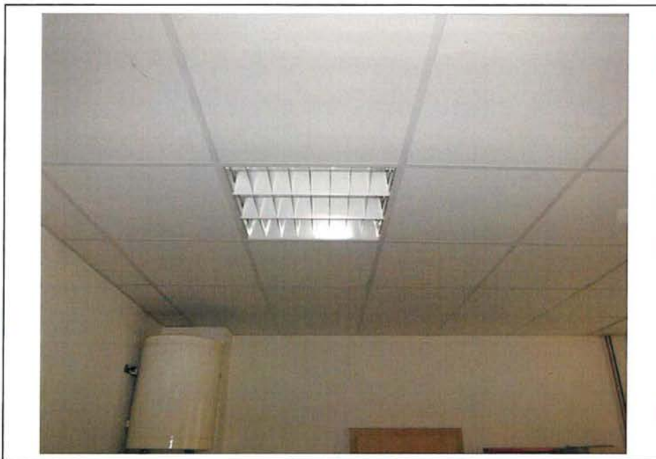
Blick auf die abgehängte Decke mit Neonröhrenlampenkörper im Aufenthaltsraum des Werkstattgebäudes
