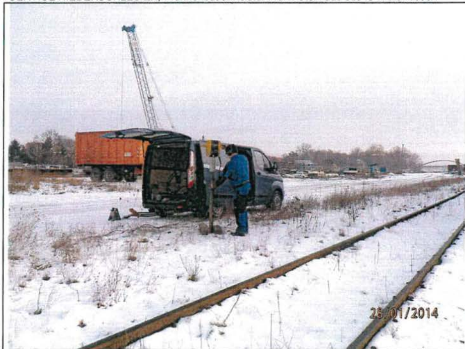
Foto 2: Das Foto vom 28.01.2014 zeigt das Aus-/ Durchführung der RKS 3/ BG 05 - 2014.
