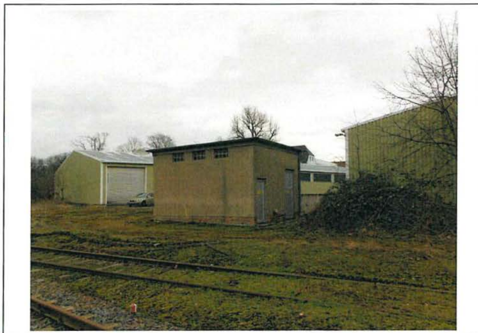
Blick auf die Trafogebäude aus nordöstlicher Richtung
