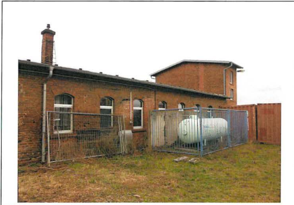
Blick auf den östlichen teil des Werkstattgebäudes aus südwestlicher Richtung
