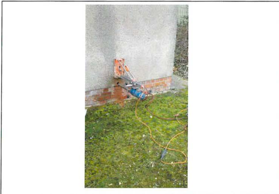
Kernbohrung nördliche Außenwand
