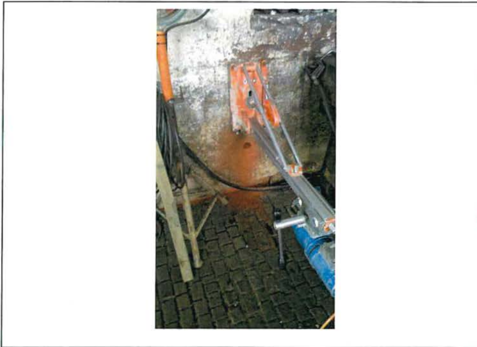
Kernbohrung Innenwand Schmiede / Werkstatt
