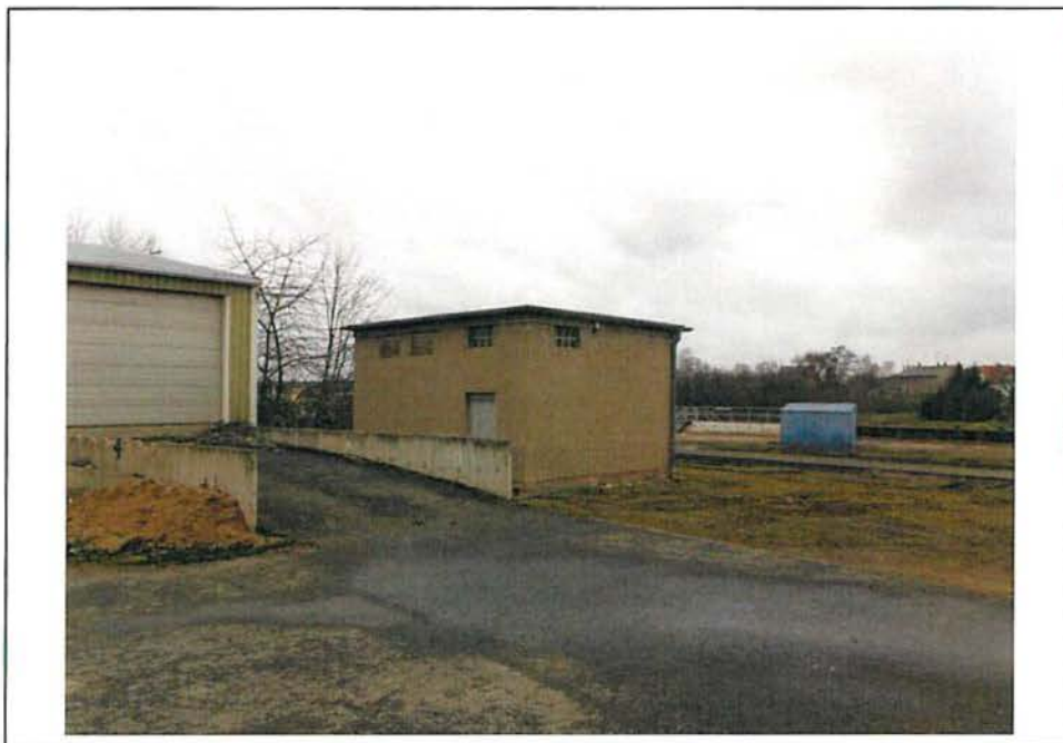
Blick auf die Trafogebäude aus südöstlicher Richtung
