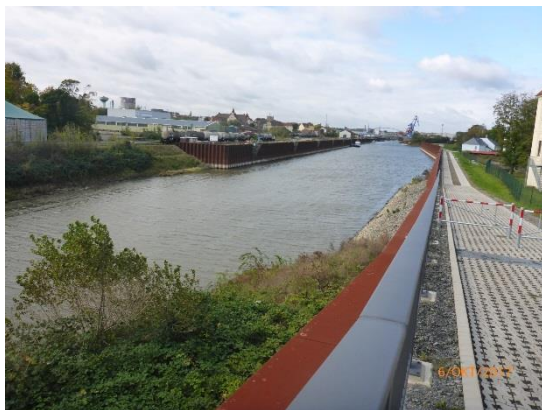
Foto 13: mit Spundwänden umfasstes Hafengelände
