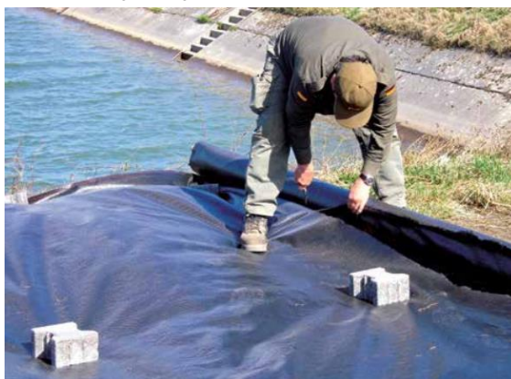
Foto 37: Auslegen einer Vergrämungsfolie (LUBW 2014)
