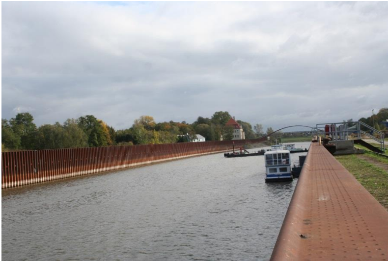
Foto 30: Hafenbecken mit beidseitigen Spundwänden
