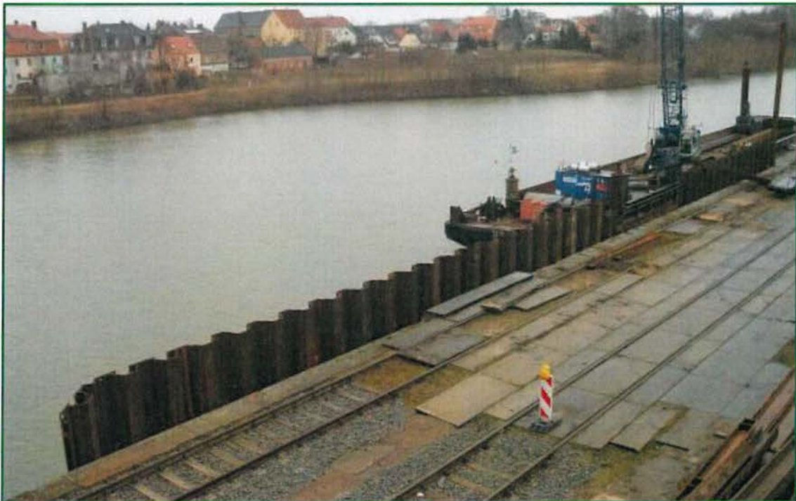
Bild 8: Angedeuteter Höhenunterschied zwischen Neubau Kaimauer u. Bestand ( \approx 0,8 m)
