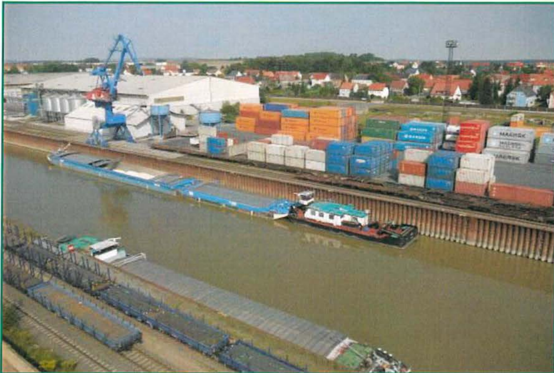
Bild 2: Containerterminal am Nordufer im Hafen Riesa (Quelle: R. Micknaß, Dresden)
