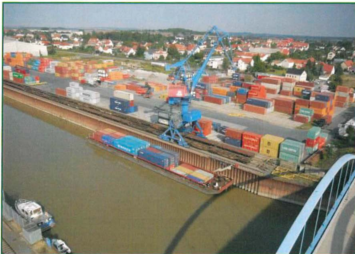
Bild 3: Containerterminal mit Gleisanlage und Wippdrehkran am Nordufer im Hafen Riesa (Quelle: R. Micknaß, Dresden)
