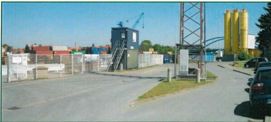
Bild 7: Funkmast auf der Verkehrsinsel gegenüber dem vorhandenen SBO-Verwaltungsgebäude
