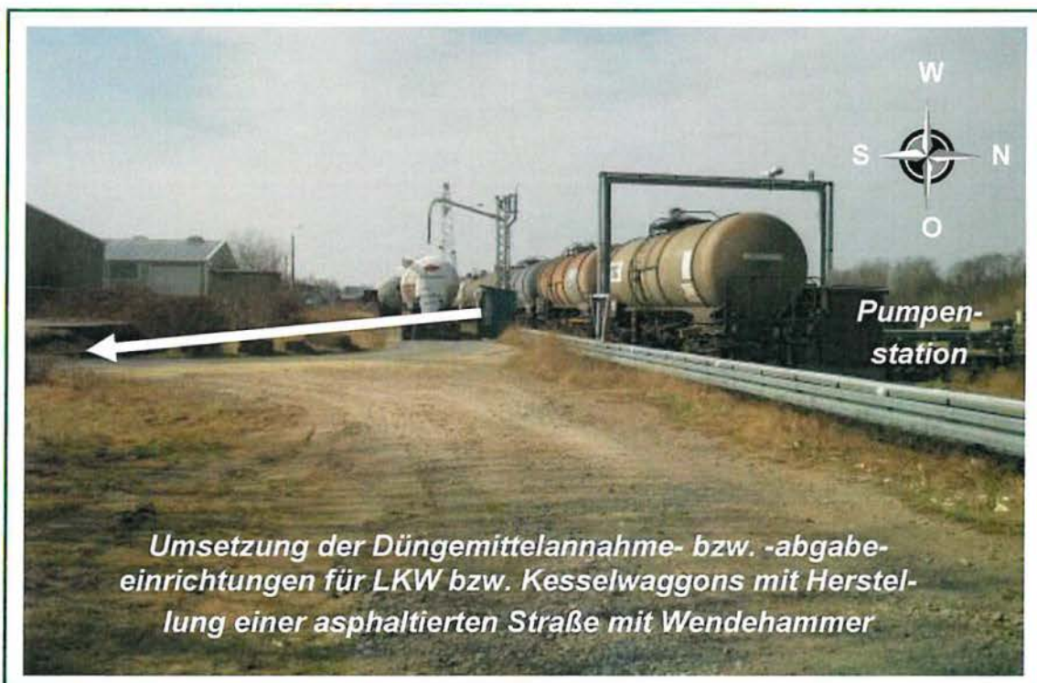
Bild 23: Düngemittelannahme- bzw. -abgabeeinrichtungen für LKW bzw. Kesselwaggons
