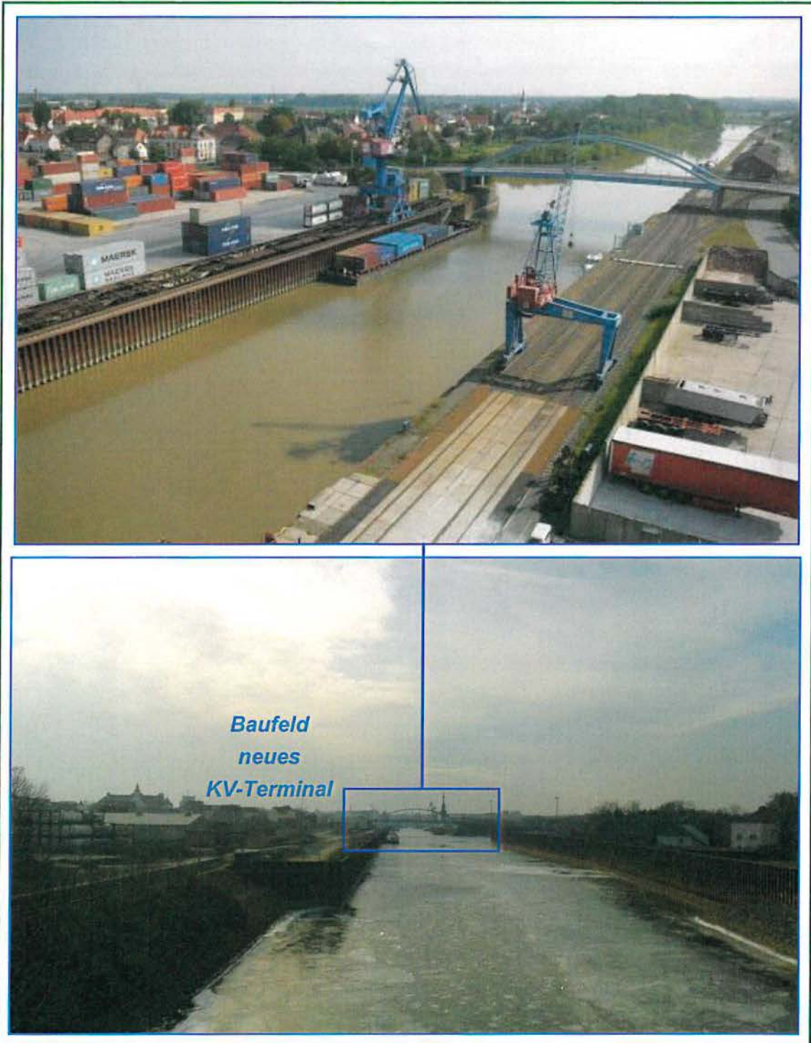
Bild 4: Luftaufnahme (oben) und Baufeld KV-Terminal Hafen Riesa
