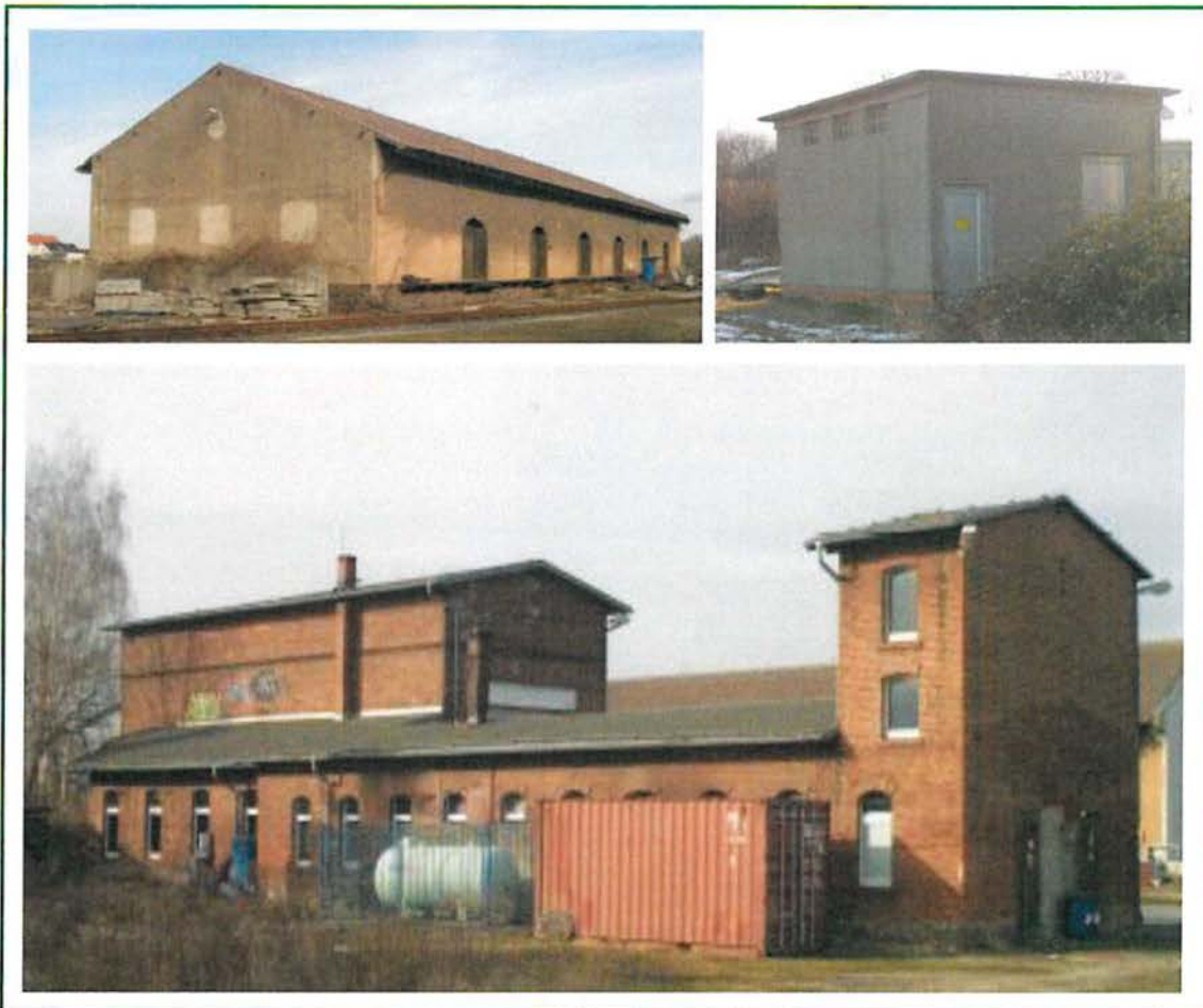
Bild 10: Ansichten der komplett abzubrechenden Gebäude
