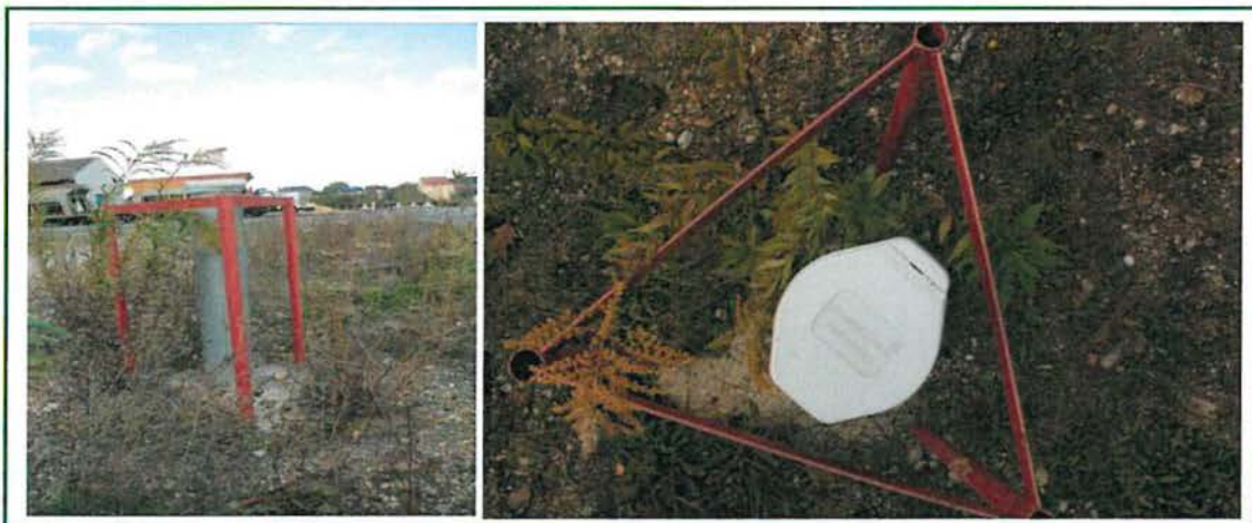
Bild 26: Grundwassermessstelle auf dem Baufeld des neu zu errichtenden Terminals
