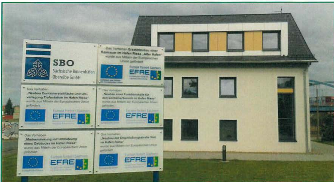
Bild 6: Containerverkehrabfertigungsgebäude im Hafen Riesa, Paul-Greifzu-Straße 4
