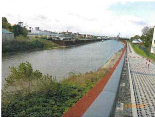
Foto 25: mit Spundwänden umfasstes Hafengelände
