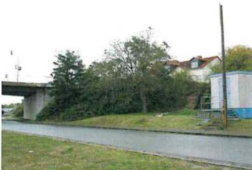
Foto 13: Gehölzstrukturen, an die Hafenbrücke angrenzend
