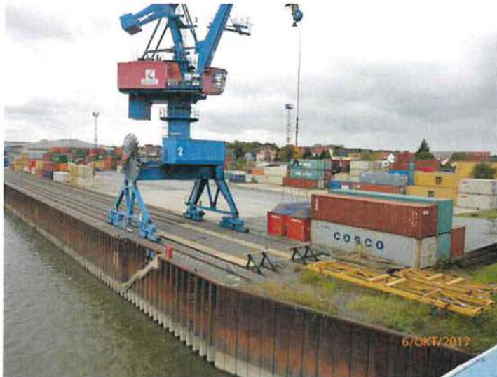
Foto 41: Containerterminal auf der Nordseite des Riesaer Hafens
