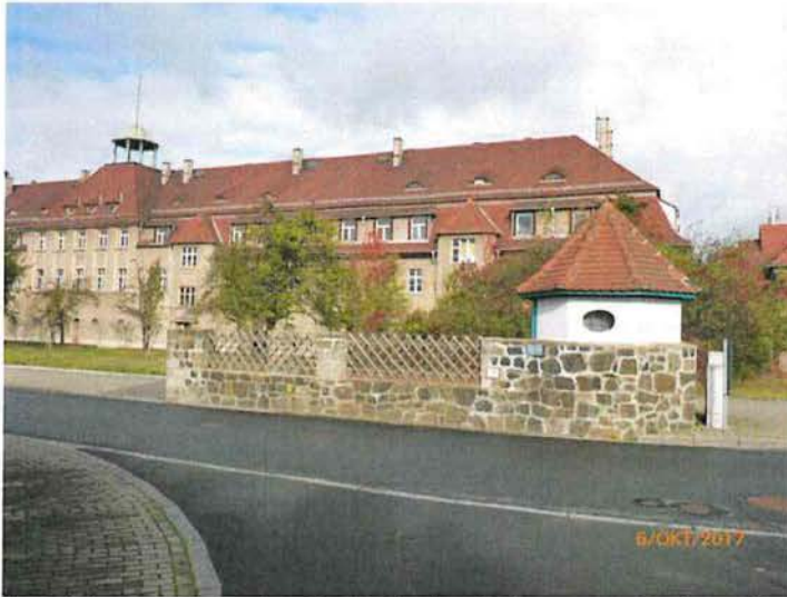
Foto 46: leerstehender Wohnriegel Rittergutstraße (zum ehem. ESAG-Gelände gehörig)
