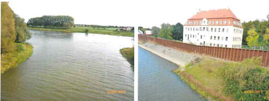
Foto 2: links: Mündung des Hafenbeckens der Döllnitz in die Elbe; rechts: Gröbaer Schloss hinter der Spundwand der Hochwasserschutzanlage
