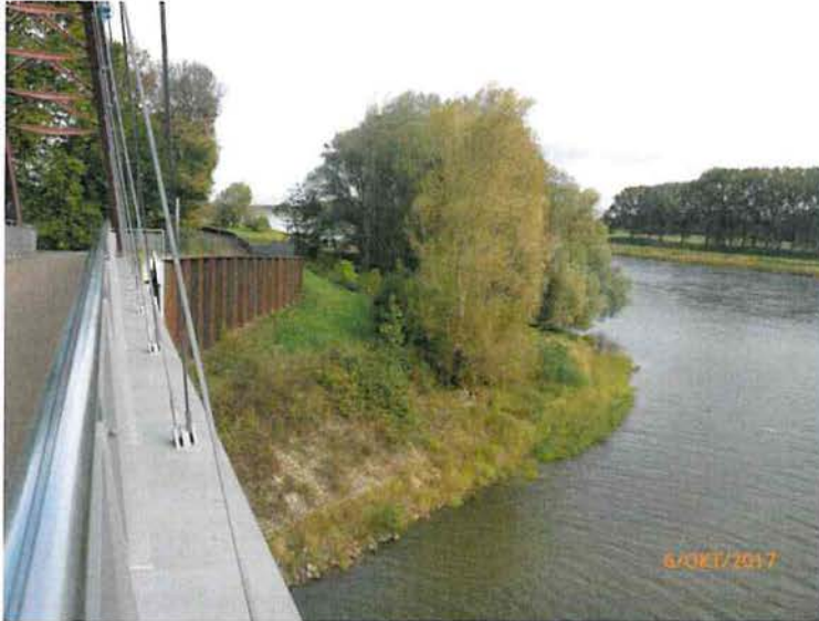
Foto 32: Blick von der Schlossbrücke auf Auwaldrest am Elbufer bzw. in die Elbaue, mit Hochwasserschutzwand
