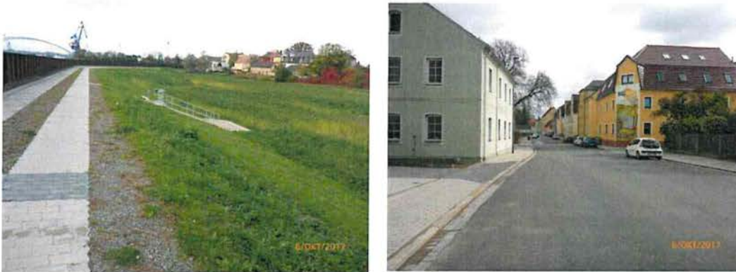
Foto 7: Hochwasserschutzanlage mit angrenzenden Ruderalflächen und anschließender Wohnbebauung; rechts: Kirchstraße nördlich der Hochwasserschutzanlage
