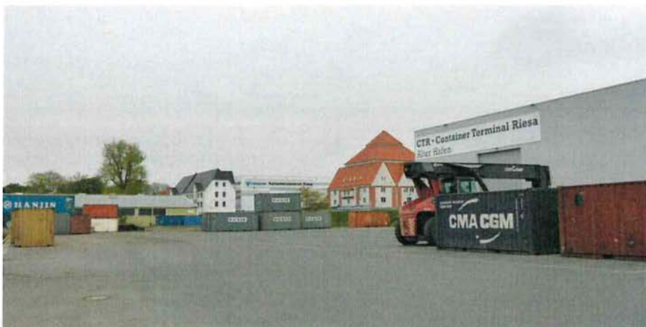
Foto 45: Funktionshalle Containerservicebereich sowie Lagerhalle und Lagerplatz im östlichen Teil des Alten Hafens
