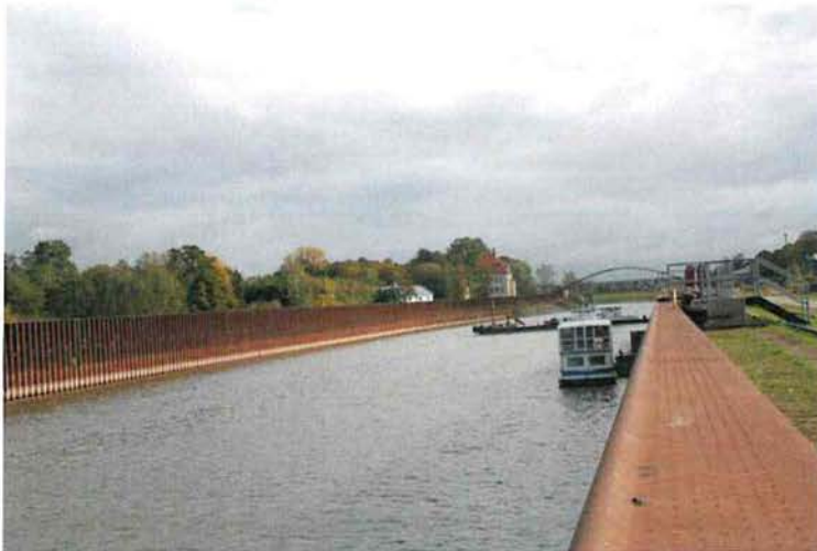
Foto 30: Hafenbecken mit beidseitigen Spundwänden
