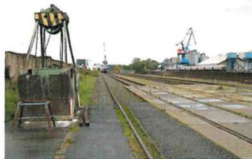
Foto 12: Grünstreifen, an die Gleisanlage angrenzend
