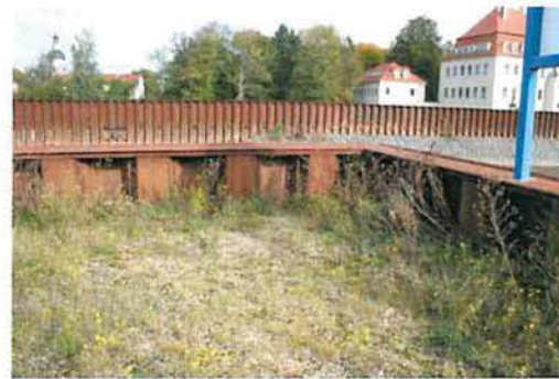
Foto 18: Spundwandabgrenzung am Östlichen Hafengelände
