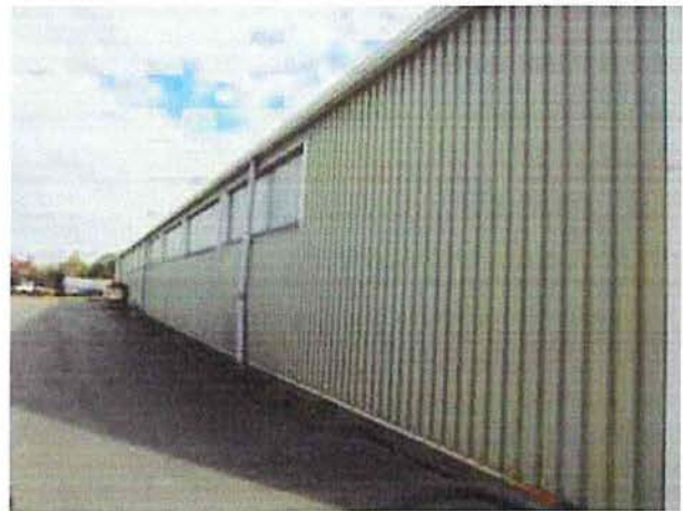
Halle 2 – Fassade Westseite
