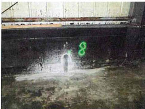
Bereich Ansatzpunkt Kernbohrung KB 8 (Betonsockel Hallenwand Westseite)
