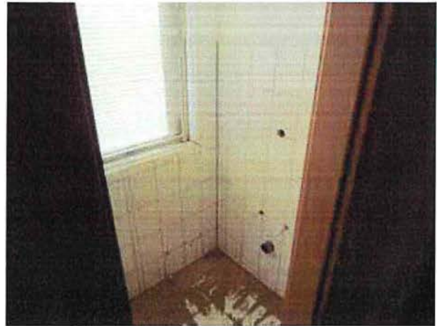
Containermodul-Sanitärtrakt: mit demontierten Sanitäreinrichtungen
