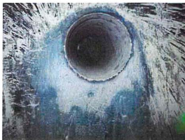
Bohrloch KB 7 WP mit Miwo-Dämmung der Fassadenverkleidung an der Sockelaußenseite
