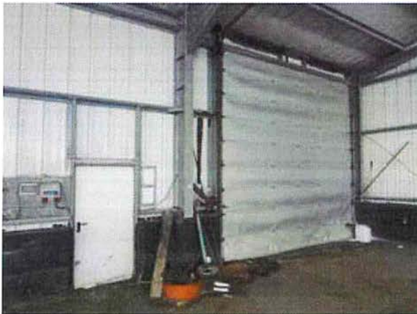
Halle 2 – Hallenzufahrt mit Tor (Westseite)
