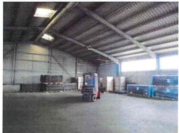
Abbruch Kalthalle Achse 9-13: Stahlkonstruktion Hallendach
