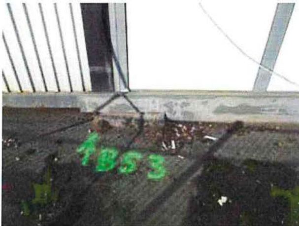
Probenahmebereich BS 3 (Streifenfundament Mitte Ostseite)
