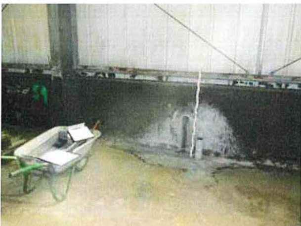
Bereich Ansatzpunkt Kernbohrung KB 9 (Betonsockel Hallenwand Ostseite)
