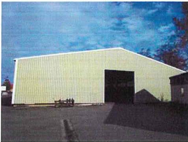
Halle 2 – Fassade Südseite mit Hallenzufahrt
