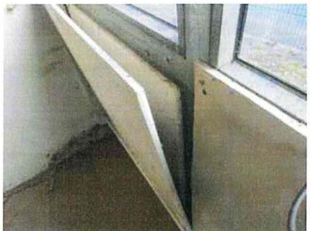
PP 4-Gangbereich: GiKa-Verkleidung mit Styropordämmung, Blechfassade
