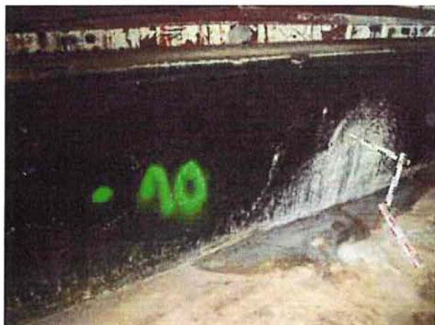
Bereich Ansatzpunkt Kernbohrung KB 10 (Betonsockel Hallenwand Ostseite)
