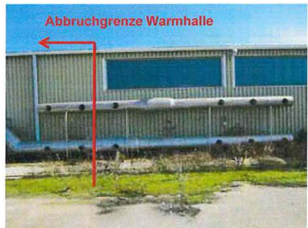
Hallenrückseite: Demontage lufttechnische Anlagen, Umbau Dachentwässerung
