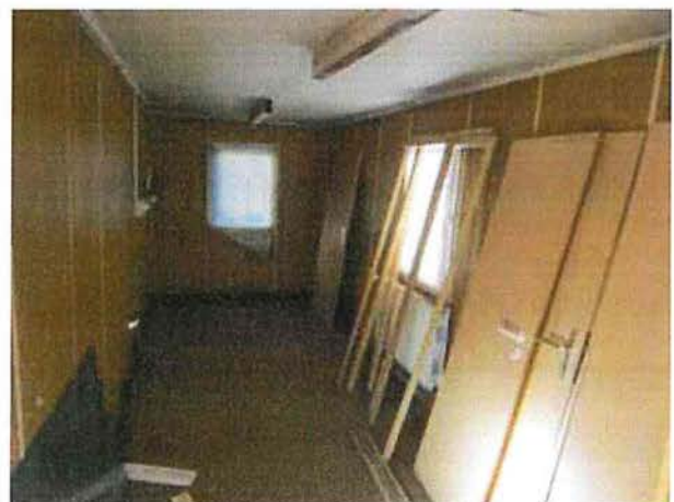
Containermodul: Büroräume (abgebrochene Umbaumaßnahme)
