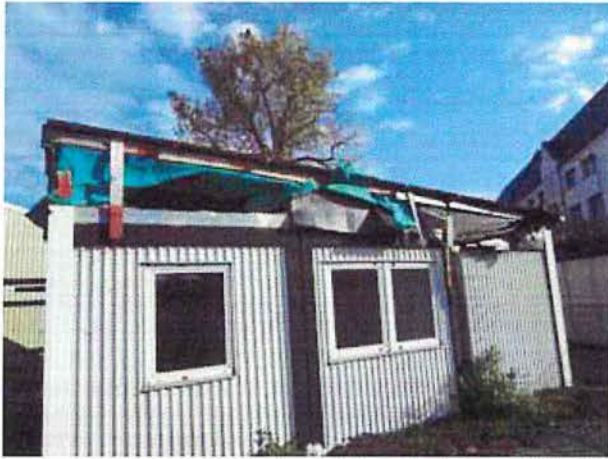
Prüfpunkt PP 5-Dachkonstruktion: Dämmungsauflage
