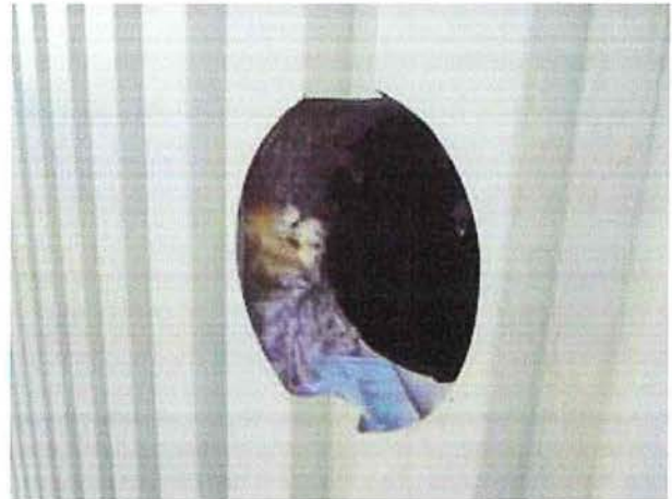
Prüfpunkt PP 3: Dämmwolle (KMF) wie Probe F 1
