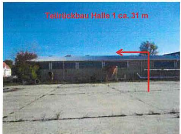
Bereich Teilrückbau - Ansicht Hallenrückseite (West)
