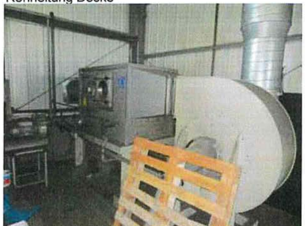
Abbruch Teilabschnitt Warmhalle Achse 8-9: Lufttechnische Anlagen (Radialventilator mit Befeuchter)
