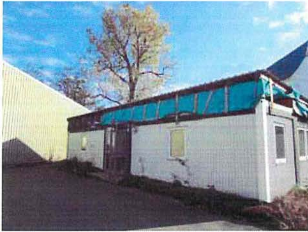
Containermodul: Ansicht Westseite
