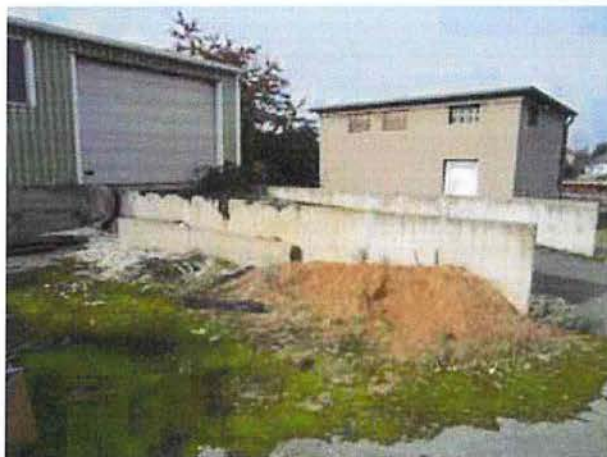
Bereich Teilrückbau: Abbruch Rampe
