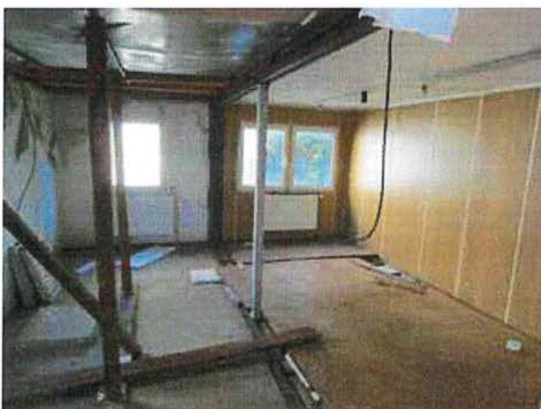
Containermodul: Büroräume (abgebrochene Umbaumaßnahme)
