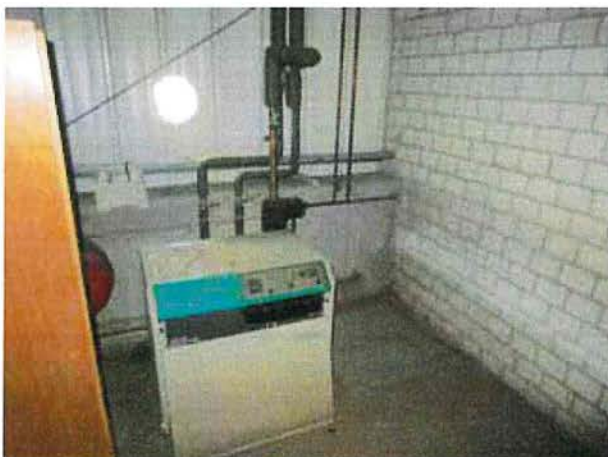
Teilabschnitt Warmhalle Achse 8-9: Rückbau Heizungsanlage
