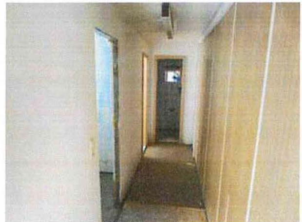
Containermodul: Zugangsbereich Sanitärtrakt
