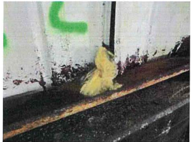
Halle 2 – Trapezblechfassade mit innenliegender Miwo-Dämmung
