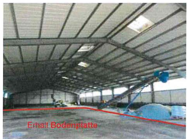
Komplettückbau Hallenkonstruktion mit Trapezblechfassade, Teilerhalt Bodenplatte
