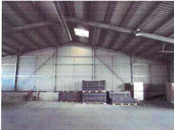
Abbruch Kalthalle Achse 9-13 - Ansicht Giebel Nord: Hallenkonstruktion mit Trapezblechfassade
