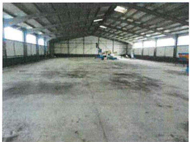
Komplettückbau Stahlkonstruktion Hallendach mit Trapezblechfassade
