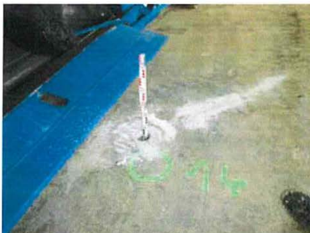
Bereich Ansatzpunkt Kernbohrung KB 14 (Hallenfußboden)
