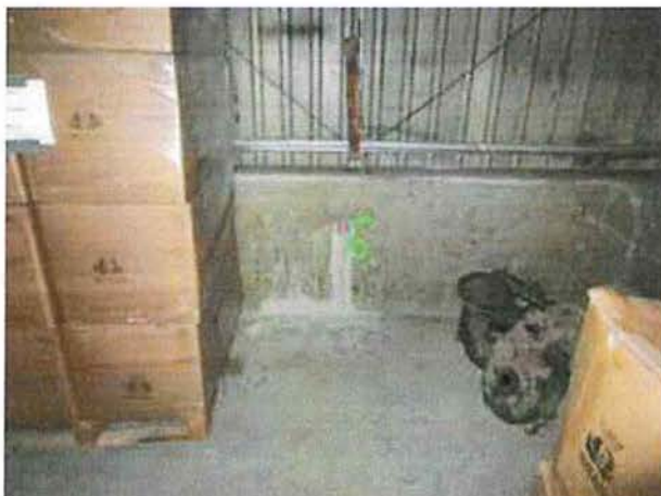
Bereich Ansatzpunkt Kernbohrung KB 6 (Betonsockel Kalthalle Hallenwand Nordseite)
