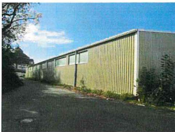
Halle 2 – Fassade Ostseite
