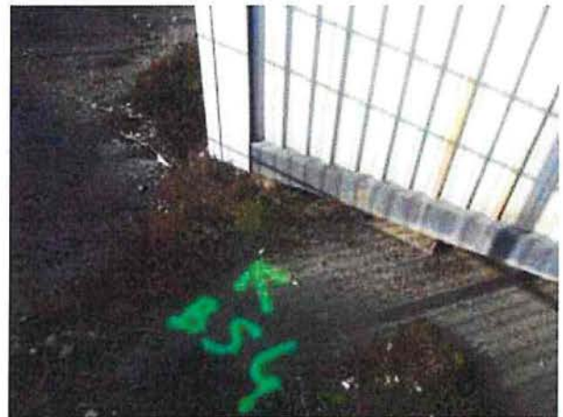
Probenahmebereich BS 4 (Streifenfundament Westseite)
