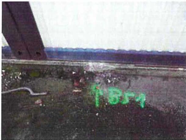
Probenahmebereich BS 1 (Streifenfundament Nordseite)
