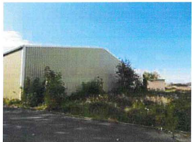
Halle 2 – Fassade Nordseite
