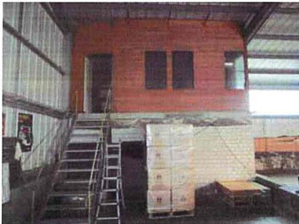
Abbruch Teilabschnitt Warmhalle Achse 8-9: Einbauten im Abbruchbereich
