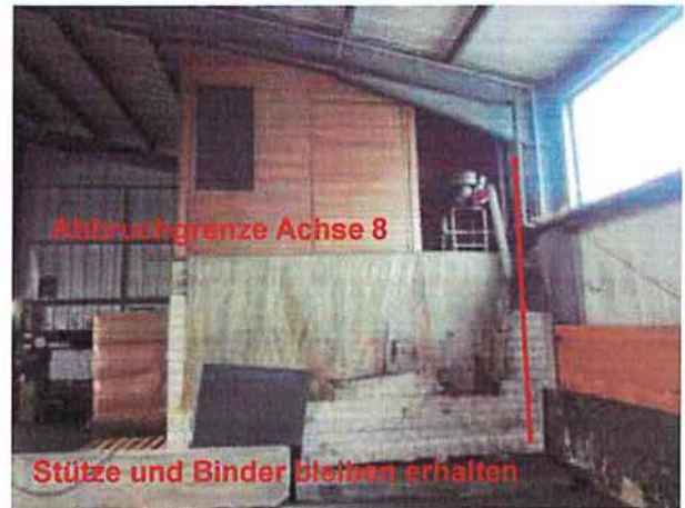
Abbruch Teilabschnitt Warmhalle Achse 8-9: Einbauten im Abbruchbereich
