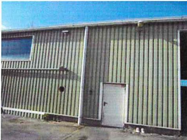
Prüfpunkt PP 3 (Warmhalle, Außenseite Ost) Dämmung Hallenwand
