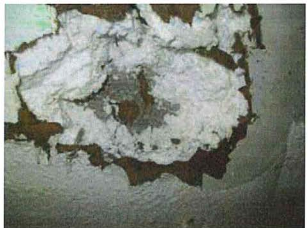
PP 2-Aufbau: Hartfaserplatte, Dämmung Styropor, Blechfassade
