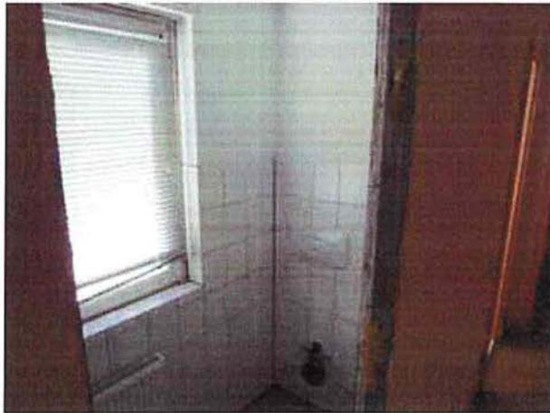
Containermodul-Sanitärtrakt: mit demontierten Sanitäreinrichtungen
