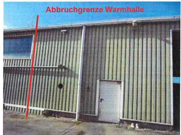
Teilrückbau Warmhalle mit Zugang Heizung und Elektroschaltraum, Umbindung Dachentwässerung
