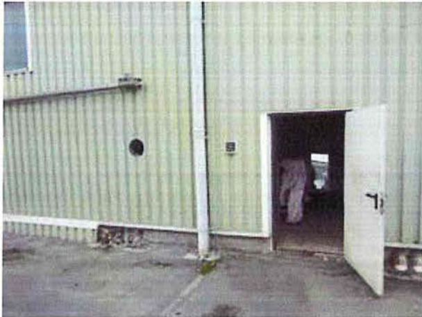
Teilabschnitt Warmhalle Achse 8-9: Abbruch Einbauten Schaltzentrale und Heizung
