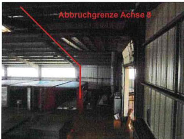
Abbruch Teilabschnitt Warmhalle Achse 8-9: Einbauten im Abbruchbereich
