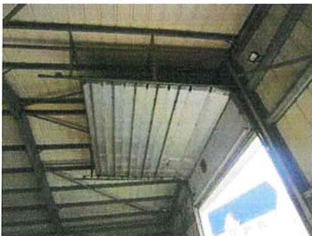
Halle 2 – Hallenzufahrt mit Tor (Südseite)
