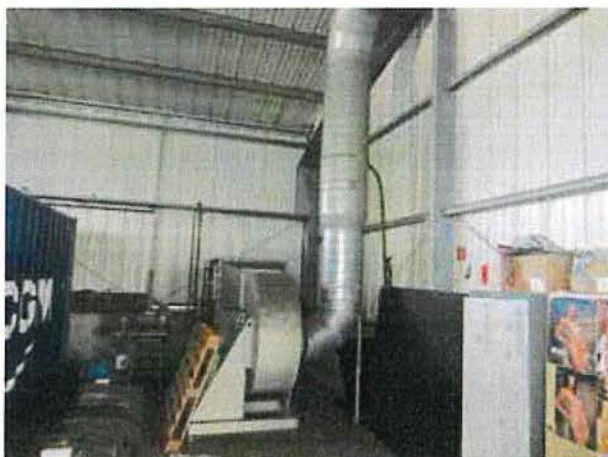
Abbruch Teilabschnitt Warmhalle Achse 8-9: Rohrleitungsbestand lufttechnischer Anlagen
