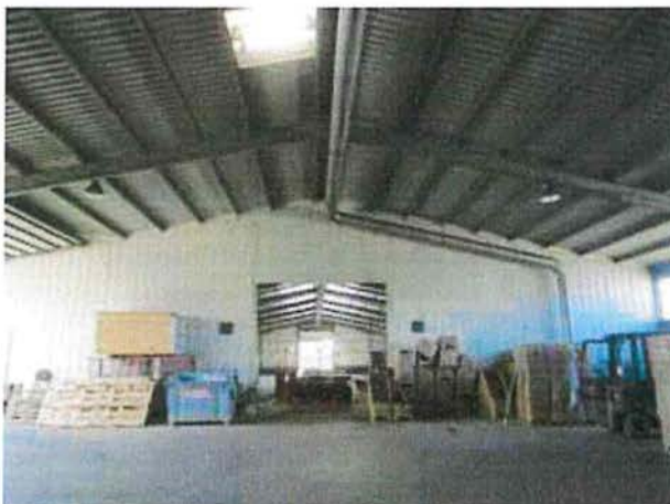
Abbruch Kalthalle Achse 9 (Süd): Trennwand mehrschalig zur Warmhalle (Trapezblech mit innenliegender Miwo-Dämmung), Leitungsbestand lufttechnischer Anlagen
