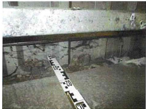
Prüfpunkt PP 7 (Kalthalle, Hallenwand, Innenseite Nord) Trapezblech einfach, ohne Dämmung, Sockel mit Schotterhinterfüllung
