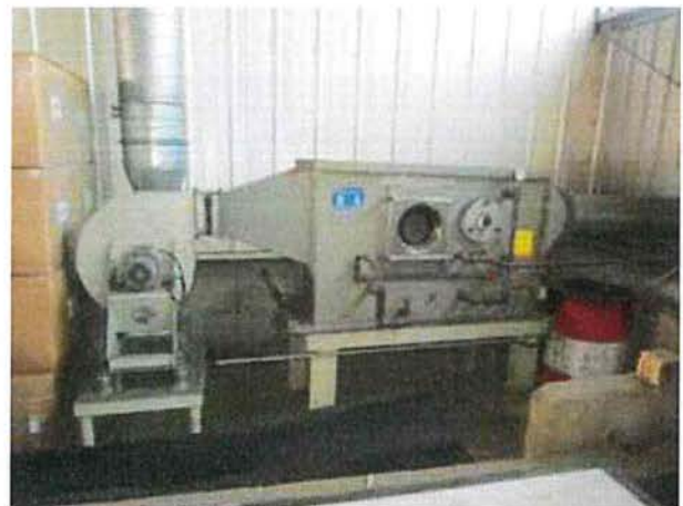
Abbruch Kalthalle: Lufttechnische Anlage (Radialventilator mit Befeuchter)
