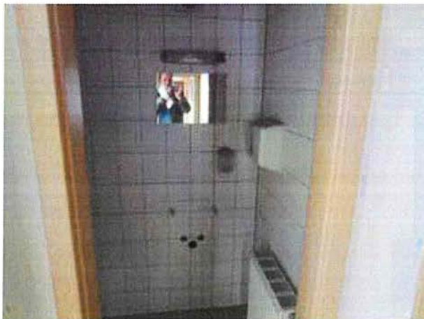
Containermodul-Sanitärtrakt: mit demontierten Sanitäreinrichtungen
