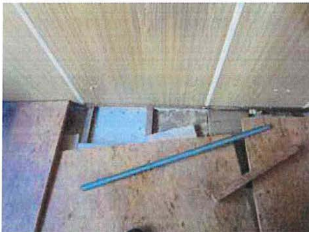
PP 1-Fußboden: Holzbelag mit Styroporeinlage
