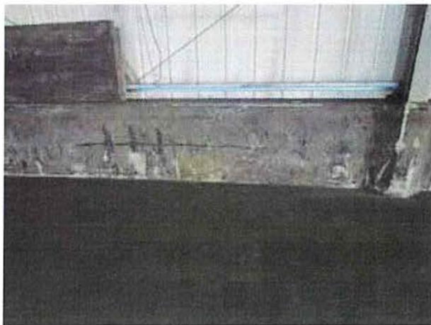
Prüfpunkt PP 6 (Kalthalle, Hallenwand, Innenseite West) Trapezblech einfach, ohne Dämmung
