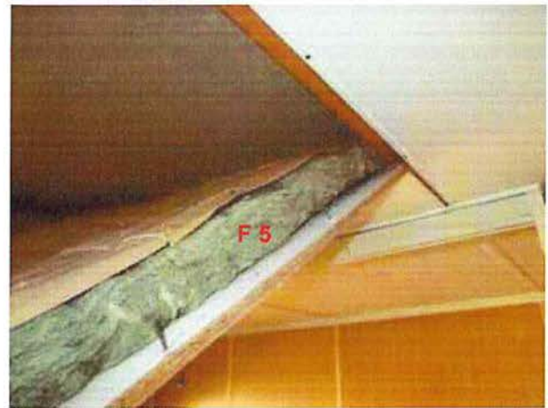
PP 1-Aufbau Decke: Spanplatte, Miwo-Dämmung mit WHO-Faseranteil (Probe F 5), Hartfaserplatte, Dachkonstruktion
