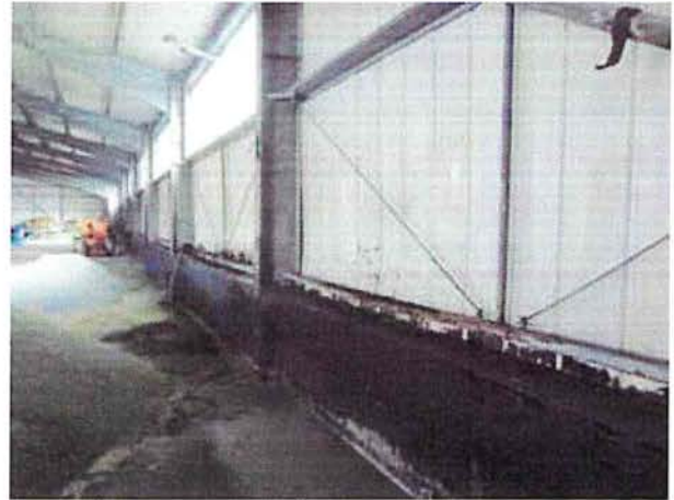
Halle 2 – Betonsockel Hallenwand (umlaufend) mit Beschichtung
