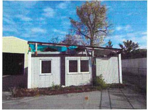
Containermodul: Ansicht Südseite
