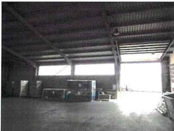
Abbruch Kalthalle Achse 9-13: Ansicht Hallenkonstruktion Ost mit Einfahrtsbereich
