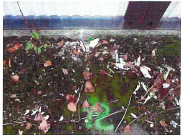
Probenahmebereich BS 2 (Streifenfundament Nordseite)
