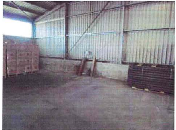
Abbruch Kalthalle Achse 9-13: Betonsockel Hallenwand (umlaufend)
