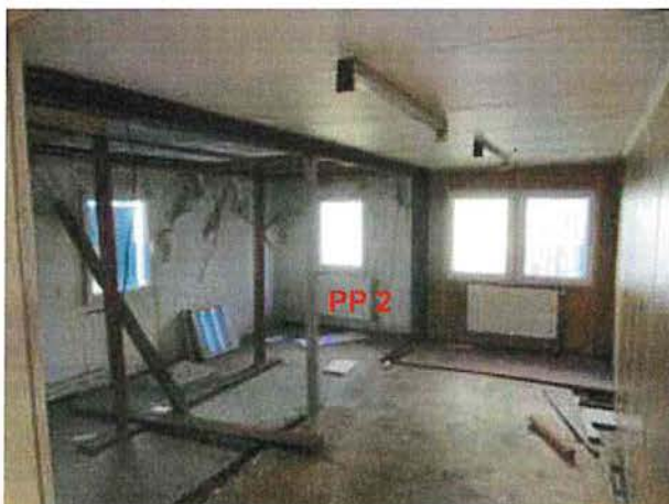
Prüfpunkt PP 2-Containermodul: Dämmung/Aufbau Außenwand
