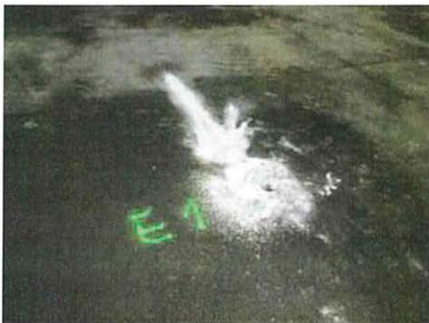
Bereich Ansatzpunkt Kernbohrung KB E 1 (Hallenfußboden)
