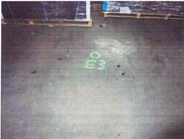
Bereich Ansatzpunkt Kernbohrung KB E 3 (Hallenfußboden Kalthalle)
