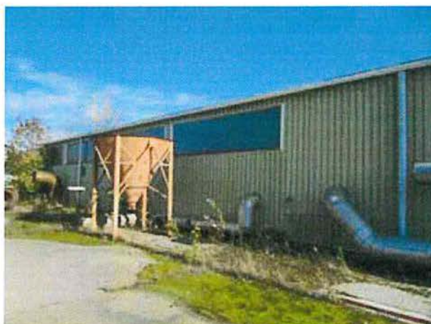
Hallenrückseite: Demontage lufttechnische Anlagen der Hallenbelüftung
