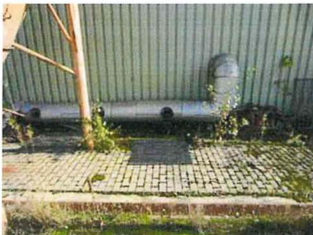
Probenahmebereich Probe F 4, (Hallenaußenseite West), Rohrleitungsbestand Luftabsaugung
