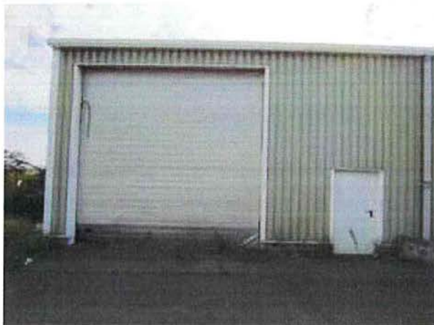
Halle 2 – Hallenzufahrt mit Tor (Westseite)
