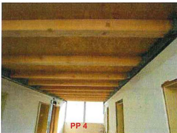
Prüfpunkt PP 4-Gangbereich: Dämmung/Aufbau Außenwand
