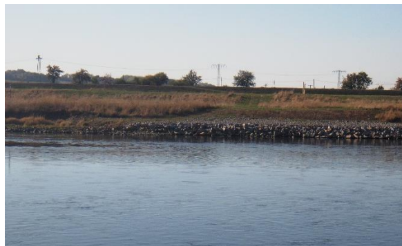
Abbildung 8.3-2: westliches Elbufer mit Steinschüttung, INROS LACKNER SE 2018
