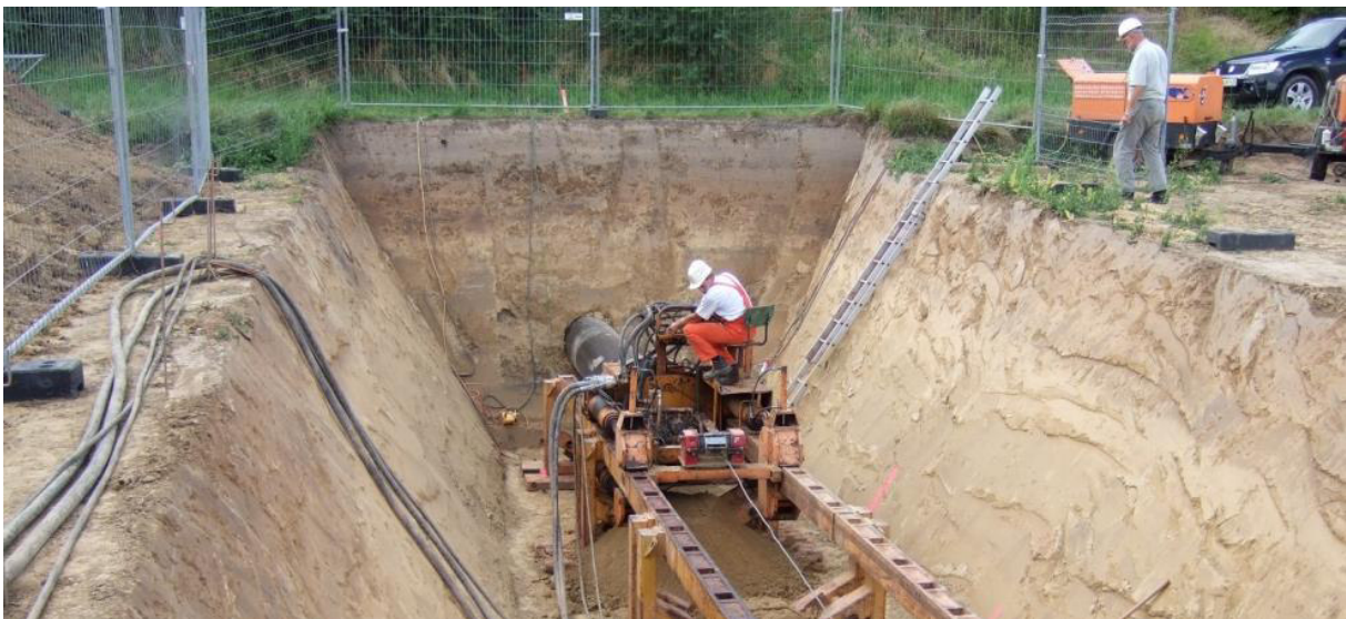
Abbildung 2-3: Horizontal-Pressbohrverfahren (Startgrube)
