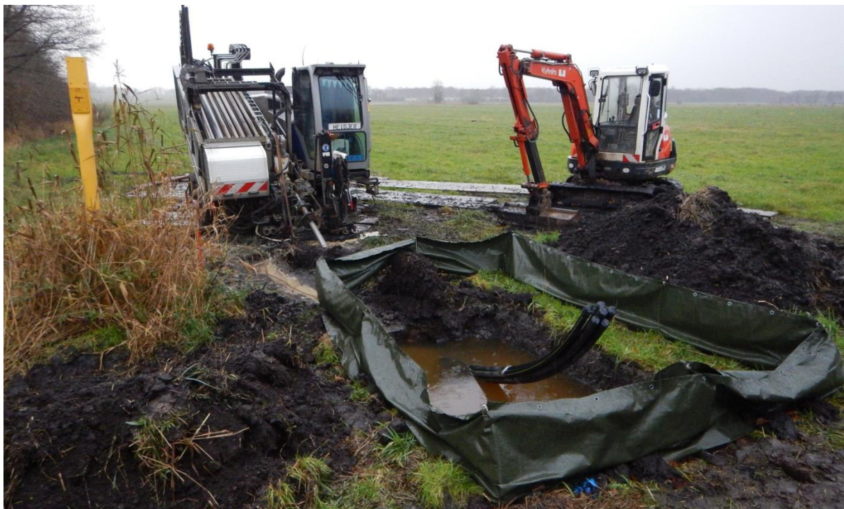
Abbildung 2-8: HDD-Rig zur Kabelverlegung
