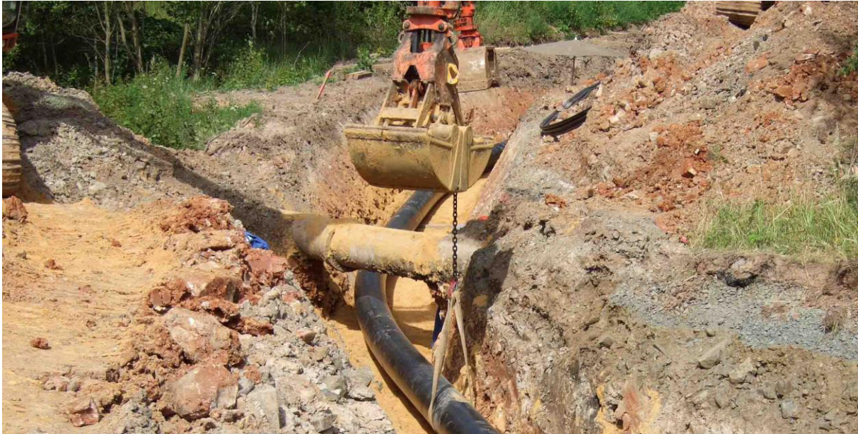
Abbildung 2-2: Offene Kreuzung eines verrohrten Grabens
