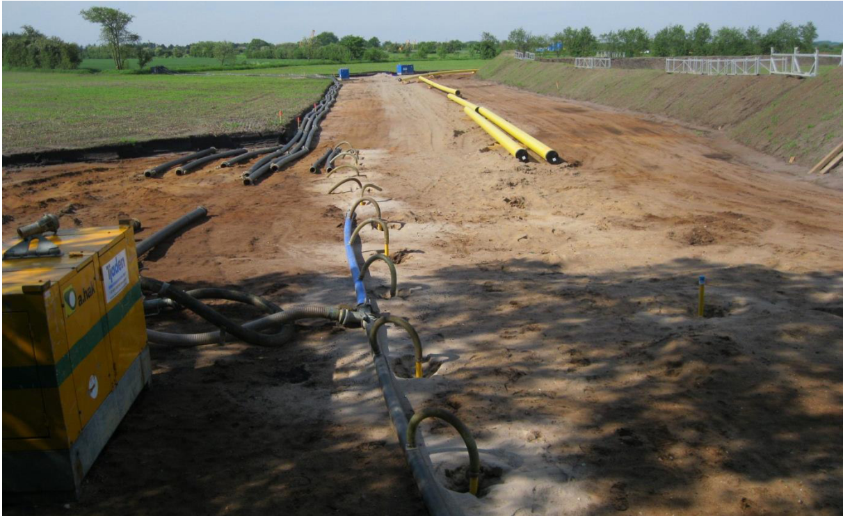
Abbildung 2-1: Wasserhaltung mit Spülfiltern
