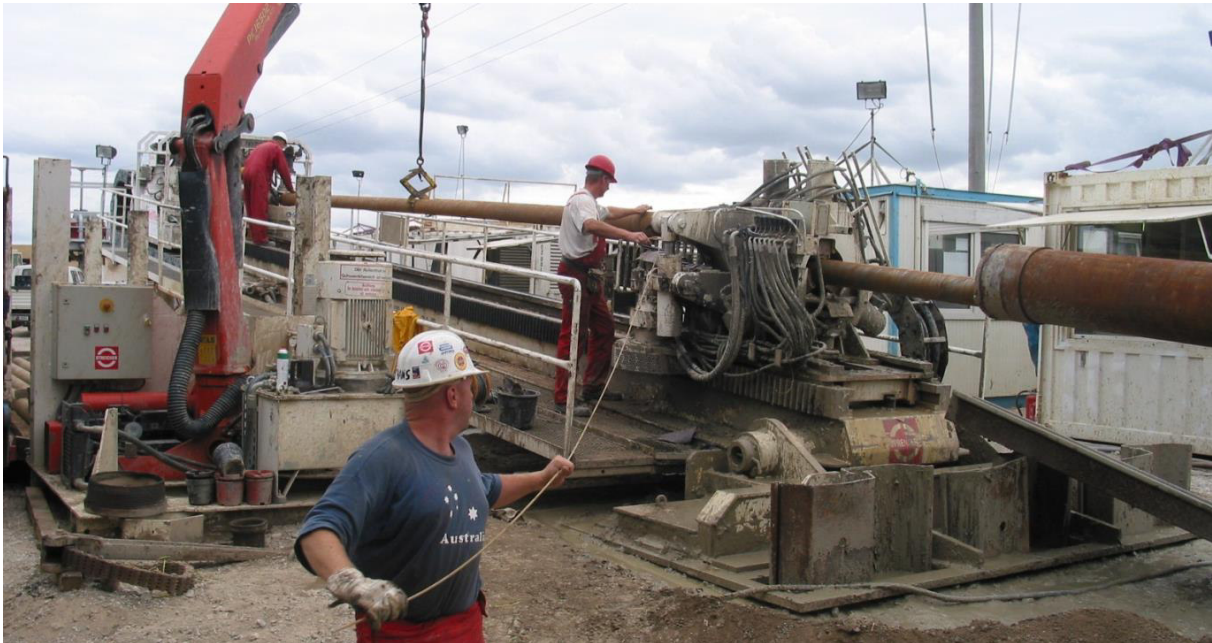
Abbildung 2-4: Bohrgerät für HDD-Verfahren
