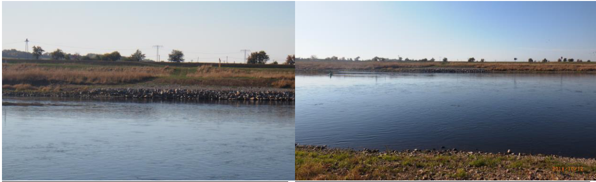
Abbildung 6.2-3: westliches Elbufer mit Steinschüttung, INROS LACKNER SE 2018
