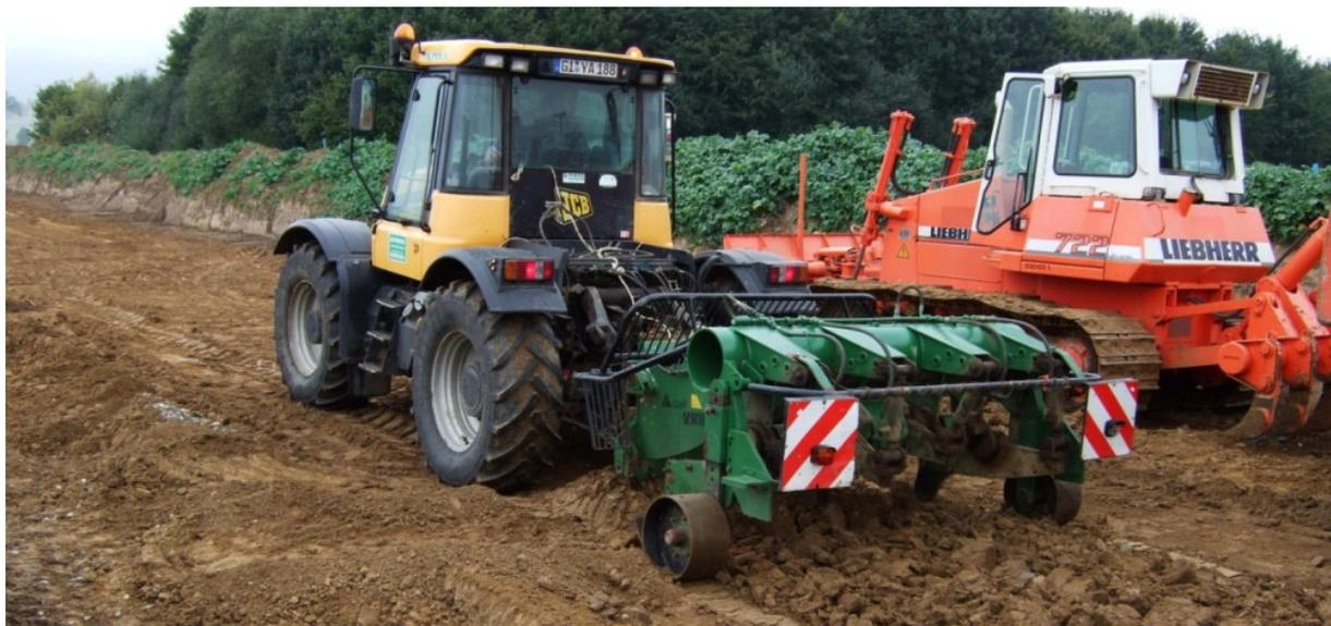
Abbildung 5.4-12: Lockerung des Unterbodens
