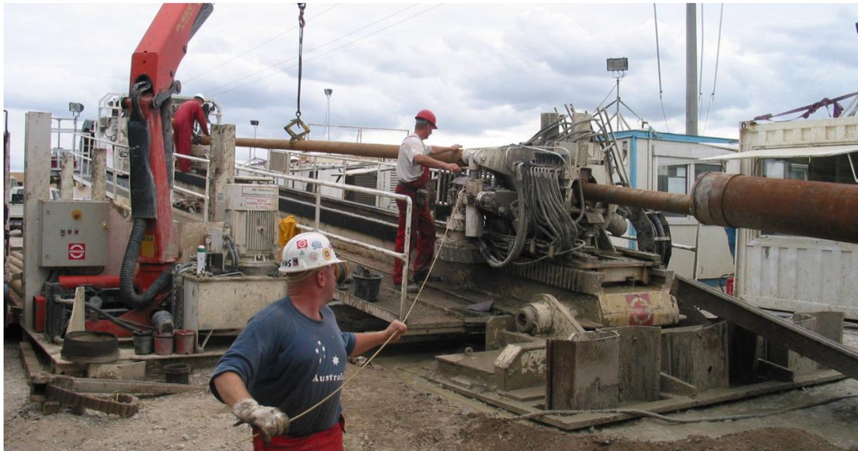
Abbildung 5.7-3: Bohrgerät für HDD-Verfahren
