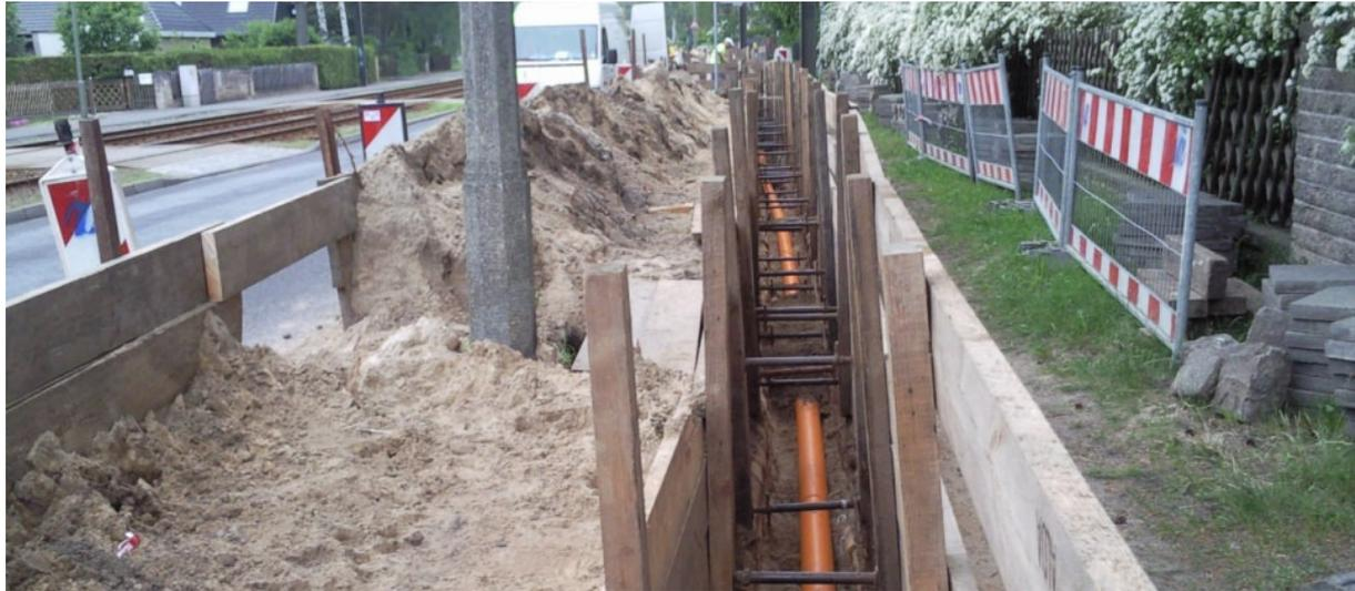
**Abbildung 5.5-2: Aushub mittels Bohlen, eingekastelt**
