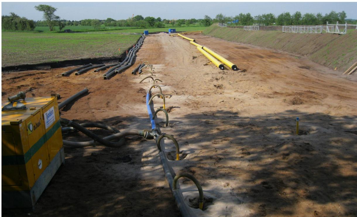
**Abbildung 5.4-3: Wasserhaltung mit Spülfiltern**
