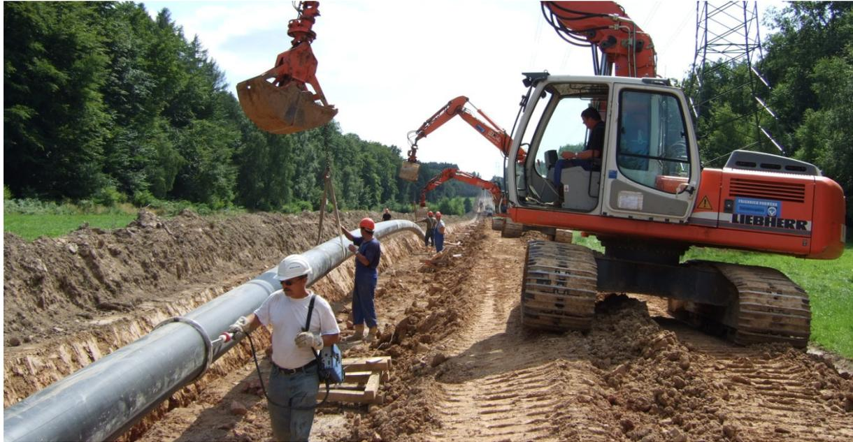
**Abbildung 5.4-8: Absenken des Rohrstranges und Isotest**
