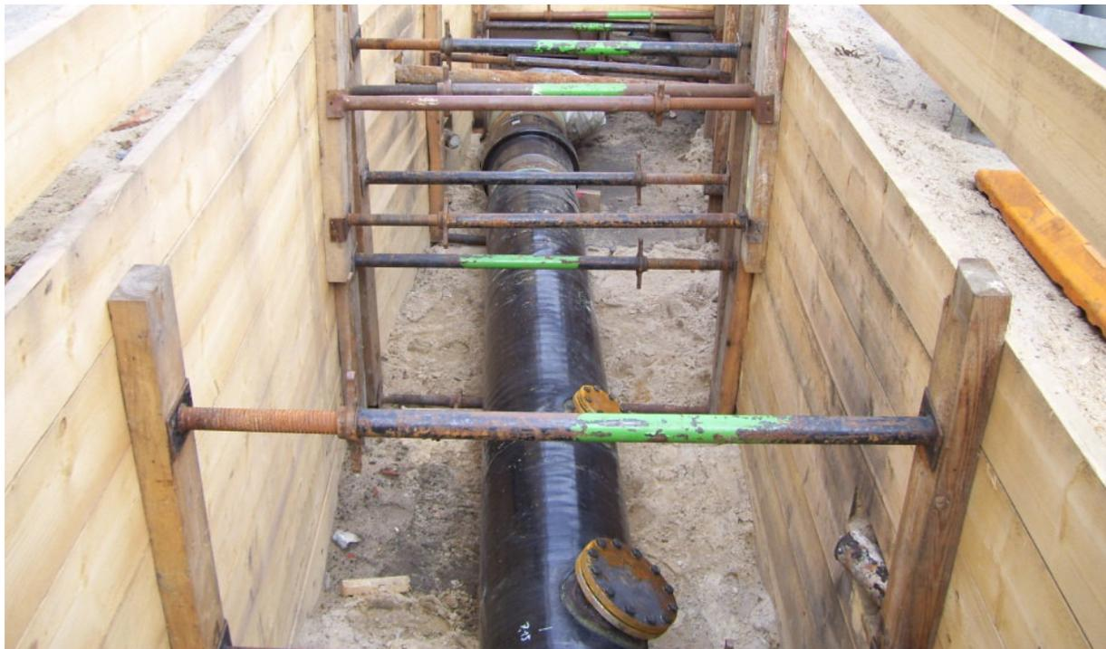
**Abbildung 5.5-1: verbauter Rohrgraben**
