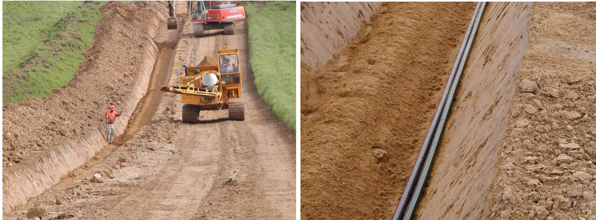
Abbildung 5.4-10: Verfüllen des Rohrgrabens
