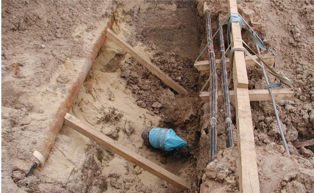
**Abbildung 5.6-1: Sicherung von Fremdleitungen (Kabel)**
