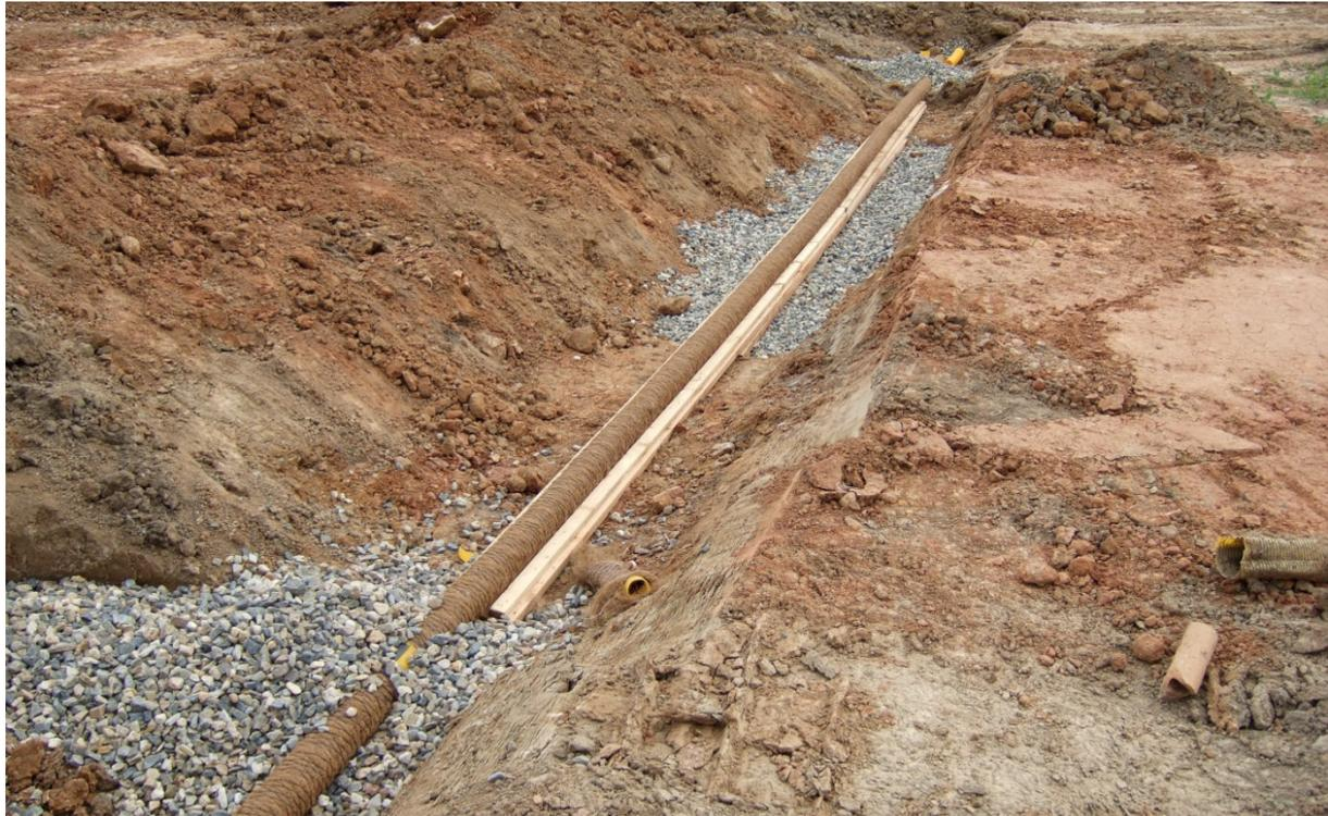
Abbildung 5.4-11: Wiederherstellung einer Dränanlage
