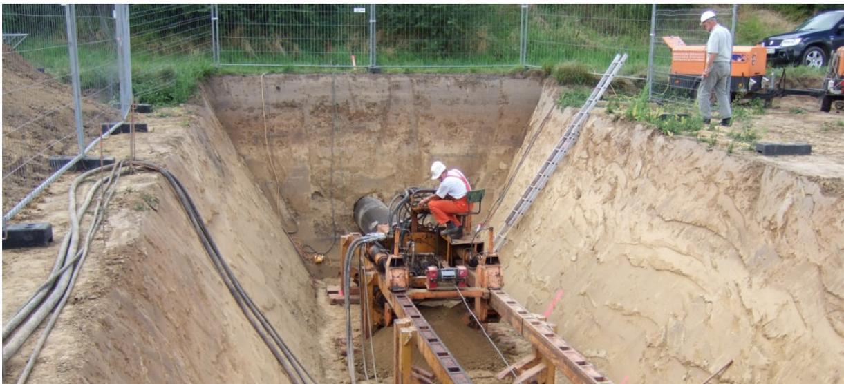
**Abbildung 5.7-2: Horizontal-Pressbohrverfahren (Startgrube)**
