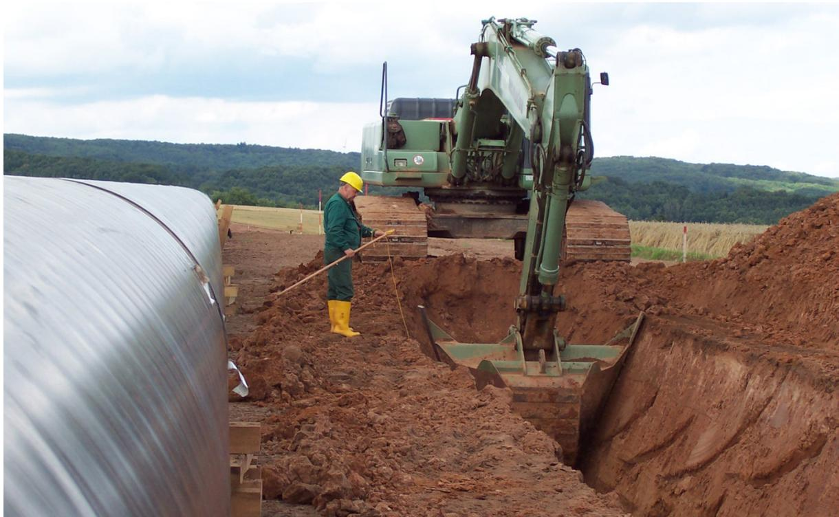
**Abbildung 5.4-7: Herstellung des Rohrgrabens**
