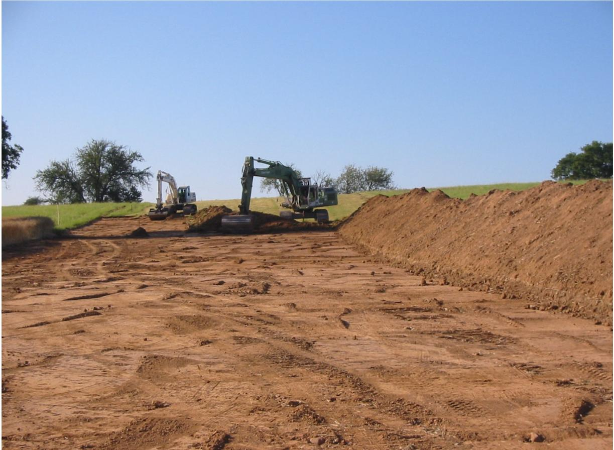
Abbildung 5.4-2: Mutterbodenabtrag
