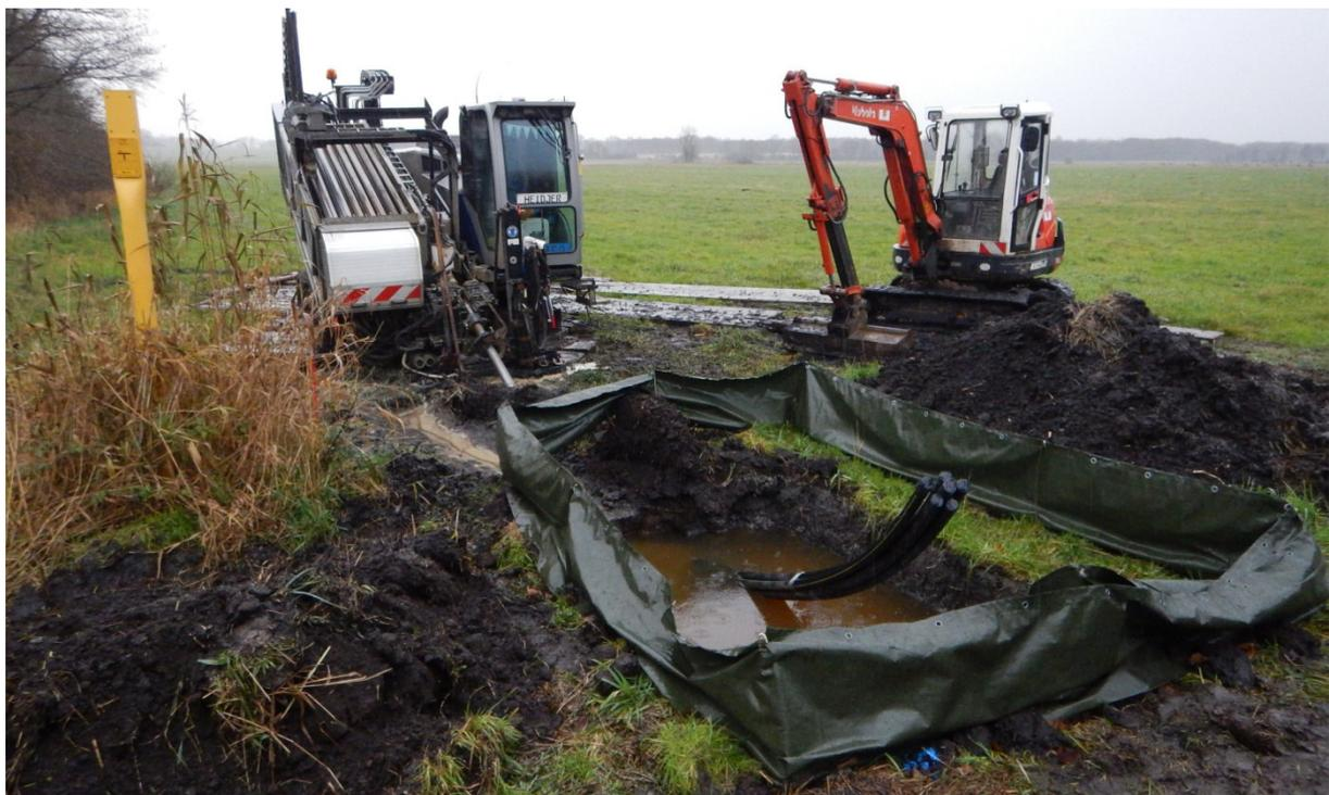
**Abbildung 5.7-7: HDD-Rig bei der Kabelverlegung**
