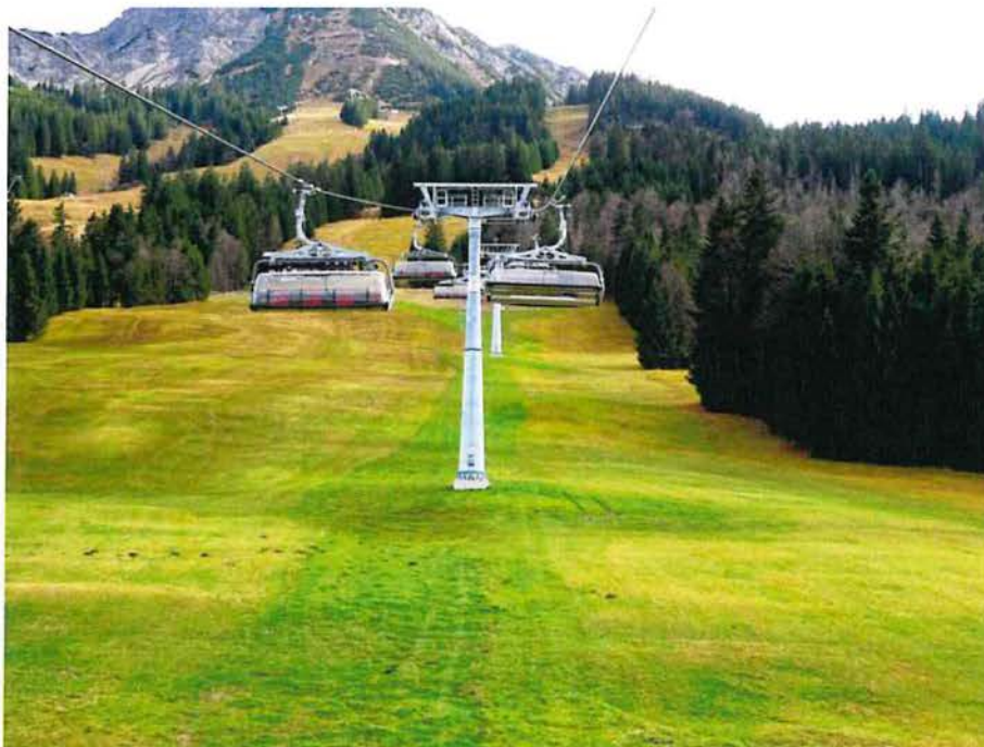
Abbildung 15: Kuppelbare Achtersesselbahn Skigebiet Oberjoch im Jahr der Baumaßnahme (Schweiger)
