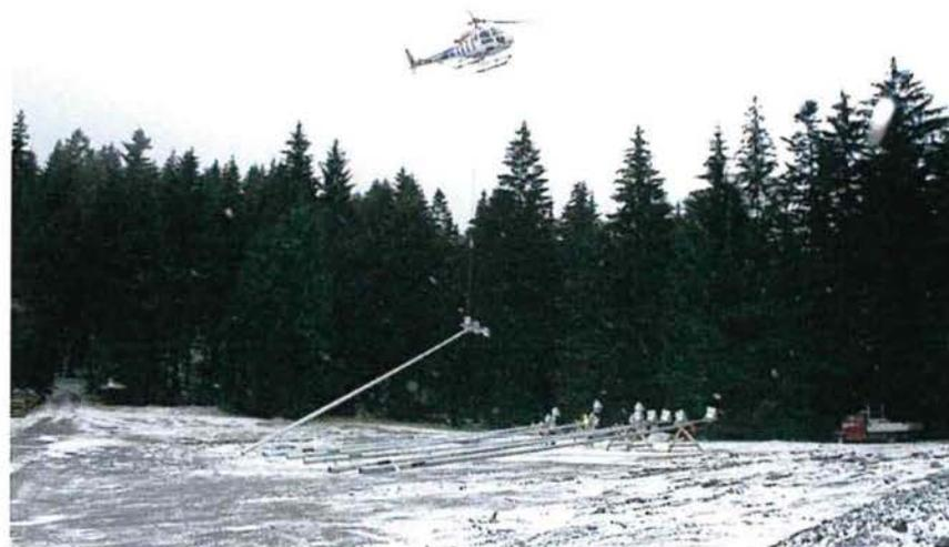
**Abb. 29: Montage Beleuchtungsmasten mit Hubschrauber**
