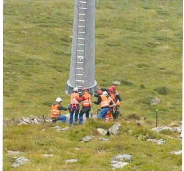
**Abb. 28: Stützmontage mit Hubschrauber, Montage am Boden**
