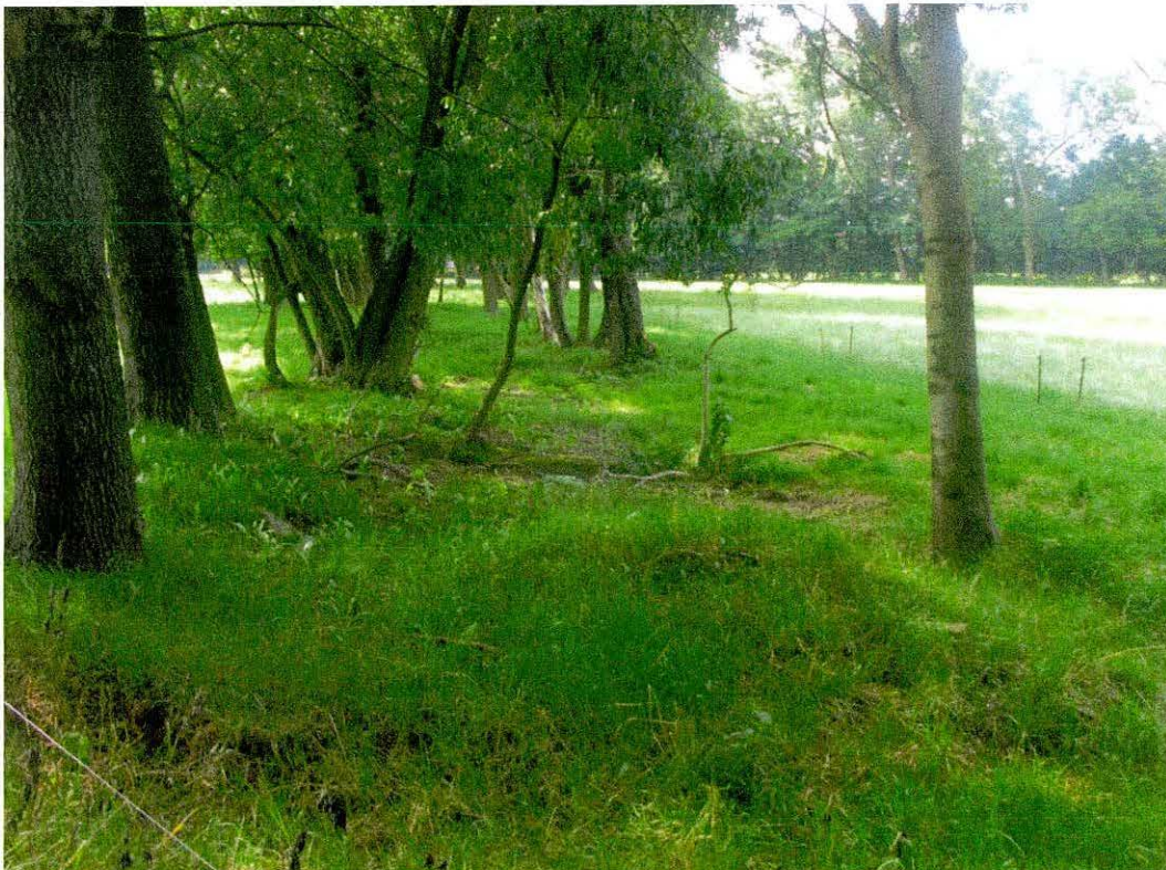
Abbildung 16: Zur Offenlegung vorgesehener Mühlgrabenabschnitt westlich der S 81
