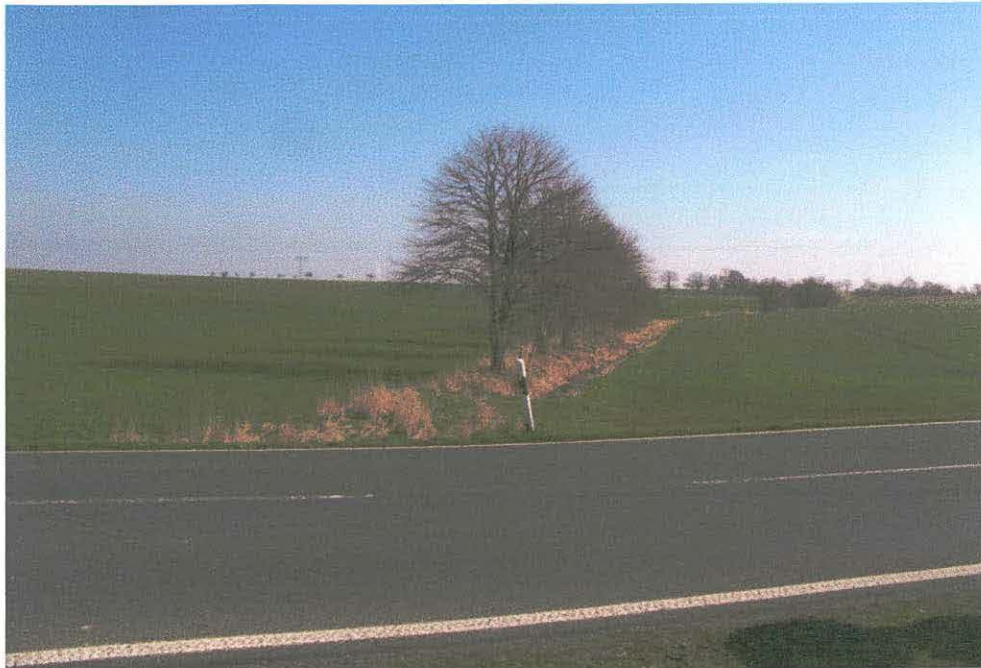
Abbildung 2: Graben mit Rasenböschung (213-5) gegenüber der Tankstelle in Zschautitz
