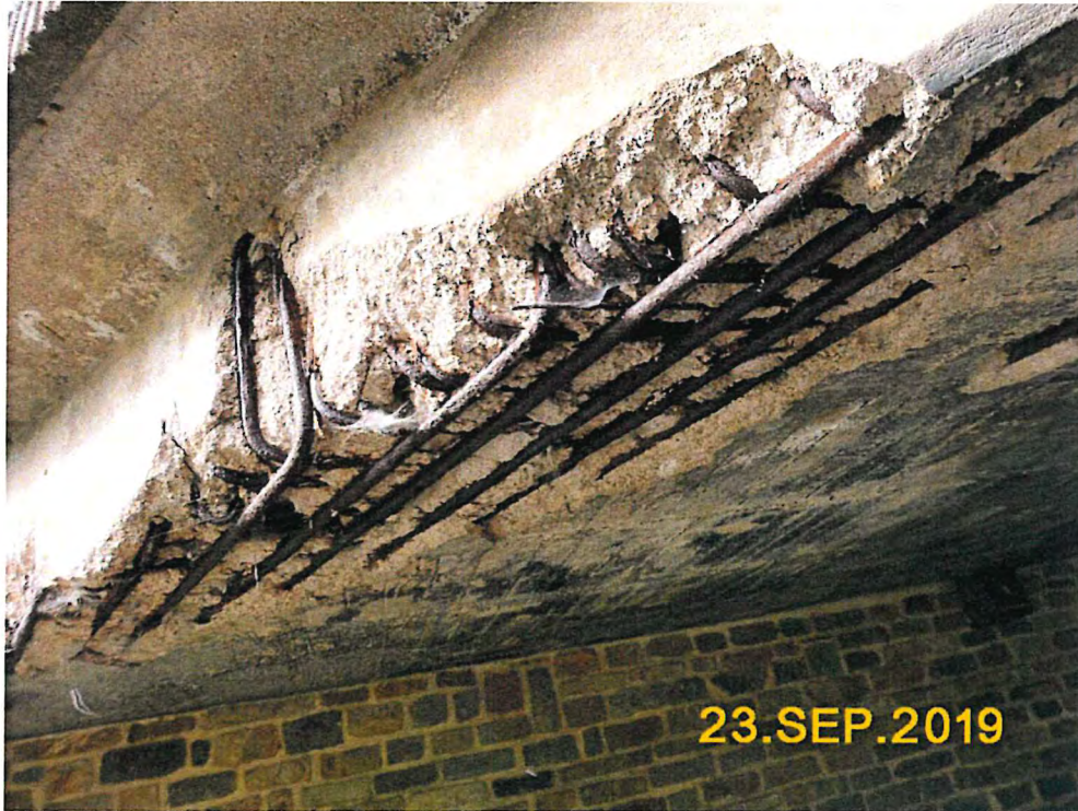
BILD 06 - ZUSTAND DER STAHLBETONPLATTE OBERSTROMIG
