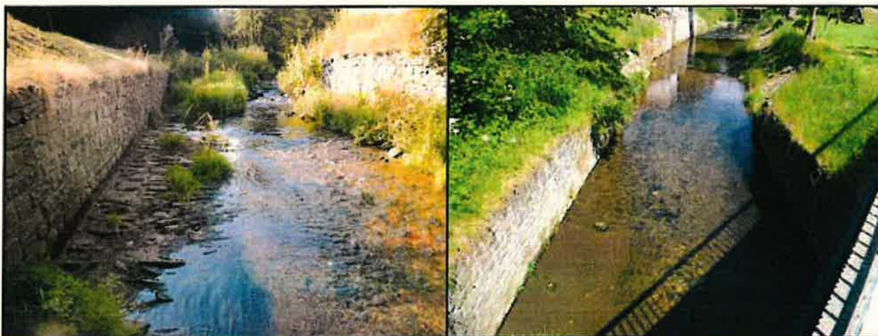
Abbildung 2: Ansicht oberstrom (linkes Foto, 31.07.2018) und unterstrom (rechts, 27.06.2016) mit Ufer- und Sohlbefestigungen im Bereich des Brückenbauwerkes und des Pegels.
