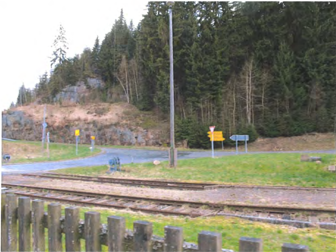
Abbildung 4 Foto Bahnanlage mit Fichtenforst
