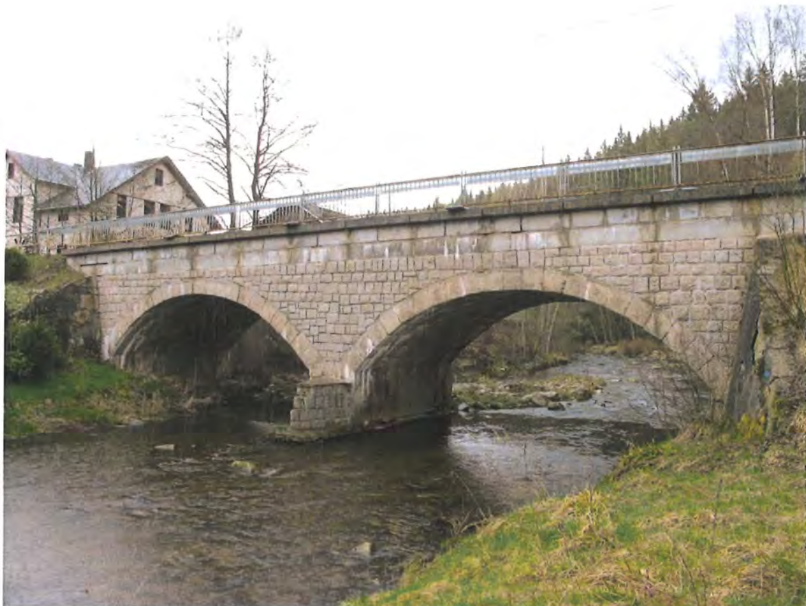
Abbildung 9 Foto Brücke Bw 5 in Wilzschhaus
