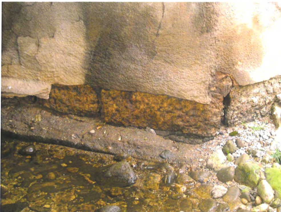
25 - PFEILERWAND IM FELD 1, RECHTER RAND, KOLKSCHUTZ ZERSTÖRT
