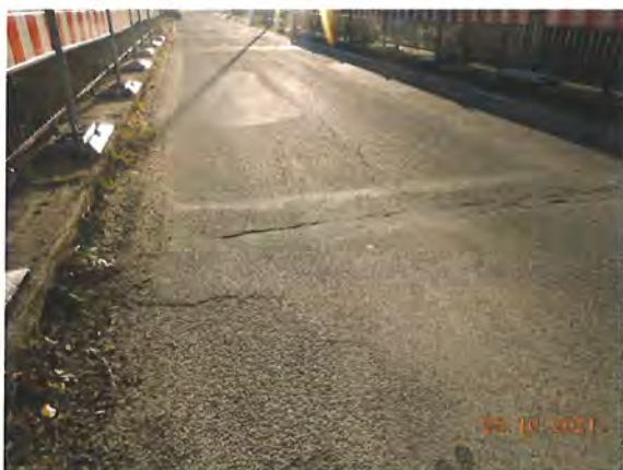
2021E-12-FAHRBAHNSCHÄDEN-ENTWÄSSERUNG BEHINDERT
