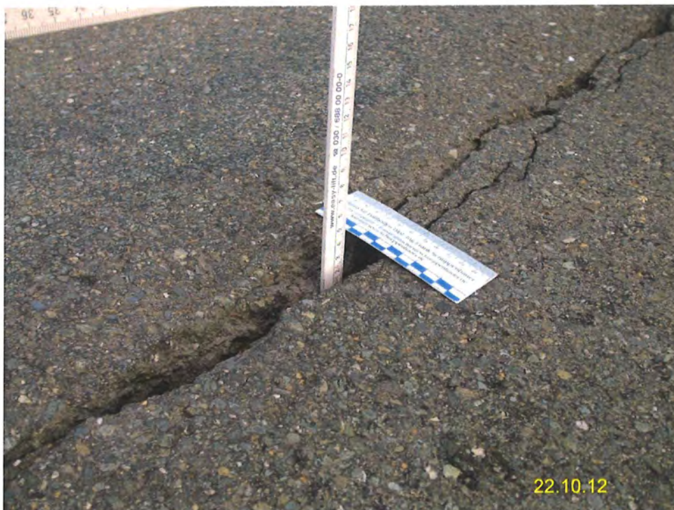
2012H_DETAIL QUERRISS FAHRBAHN VORN
