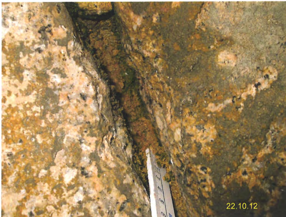
2012H_DETAIL FM STIRNKRANZMAUERWERK MÜRBE
