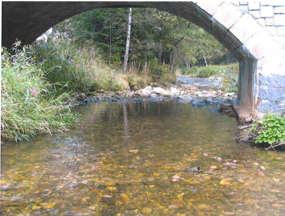
12 - DURCHFLUSSQUERSCHNITT IM FELD 2, BEHINDERTER WASSERABLAUF
