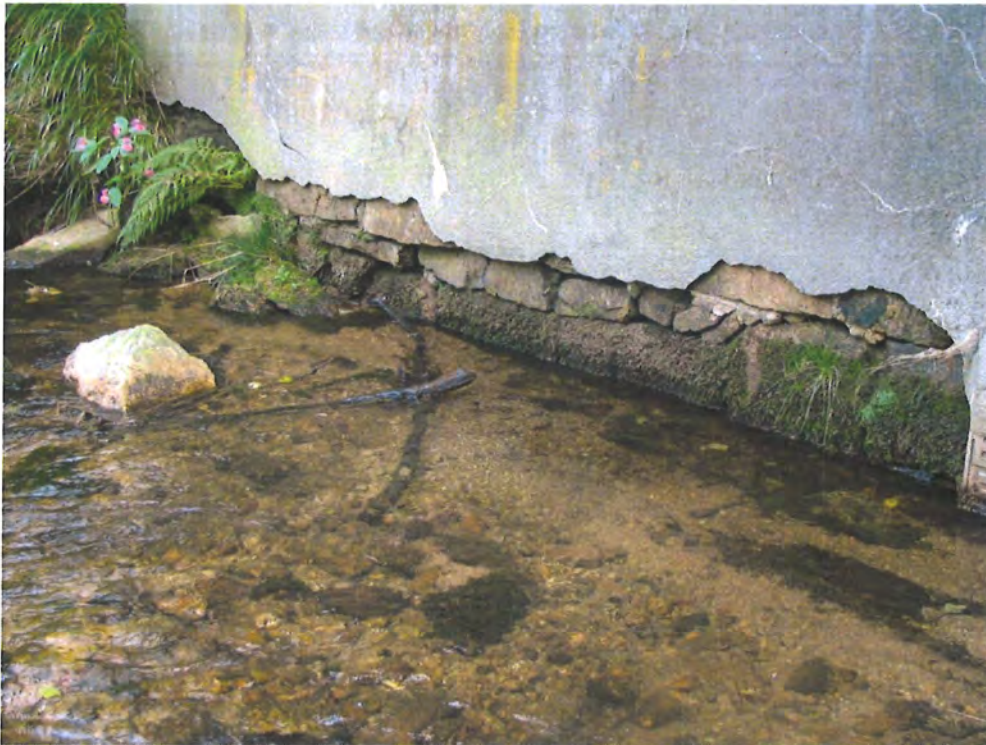
25 - PFEILERWAND IM FELD 1, RECHTER RAND, KOLKSCHUTZ ZERSTÖRT
