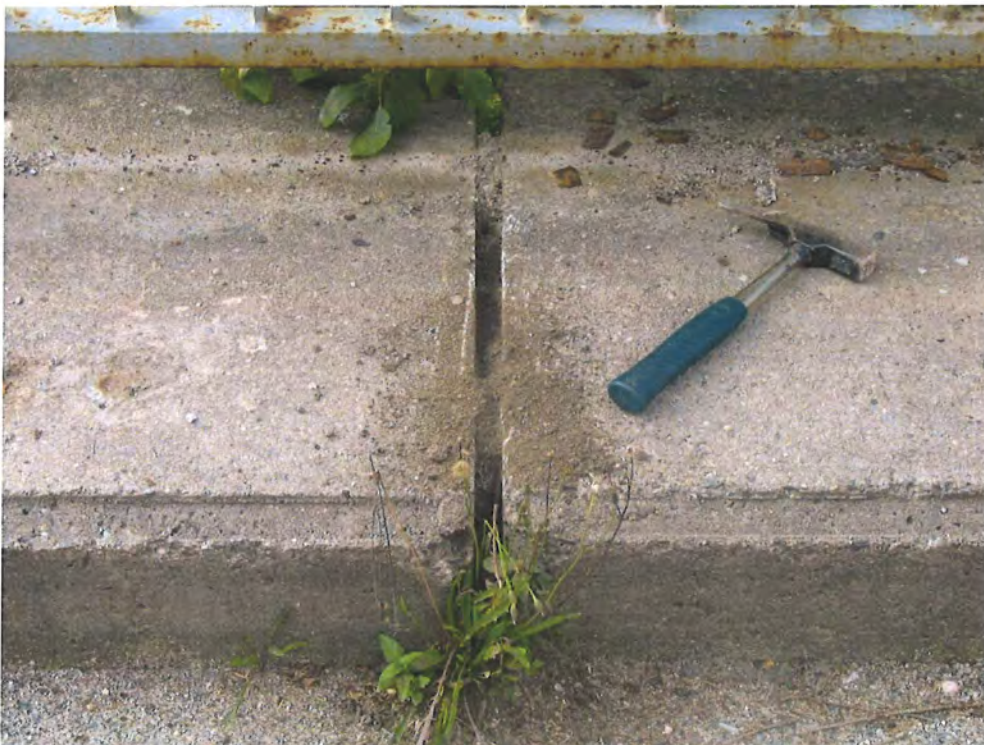
06 - FUGE ZWISCHEN DEN KAPPENFERTIGTEILEN 3 UND 4 LINKS, OHNE FÜLLMATERIAL
