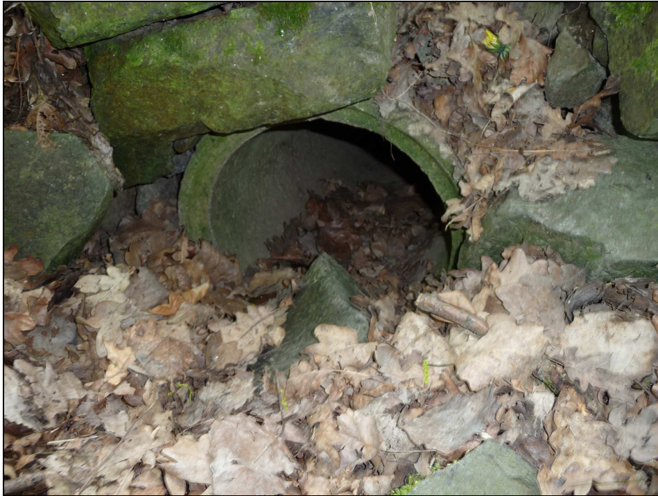
Abbildung 4: Rohreinlauf im südlichen Graben des Grenzweges
