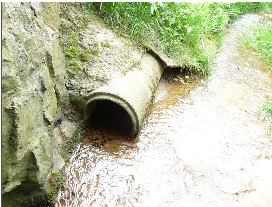
Abbildung 13: Auslauf einer Verrohrung DN 300 in den Krebsbach unmittelbar vor Durchlass B 178
