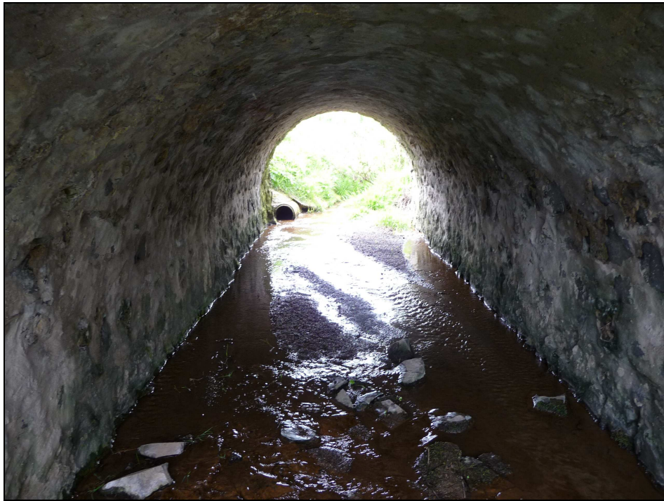
Abbildung 14: Gewölbedurchlass im Zuge der B 178, Durchleitung Krebsbach
