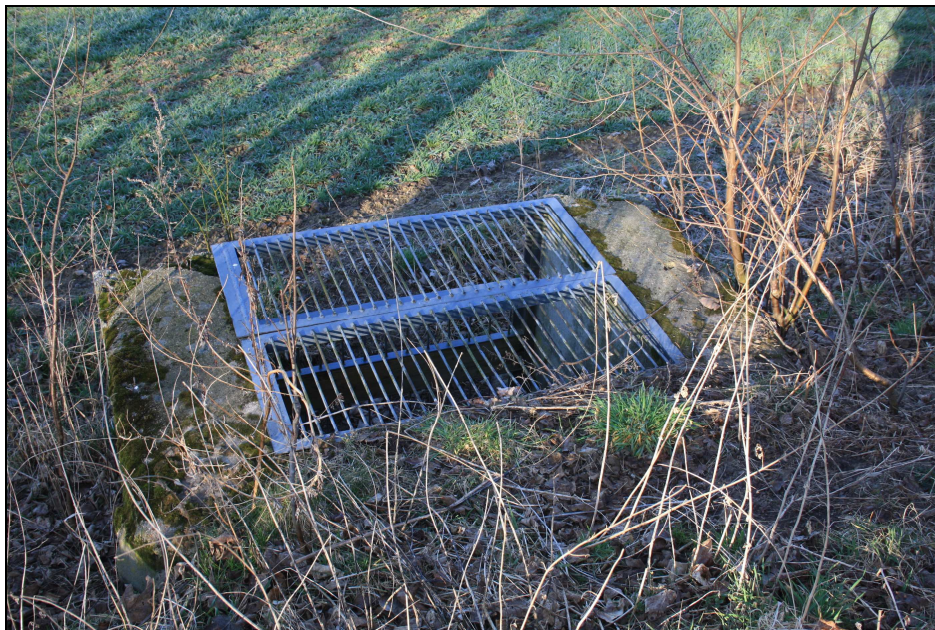
Abbildung 5: Einlaufbauwerk am Weg zum Steinberg
