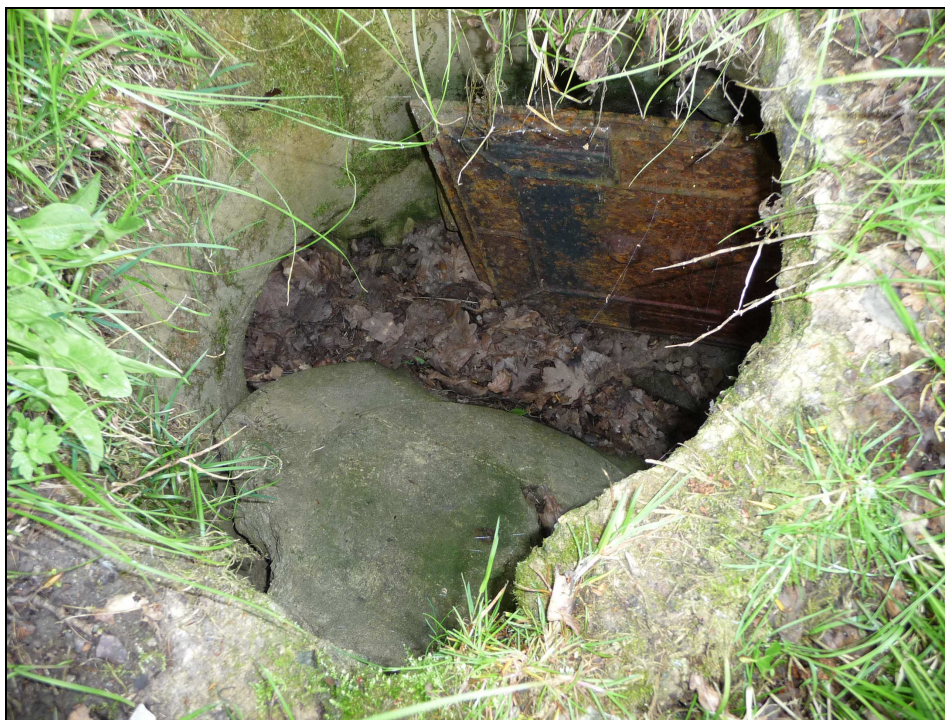
Abbildung 3: Einlaufschacht im nördlichen Graben des Grenzweges
