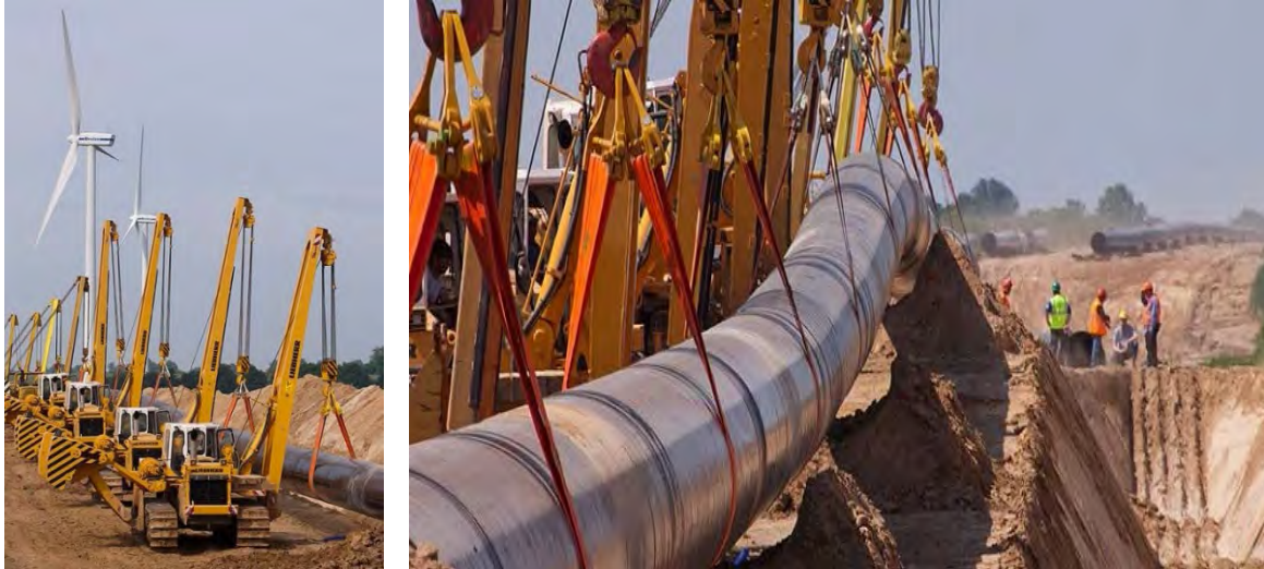
Abbildung 46: Absenken des Rohrstranges
