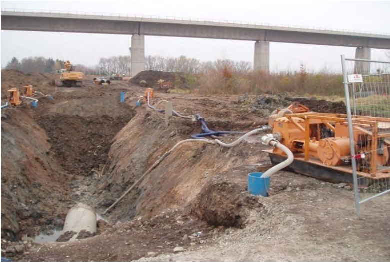
Abbildung 44: Wasserhaltungsmaßnahmen
