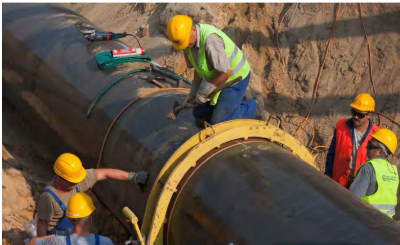
Abbildung 47: Verschweißen zweier Rohrstränge im Rohrgraben
