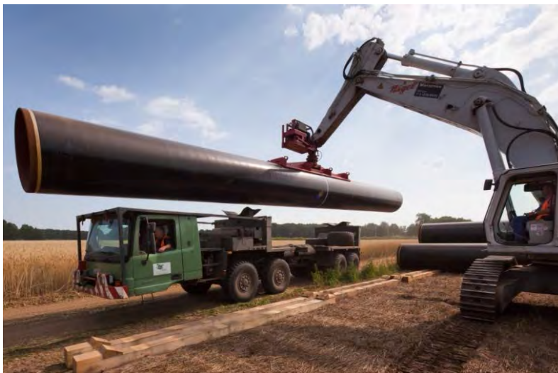
Abbildung 40: Ausfahren der Rohre auf die Trasse
