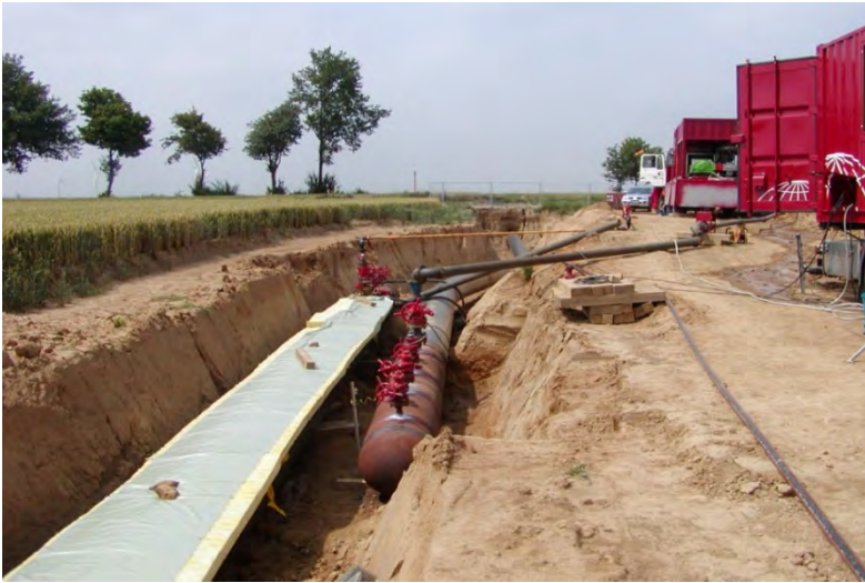
Abbildung 49: Wasserdruckprüfung
