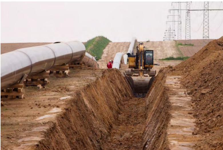
Abbildung 45: Ausheben des Grabens
