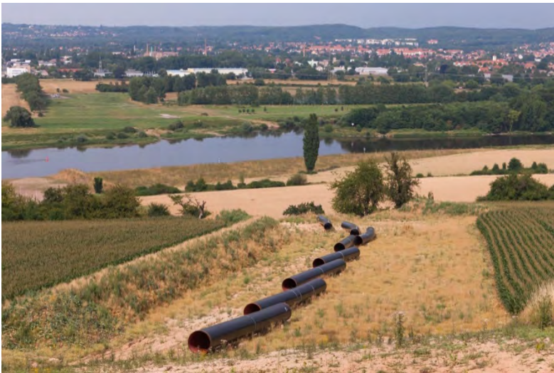
Abbildung 41: Aufreihen der Rohre im Trassenabschnitt
