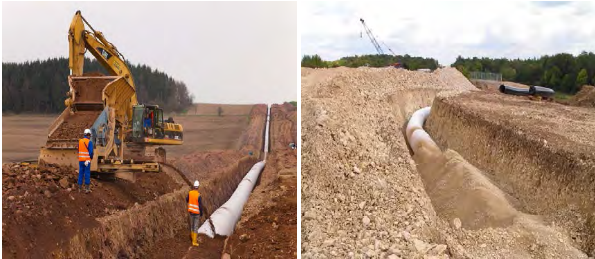
Abbildung 48: Teilverfüllung des Grabens
