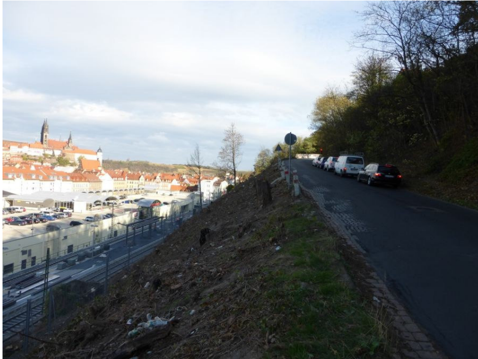
Bild 9: Blick auf übersteilte Böschung zur Bahn (Bau-km 0+245)
