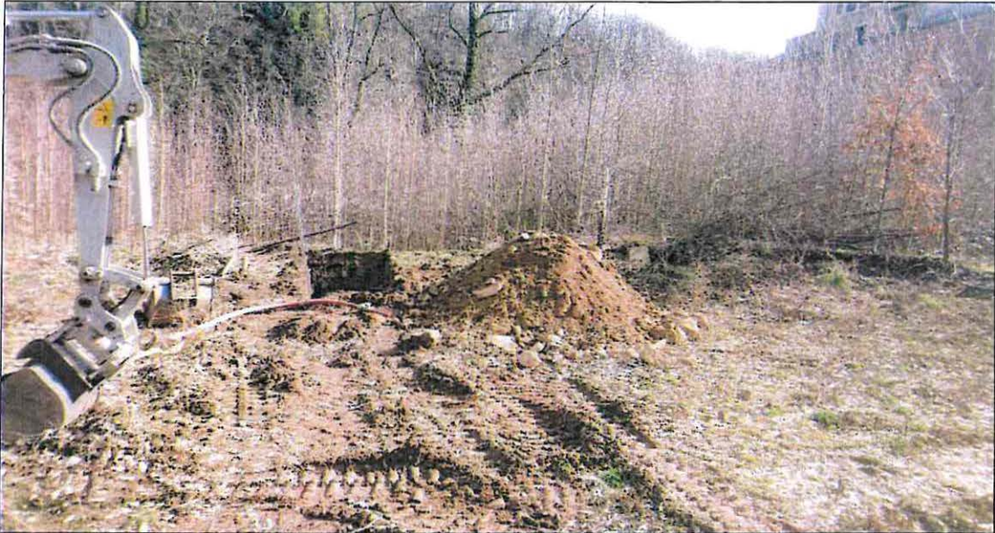
Bild 10 / 07.03.2019 / Blickrichtung Nordwest ⇒ Südost
