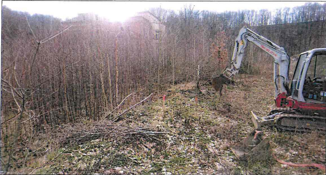
Bild 8 / 07.03.2019 / Blickrichtung Südost ⇒ Nordwest
