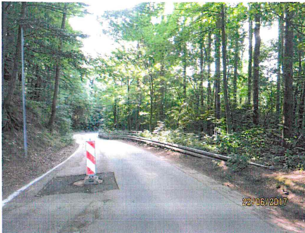
Bild 1: K 8215 Blick auf die geplante Ausbaustrecke aus Richtung Ortsrand Kriebstein talabwärts; beiderseits ausgewiesene FFH-Lebensraumtypen (links Hainsimsen-Buchenwald; rechts Schlucht- und Hangmischwald)
