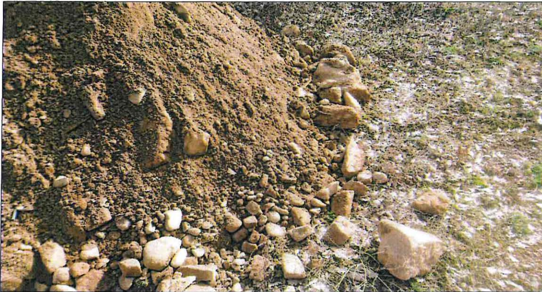
Bild 12 / 07.03.2019 / Blickrichtung Nordwest ⇒ Südost Aufschluss Baggerschurf 201-SCH-VS für Versickerungsversuch / Rückverfüllung Schurf und Wiederherstellung Geländeoberfläche nach Abschluss der Felduntersuchung
