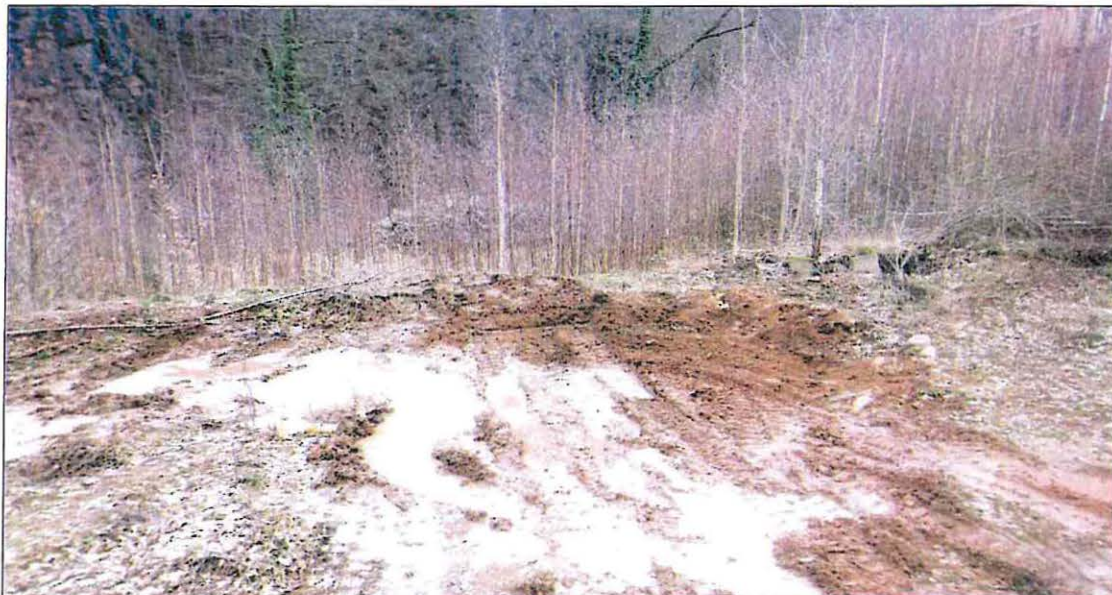
Bild 12 / 07.03.2019 / Blickrichtung Nordwest ⇒ Südost Aufschluss Baggerschurf 201-SCH-VS für Versickerungsversuch / Rückverfüllung Schurf und Wiederherstellung Geländeoberfläche nach Abschluss der Felduntersuchung
