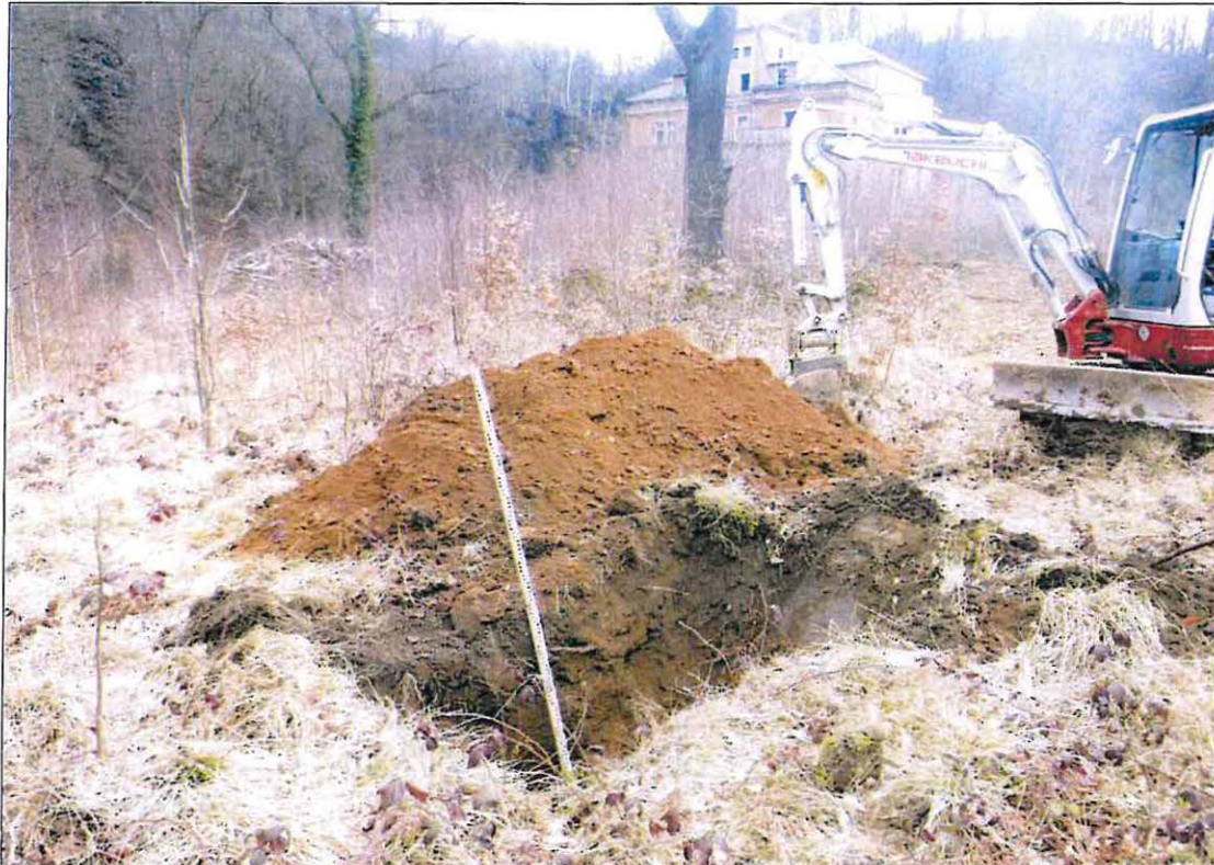
Bild 20 / 08.03.2019 / Blickrichtung Nordwest ⇒ Südost
