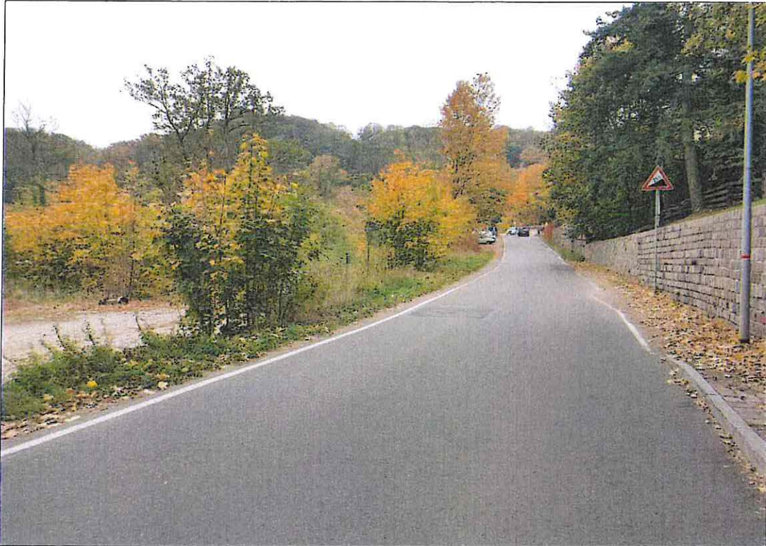
Bild 2 / 15.10.2018 / Blickrichtung Südost ⇒ Nordwest
