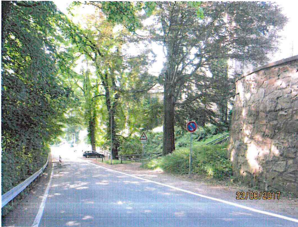
Bild 5: K 8215 unterhalb der Burg mit drei zu erhaltenden Altbäumen
