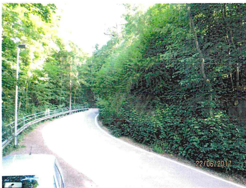
Bild 2: Blick auf die Ausbaustrecke der K 8215 von der Zufahrt zum Burggarten in Richtung Kriebstein; links der Straße Schlucht- und Hangmischwald, rechts der Straße stark überwachsene Felsböschungen
