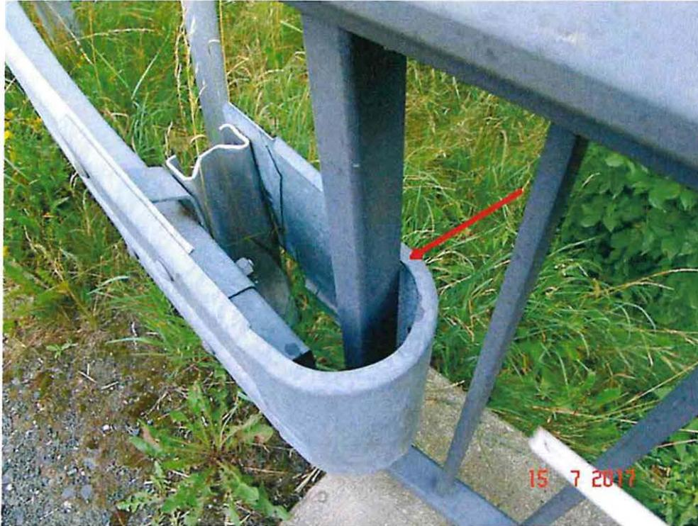
2017H 09 - LINKES GELÄNDER PFOSTEN 6 - KORRODIERT
