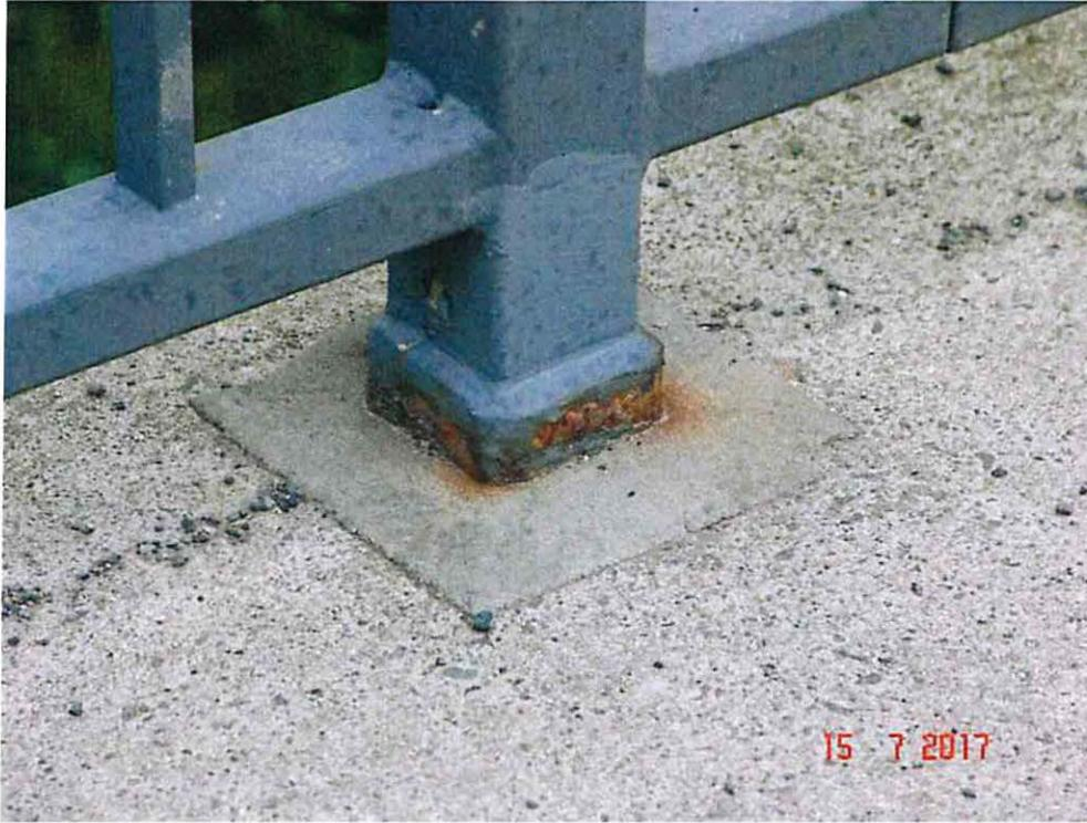
2017H 09 - RECHTES GELÄNDER PFOSTEN 5 - KORRODIERT
