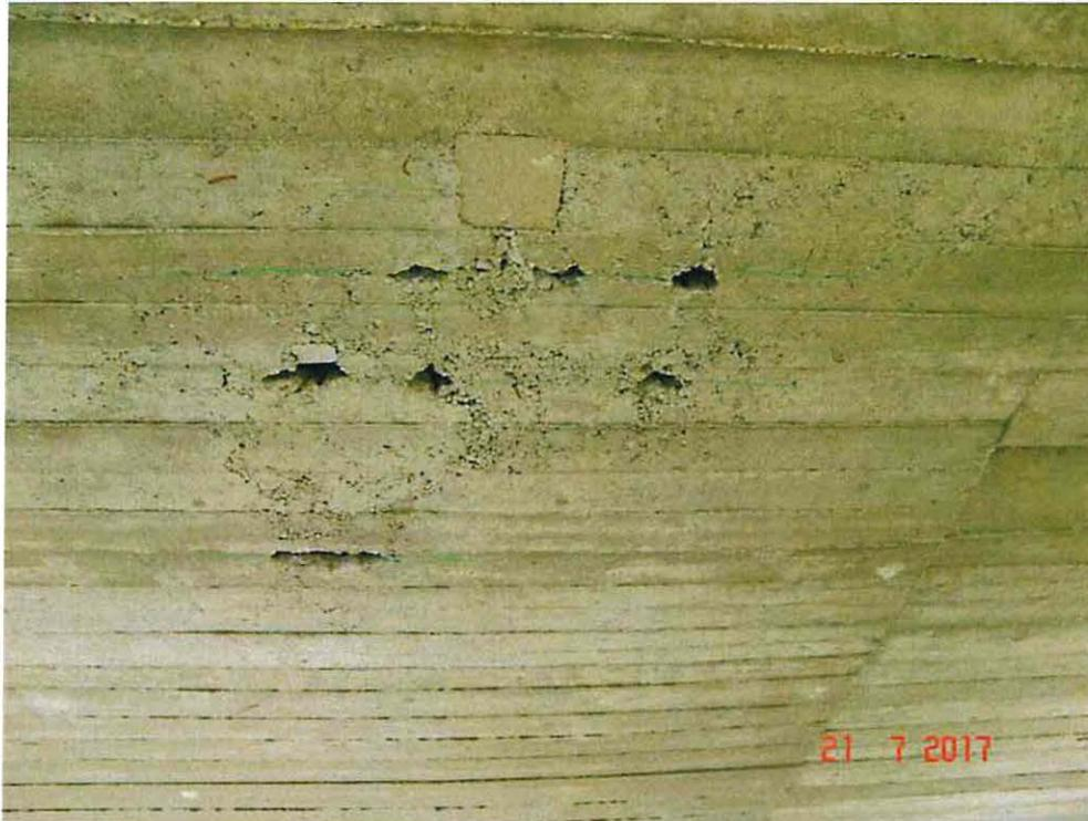
2017H 02 - KRAGARMUNTERSEITE - SANIERUNG SCHADHAFT
