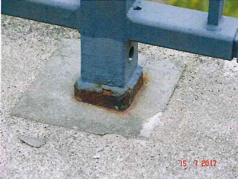
2017H 09 - RECHTES GELÄNDER PFOSTEN 2 - KORRODIERT
