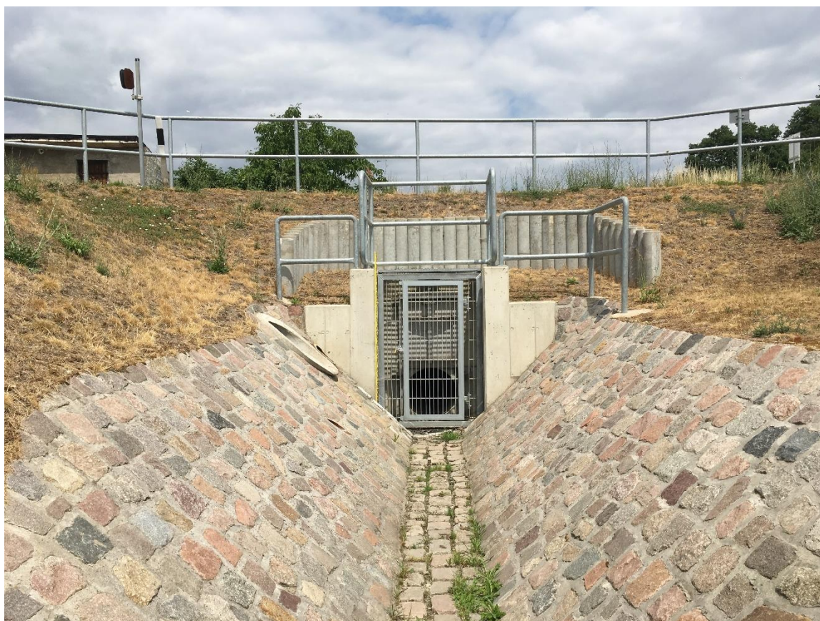
Abbildung 23: Siel mit und befestigter Grabeneinlauf, Blickrichtung zur Mulde
