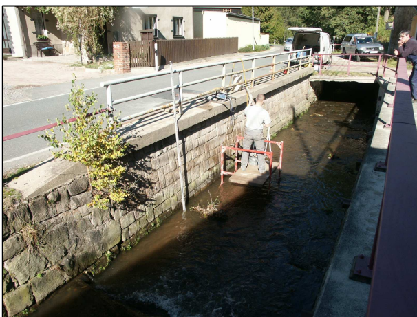
Abb. 3 Stützmauer, nördlicher Teil mit Kappe und Geländer
