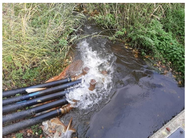
Abbildung 8: Einleitung von Wasser aus der Druckwasserprüfung und den Wasserhaltungsmaßnahmen über nach oben gerichtete Rohre (Foto: PLE)
