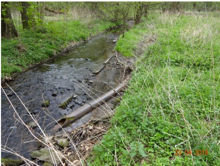
Blick auf die im Rahmen der Ausgleichsmaßnahme A 3 zurückzubauende Uferbefestigung und Drainageleitung oberhalb des Brückenbauwerks G 2
