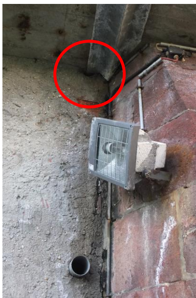
Bild: Widerlager West mit unklarem Rohrverlauf
