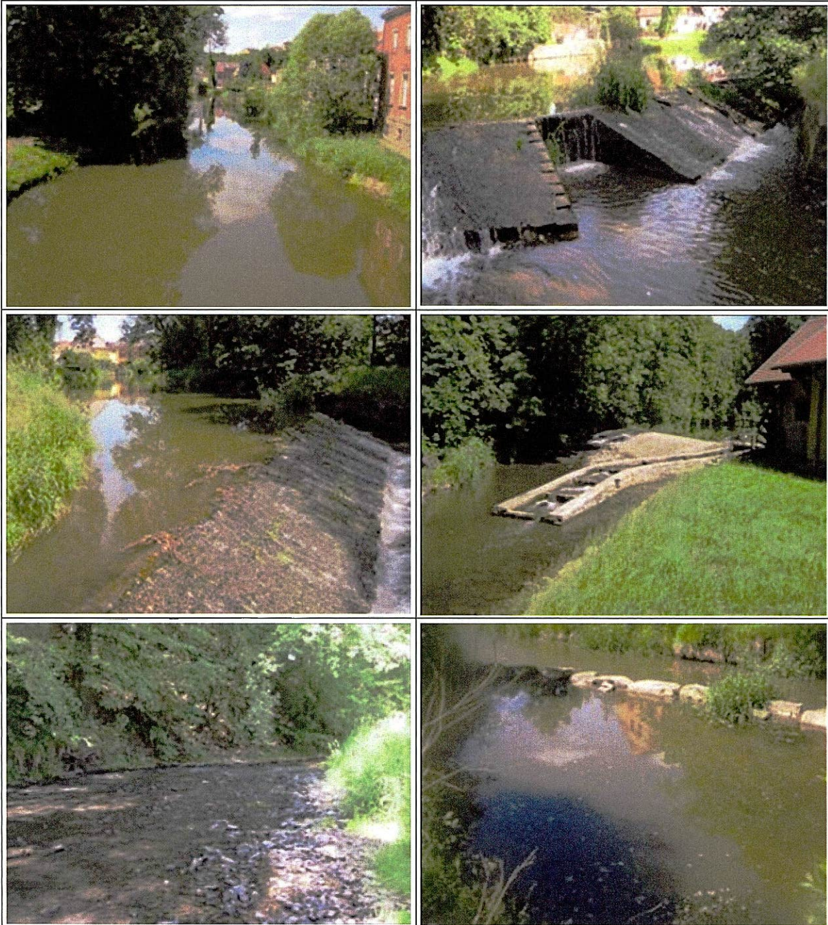
Abbildung 16: Löbauer Wasser Abschnitt 4 – Blick von der Brücke am Beginn des Abschnitts (o.l.), Querbauwerk an der Mittelmühle (o.r.), Sohlrampe ohne Fischaufstieg an der Mittelmühle (m.l.), Fischrampe an der Niedermühle (m.r.), Schnellfließender steiniger Abschnitt (u.l.), durch Steinblöcke vom Strom getrennter Bereich mit stehendem Wasser (u.r.)
