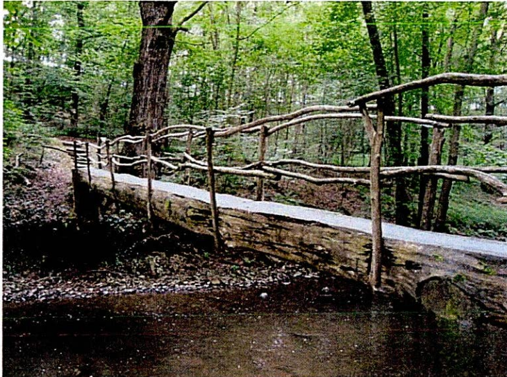
Foto 73: Gröditzter Skala im Bereich der Überführung des Wanderweges „Lausitzer Schlange“ über das Löbauer Wasser
