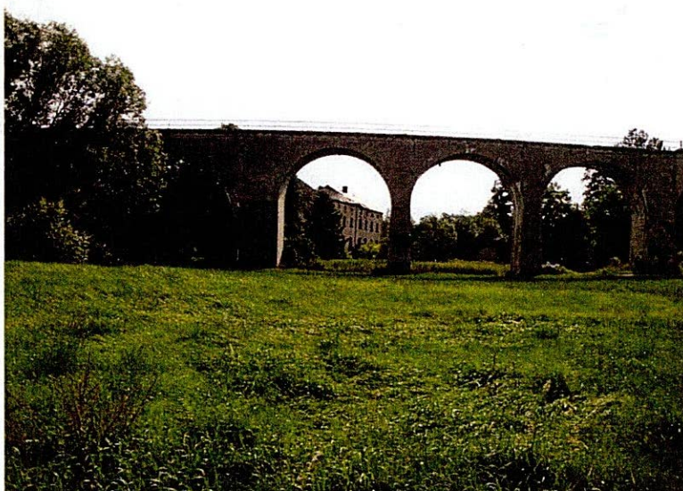
Foto 57: zehnbogiges, 170 m langes Gröditzter Viadukt der ehemaligen Bahnstrecke Löbau–Weißenberg–Radibor über die Talaue des Löbauer Wassers (im Hintergrund: Wuischker Mühle)
