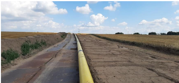
Abbildung 10: Vorgestreckter und verschweißter Rohrstrang
