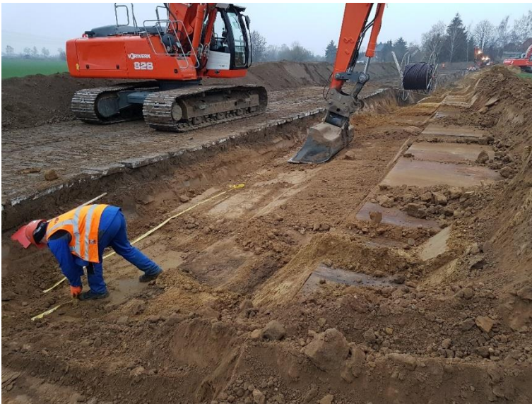
Abbildung 15: Rückverfüllung Rohrgraben und Verlegung Warnband
