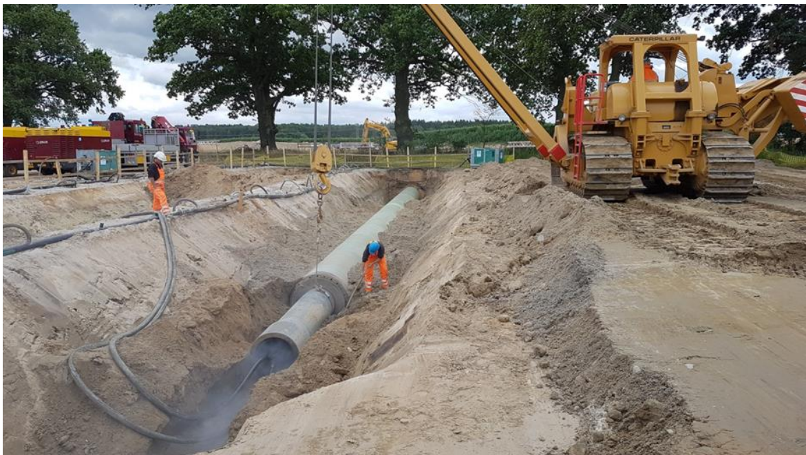
Abbildung 14: Beispiel eines Mantelrohrvortriebs im Horizontal-Pressverfahren
