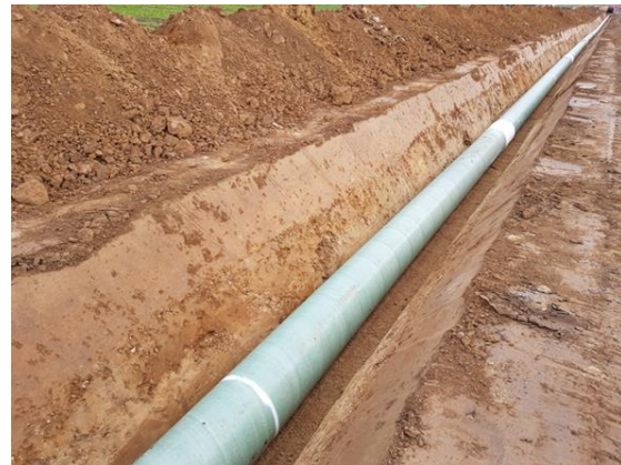
Abbildung 13: Rohrstrang auf Bettung
