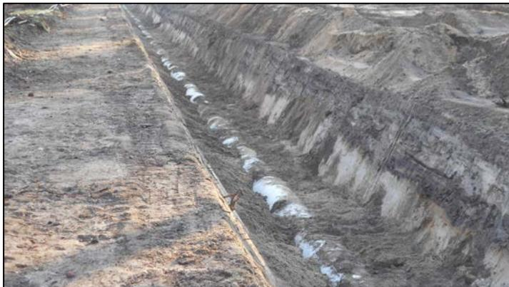
*Abbildung 40: Teilverfüllung des Rohrgrabens*
