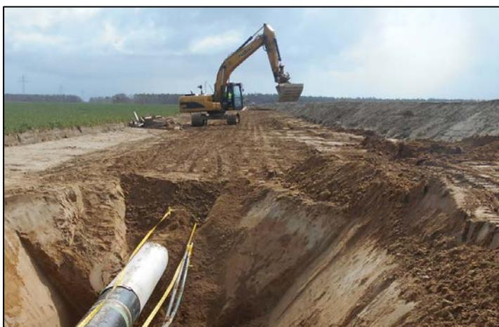
*Abbildung 42: Restverfüllung des Rohrgrabens*
