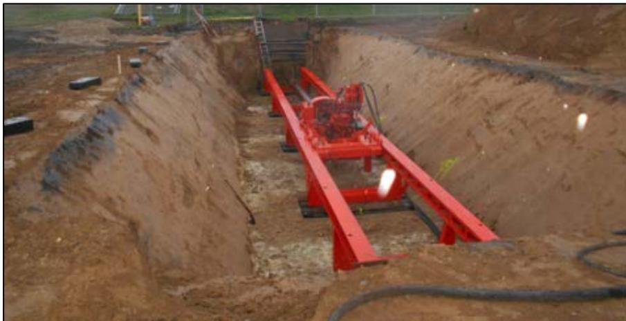
Abbildung 36: geschlossene Querung mittels Pilotrohrvortrieb
