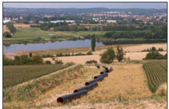
*Abbildung 33: Auslegen längs der Trasse*
