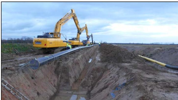
Abbildung 38: Absenken des Rohrstranges
