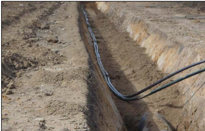
*Abbildung 41: Verlegung Kabelleerrohre in offener Bauweise*
