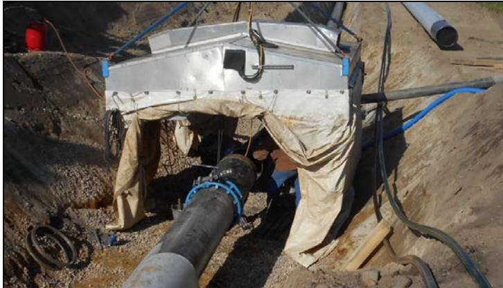
*Abbildung 39: Verschweißen zweier Rohrstränge*
