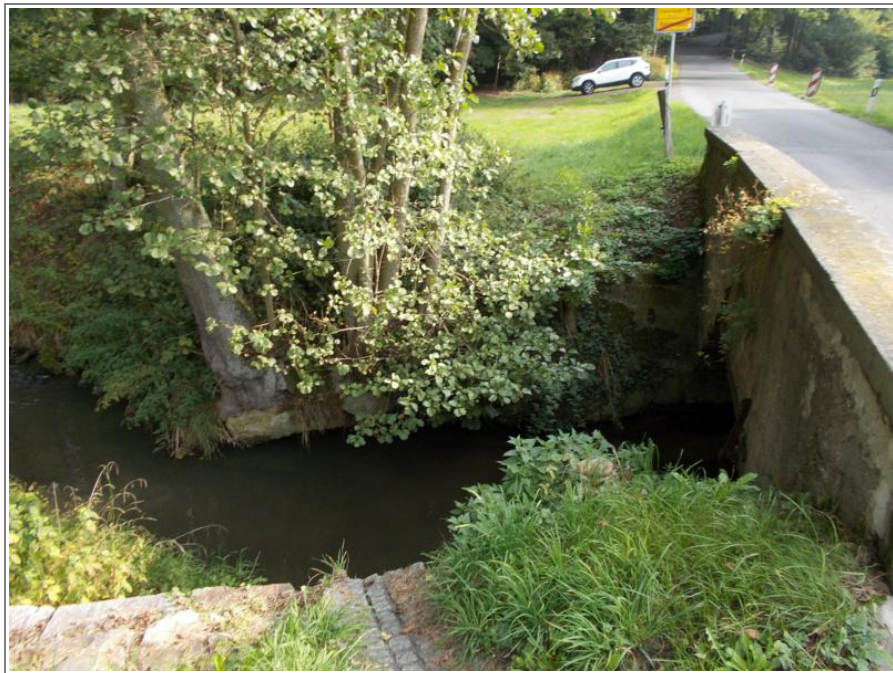
Abb. 5 Flügelmauern am Brückenbauwerk oberstrom.
