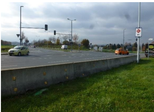
Foto 1: Bauanfang im Bereich der Anschlussstelle Südumfahrung – S 236
