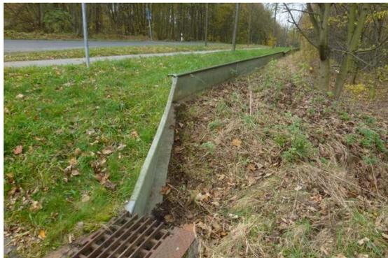
Foto 15: Amphibienschutzanlage an der B 173 zwischen ehemaligem Munitionslager und NSG „Eibsee“
