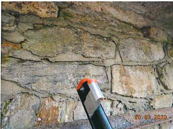
2020E-07-STIRNMAUER VORN LINKS VERFORMT UND GERISSEN
