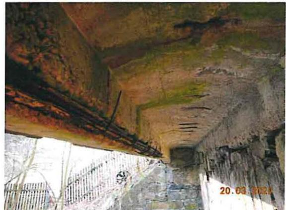
2020E-05-BALKEN ÜBERBAUVERBREITERUNG RECHTS AUßEN-VERROSTETE TRAGBEWEHRUNG
