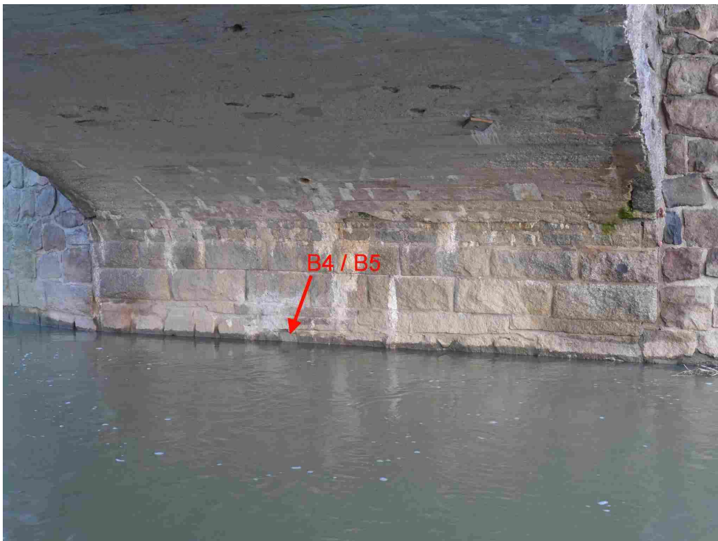
Bild 14: Widerlager Weißenberg (Norden), Kernbohrungen B4 / B5, Quadermauerwerk, Bruchsteine ab 2. Reihe unterhalb des Kämpfers
