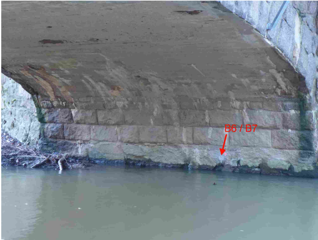
Bild 13: Widerlager Maltitz (Süden), Kernbohrungen B6 / B7, Quadermauerwerk, Bruchsteine ab 2. Reihe unterhalb des Kämpfers
