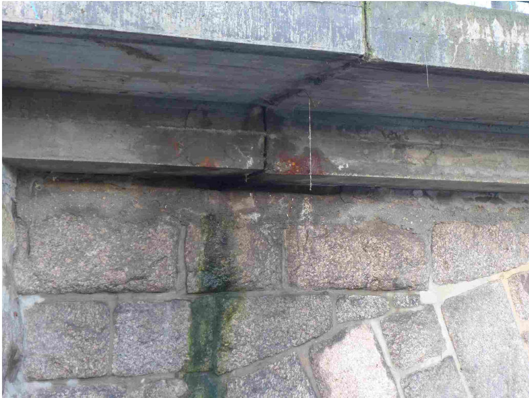
Bild 17: Beton-Fertigteilplatte zur Fahrbahnverbreiterung, vermörtelter Spalt (ca. 30 mm) zwischen Stirnmauer und Fertigteilplatte
