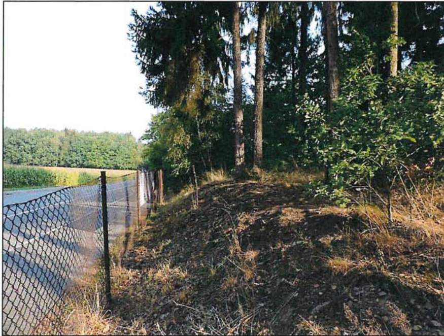
Bild 5: Bau-km 0+245: Blick Richtung Norden (nach der Bushaltestelle)
