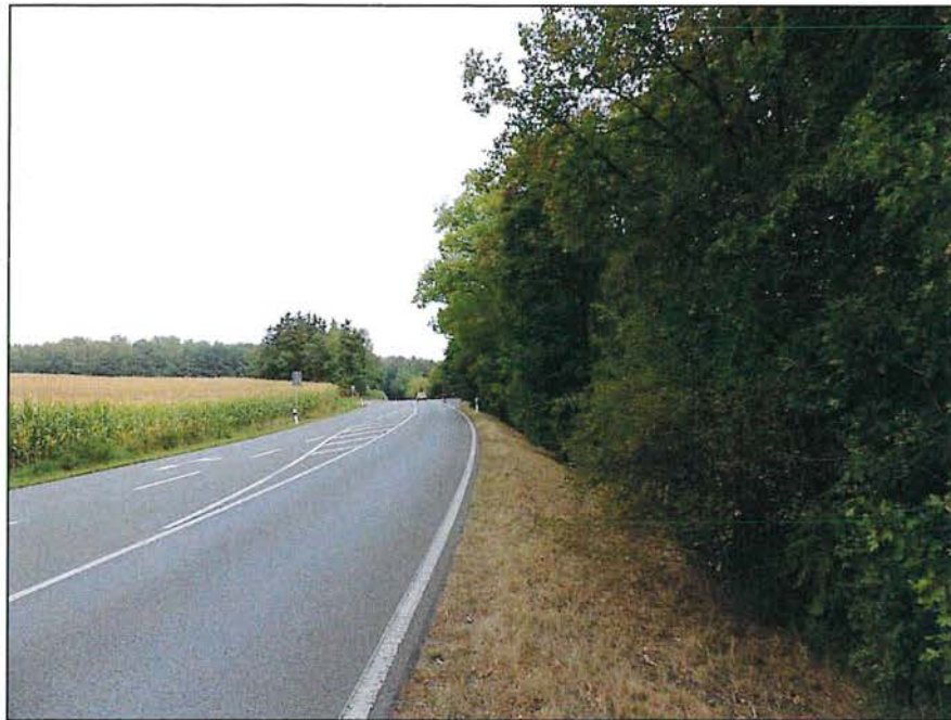
Bild 3: Bau-km 0+130, Blick Richtung Bushaltestelle
