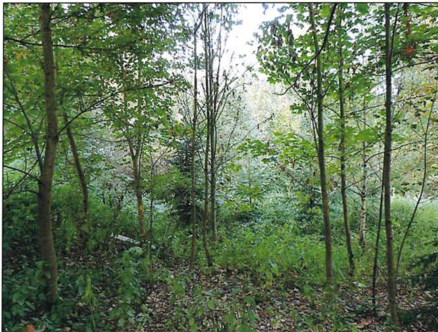
Bild 24: ca. Bau-km 0+750: Gehölzaufwuchs
