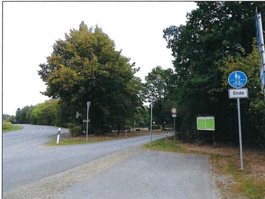
Bild 1: Bauanfang / Ende des aus Richtung Möschwitz kommenden Radweges
