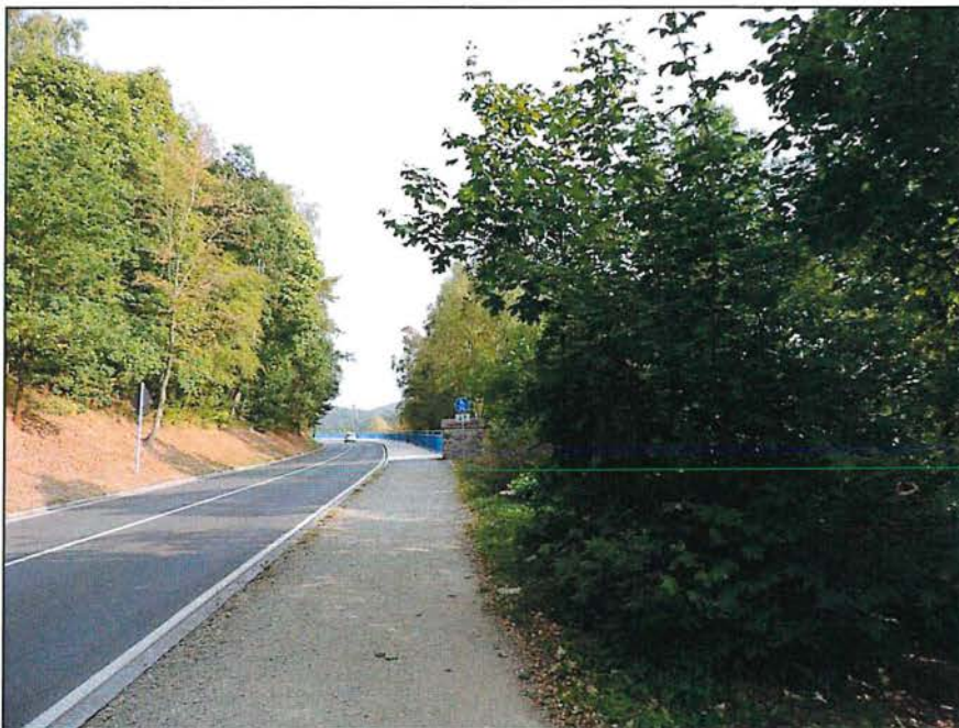
Bild 36: Bau-km 0+940, Blick Richtung Bauende
