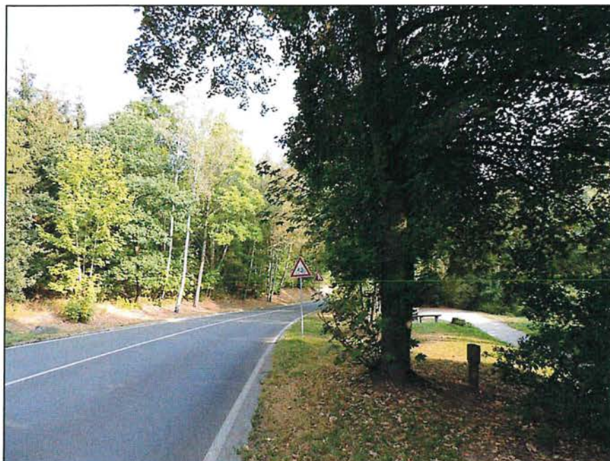
Bild 28: Bau-km 0+880: Blick Richtung Einbindung in vorhandenen Weg (rechts)
