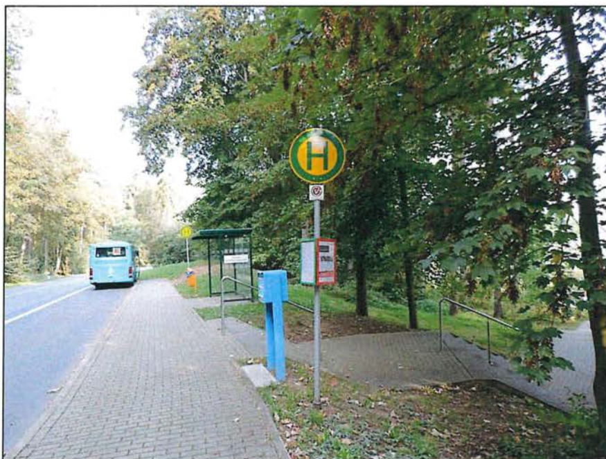
Bild 20: Bau-km 0+720: Blick Richtung Bushaltestelle bei Schiffsanlegestelle
