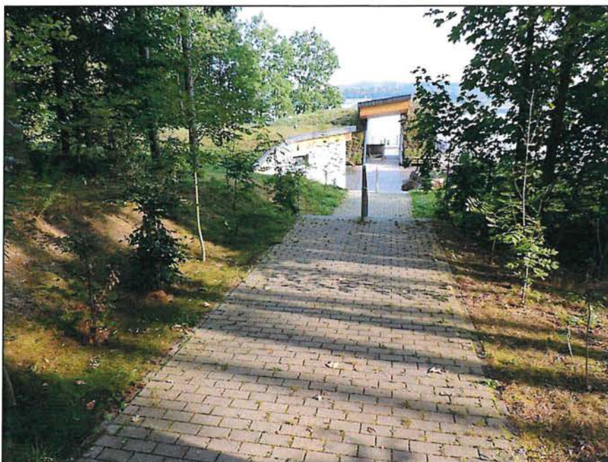
Bild 22: Bau-km 0+720: Blick Richtung Kassenhäuschen der Schiffsanlegestelle
