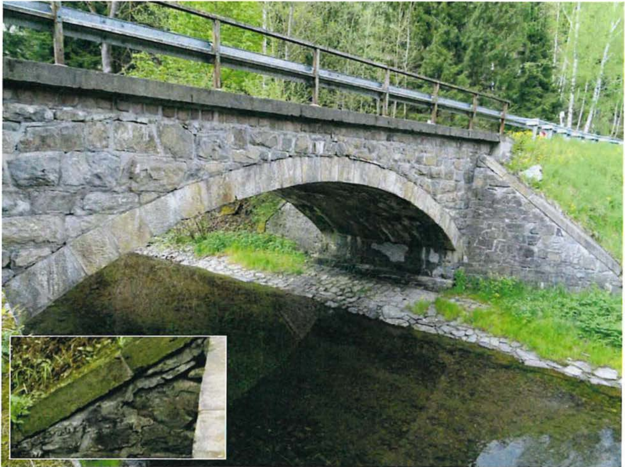
Abb. 7: Die Brücke weist kaum Nischen oder Spalten auf.
