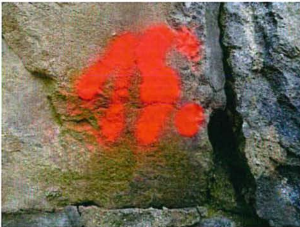
Abb. 27: Westufer/ Stimwand NW/ Struktur 15
