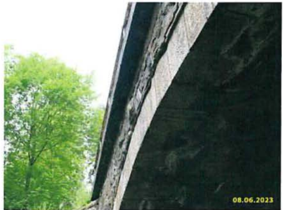
HP 2023 - BILD 18 - STIRNWAND SCHEITELBEREICH OBERSTROM - VON GEWÄSSERSOHL
