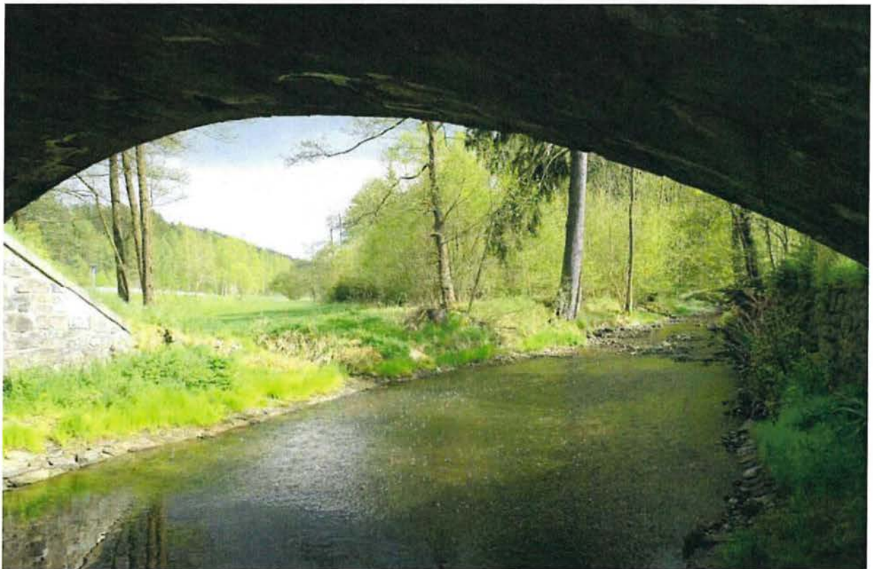
Abb. 8: Die Bauweise reduziert das Quartierpotenzial auf Wechselquartiere einzelner Fledermäuse (z. B. Wasser-/ Zwergfledermaus).
