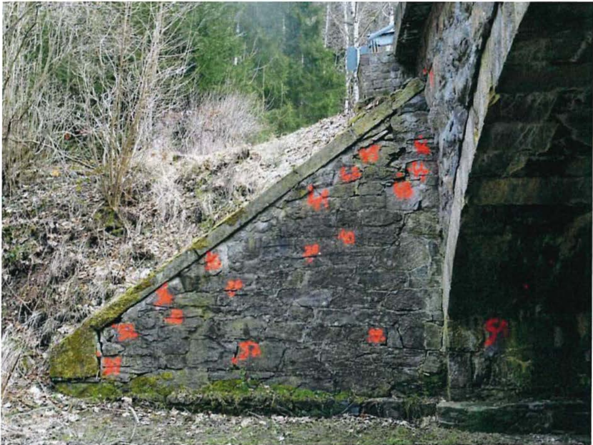
Abb. 43: Ostufer mit Flügel Nordost (F NO) und Stimmwand NO, Strukturen 31-50
