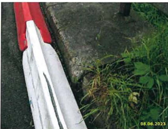
HP 2023 - BILD 01 - BETONGEFÜGE KAPPENFERTIGTEIL HINTEN LINKS
