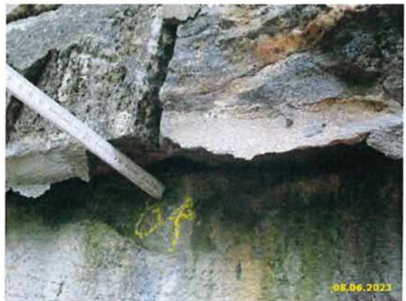
HP 2023 - BILD 17 - MESSUNG DES STIRNWANDÜBERSTANDES UNTERSTROM - SCHEITELBEREICH
