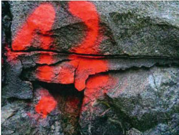
Abb. 25: Westufer/ Stimwand NW/ Struktur 13
