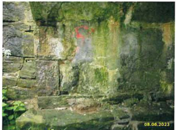
HP 2023 - BILD 13 - MAUERWERKSSTRUKTUR WIDERLAGER VORN - RAND RECHTS
