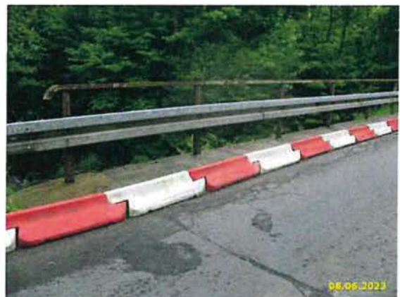
HP 2023 - Bild 04 - Schutzplanke links - vor BW-Ende
