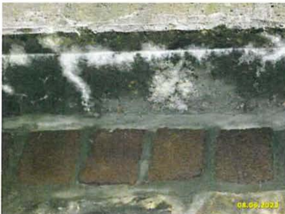
HP 2023 - BILD 19 - GESIMSUNTERSICHT RECHTS - FERTIGTEIL 2 NACH BAUTEILANFANG
