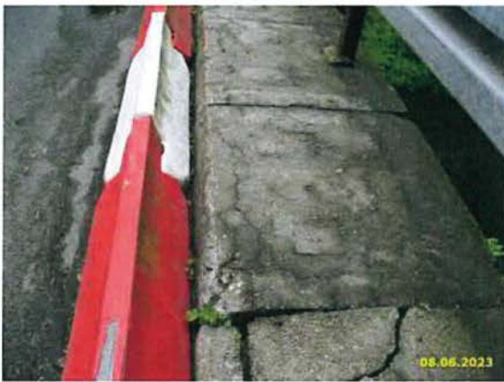
HP 2023 - BILD 02 - BETONGEFÜGE KAPPENFERTIGTEIL VORN RECHTS
