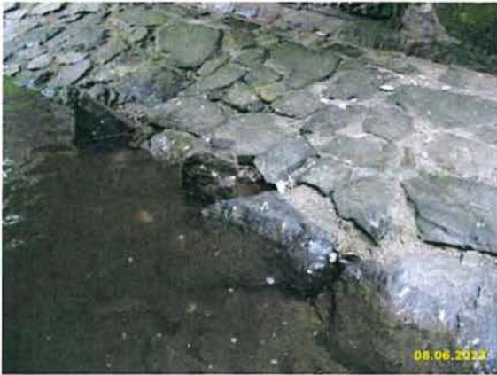
HP 2023 - BILD 09 - UFERBEFESTIGUNG VOR WIDERLAGER HINTEN - LÄNGSACHSE
