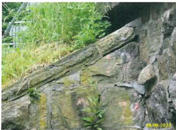
HP 2023 - BILD 08 - FLÜGELKOPF OBERSTROM LINKS MIT ABDECKPLATTEN
