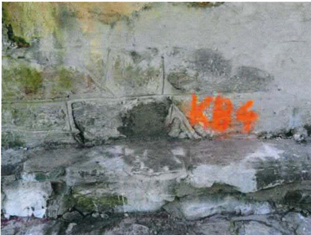
Bohransatzpunkt der KB 4/19 nach Wiederverschluss des Mauerwerkes
