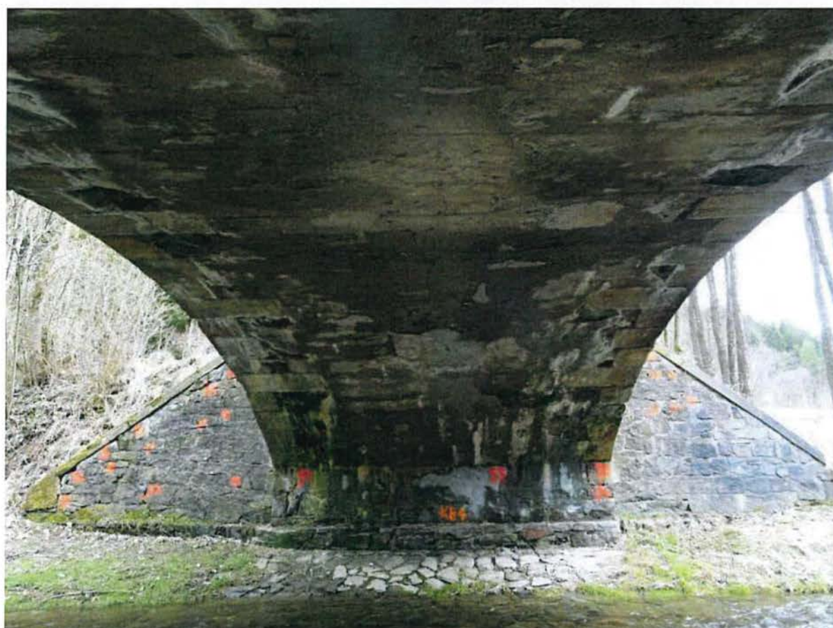
Abb. 8: Ostufer mit Widerlager Ost (WL O), Flügel Nordost (F NO) & Flügel Südost (F SO)
