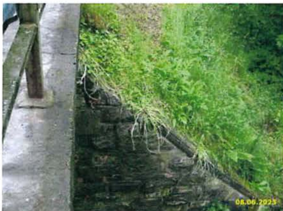
HP 2023 - BILD 15 - FLÜGELKOPF UNTERSTROM LINKS MIT ABDECKPLATTEN
