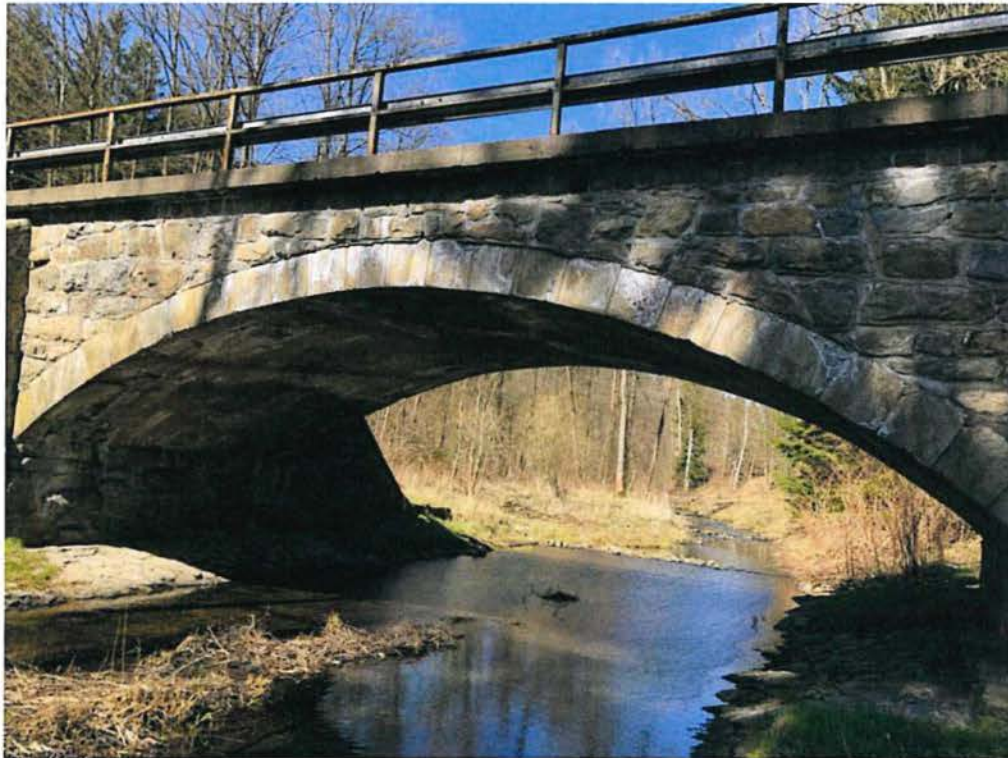
Abb. 2: Freiburger Mulde und Bestandsbauwerk
