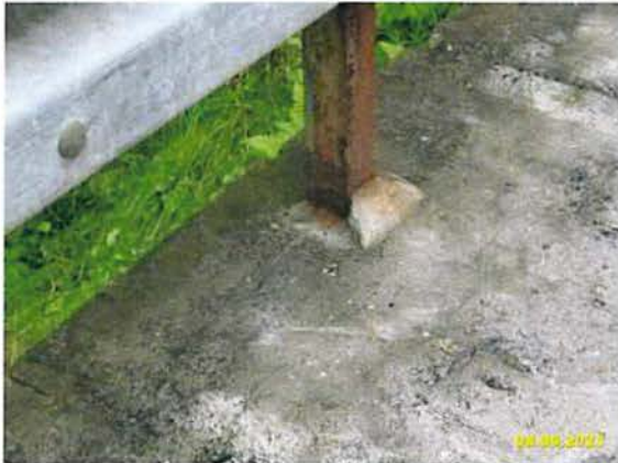
HP 2023 - BILD 05 - DETAIL PFOSTENFUß 2 DES GELÄNDERS RECHTS
