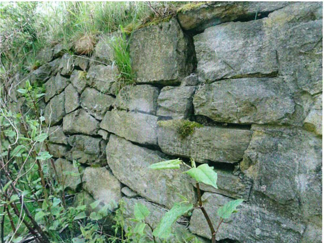
Abb. 10: Die Flügelmauer NW ist als Trockenmauer errichtet (Potenzial Nischenbrüter), jedoch mangels wertgebender Vegetation nicht als besonders geschütztes Biotop einzustufen.
