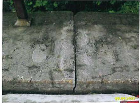
HP 2023 - BILD 03 - FUGE KAPPENFERTIGTEILE 1 UND 2 RECHTS
