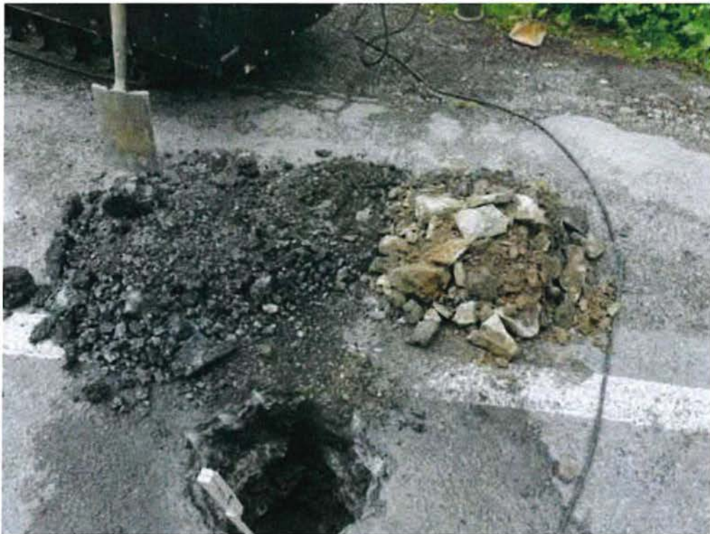
Aushubarbeiten am HS 1/19
