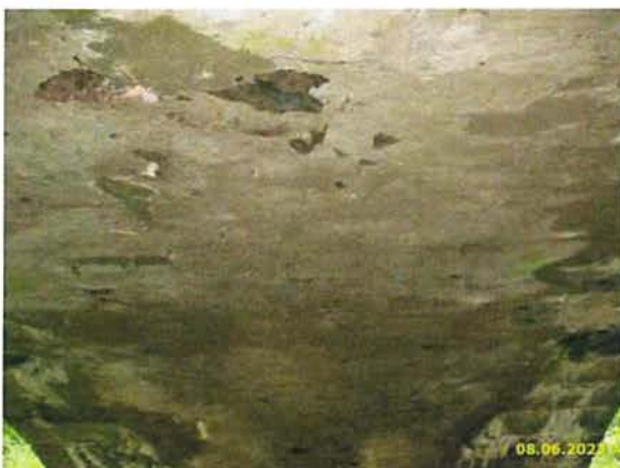
HP 2023 - BILD 12 - TRAGWERKSUNTERSICHT IN BW-LÄNGSACHSE - VON VIERTELPUNKT 1
