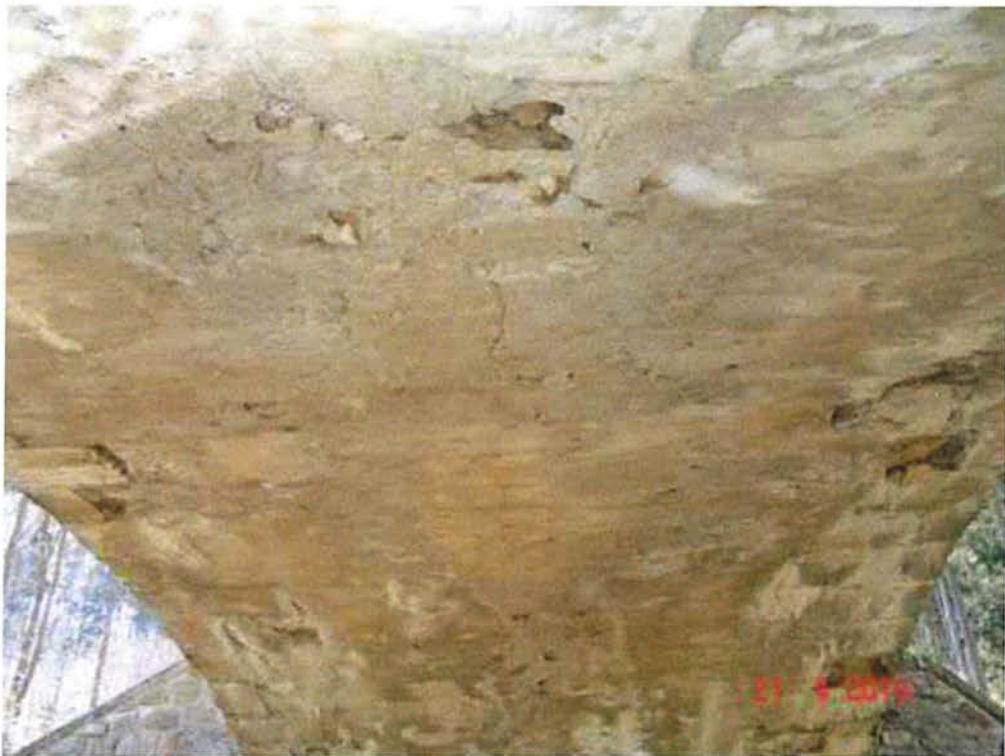
Blick in Richtung Westen in den Bogenscheitel
