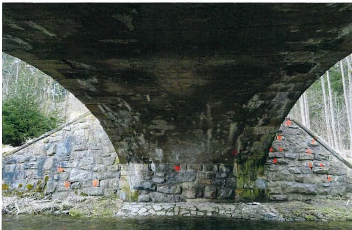
Abb. 7: Westufer mit Widerlager West (WL W), Flügel Nordwest (F NW) & Flügel SW
