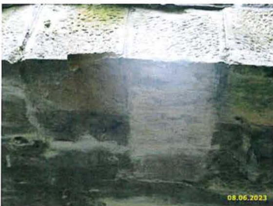
HP 2023 - BILD 11 - STEIN DER GEWÖLBESTIRN UNTERSTROM - VIERTELPUNKT 1
