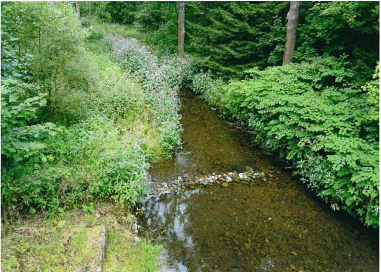
Abb. 14: Mulde direkt unterhalb der Brücke
