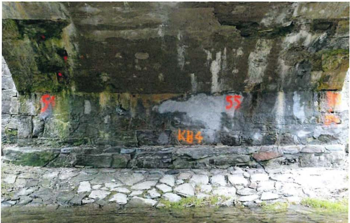
Abb. 44: Ostufer mit Widerlager Ost (WL O), Strukturen 51-55
