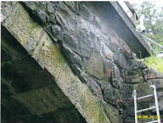
HP 2023 - BILD 16 - STIRNWAND UNTERSTROM LINKS - VON GEWÄSSERSOHL
