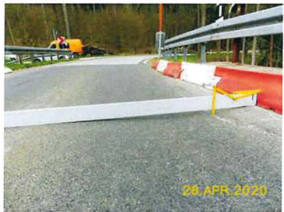
20E-005-HINTEN RECHTS - SPURRINNEN BIS 4CM - ÖRTLICHE ABSÄTZE
