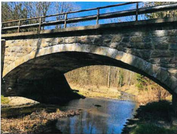
Abbildung 5: Bestandsbauwerk über die Freiburger Mulde im Eingriffsraum
