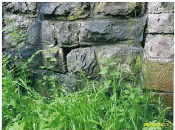
HP 2023 - BILD 14 - MAUERWERKSSTRUKTUR FLÜGEL OBERSTROM LINKS - ÜBER GELÄNDE
