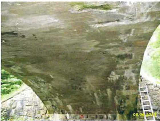
HP 2023 - BILD 10 - TRAGWERKSUNTERSICHT VON WIDERLAGER VORN
