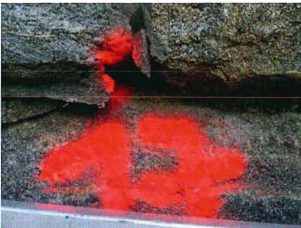
Abb. 29: Westufer/ Stimwand NW/ Struktur 17
