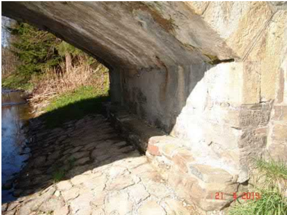
Blick von oberstrom auf das östliche Widerlager (rechtsstromig)
