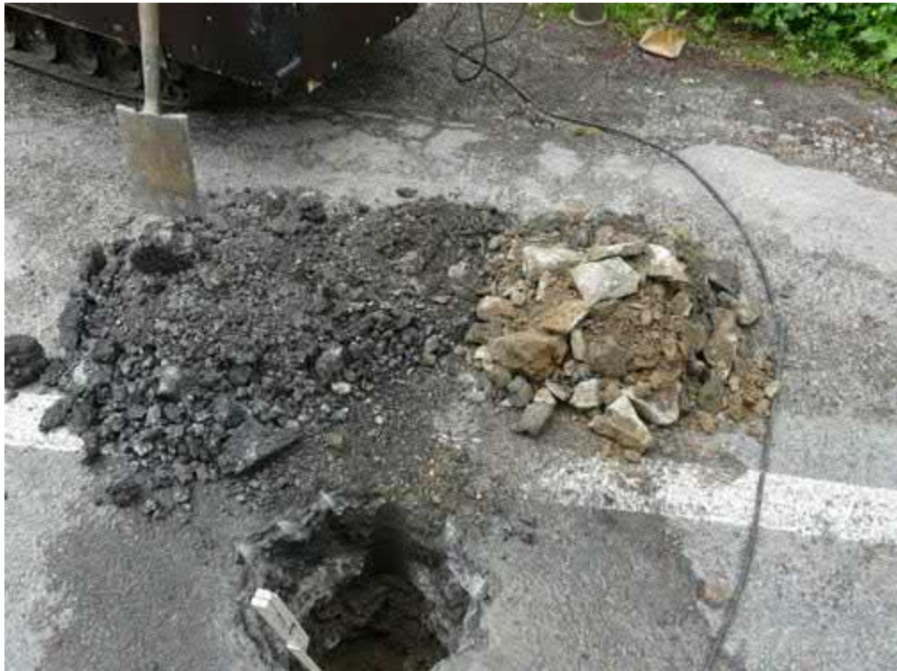
Aushubarbeiten am HS 1/19
