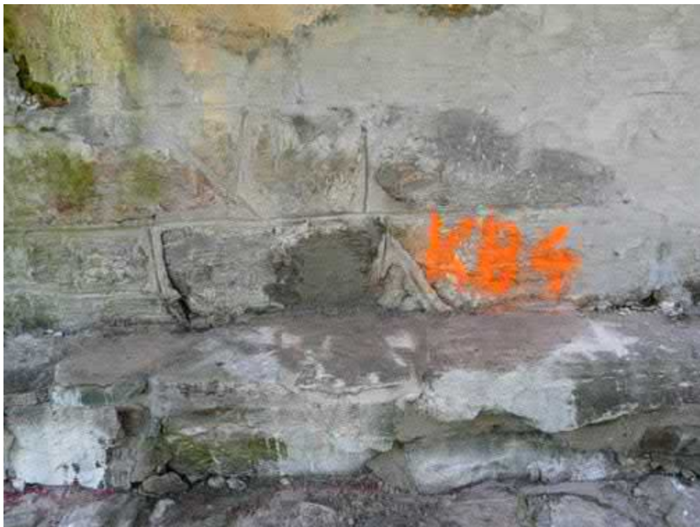
Bohransatzpunkt der KB 4/19 nach Wiederverschluss des Mauerwerkes
