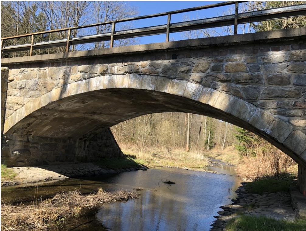
Abb. 2: Freiburger Mulde und Bestandsbauwerk
