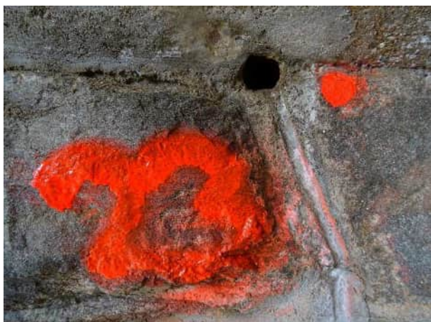
Abb. 35: Westufer/ Widerlager West/ Struktur 23
