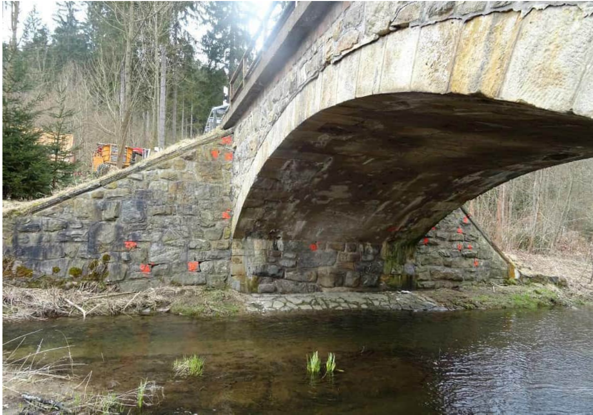
Abb. 3: S209 BW2 Brücke über die Freiburger Mulde am Katzenstein oberhalb Mulda
