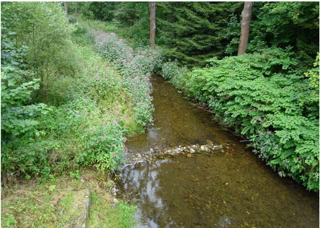
Abb. 14: Mulde direkt unterhalb der Brücke
