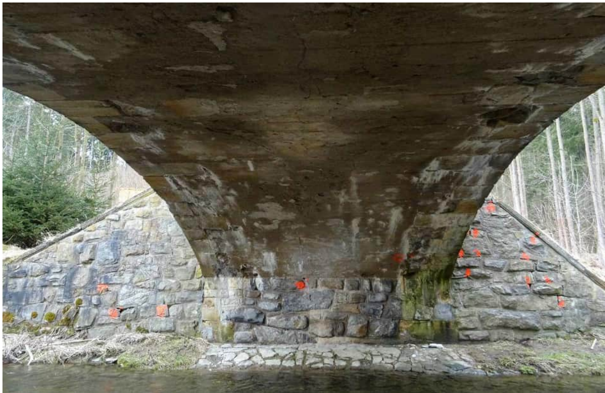
Abb. 7: Westufer mit Widerlager West (WL W), Flügel Nordwest (F NW) & Flügel SW
