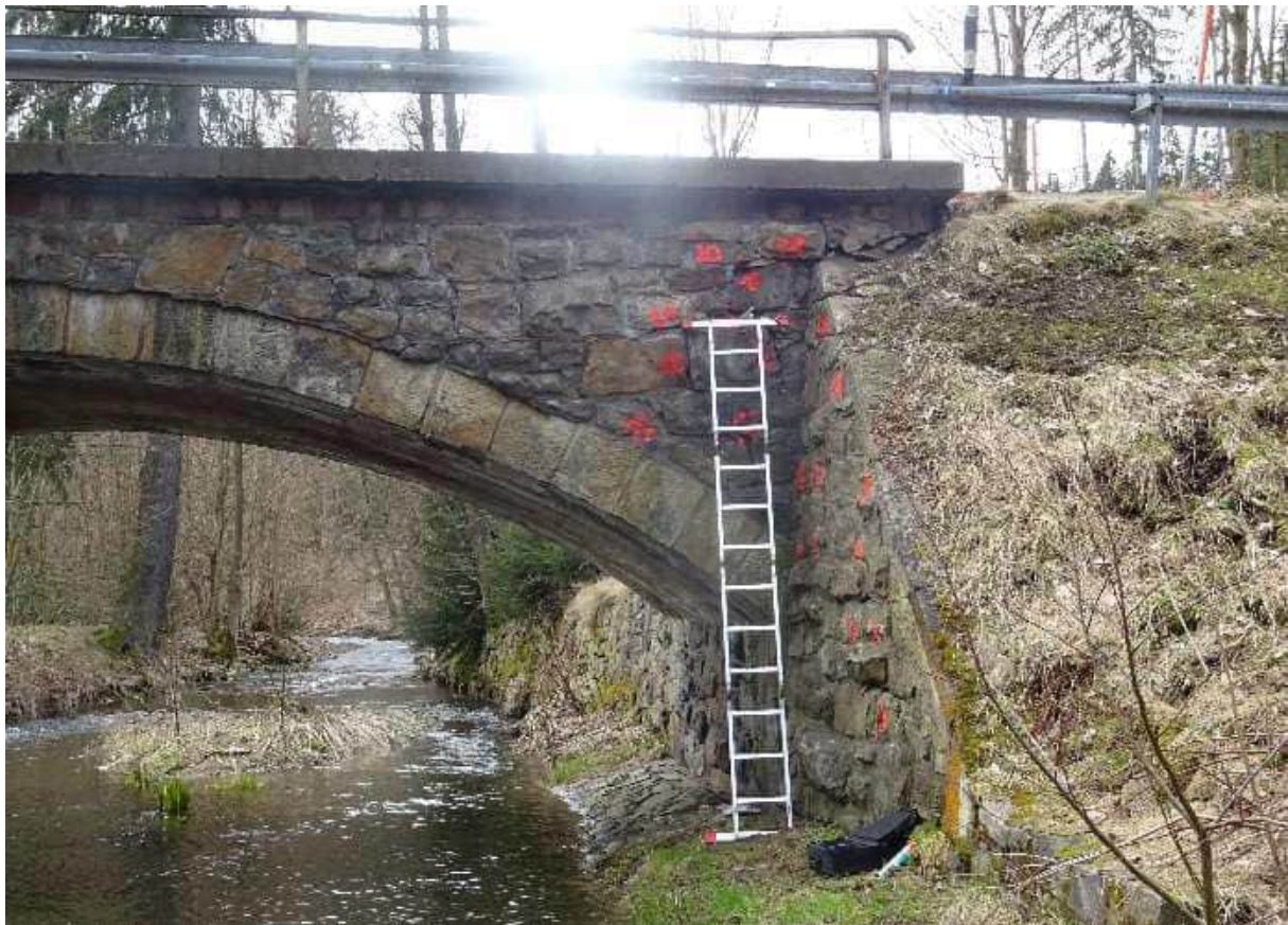
Abb. 5: Somit wurde 2021 eine erneute Begutachtung erforderlich.
