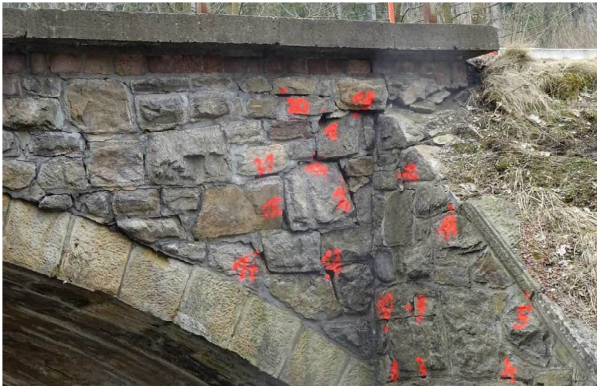
Abb. 10: Westufer mit Flügel Nordwest (F NW) und Stirnwand NW, Strukturen 13-21
