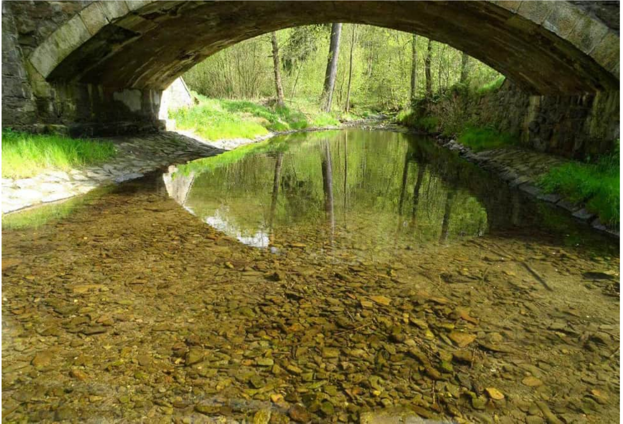
Abb. 23: Das grobe Sohlssubstrat spricht für Vorkommen von Bachforelle und Groppe
