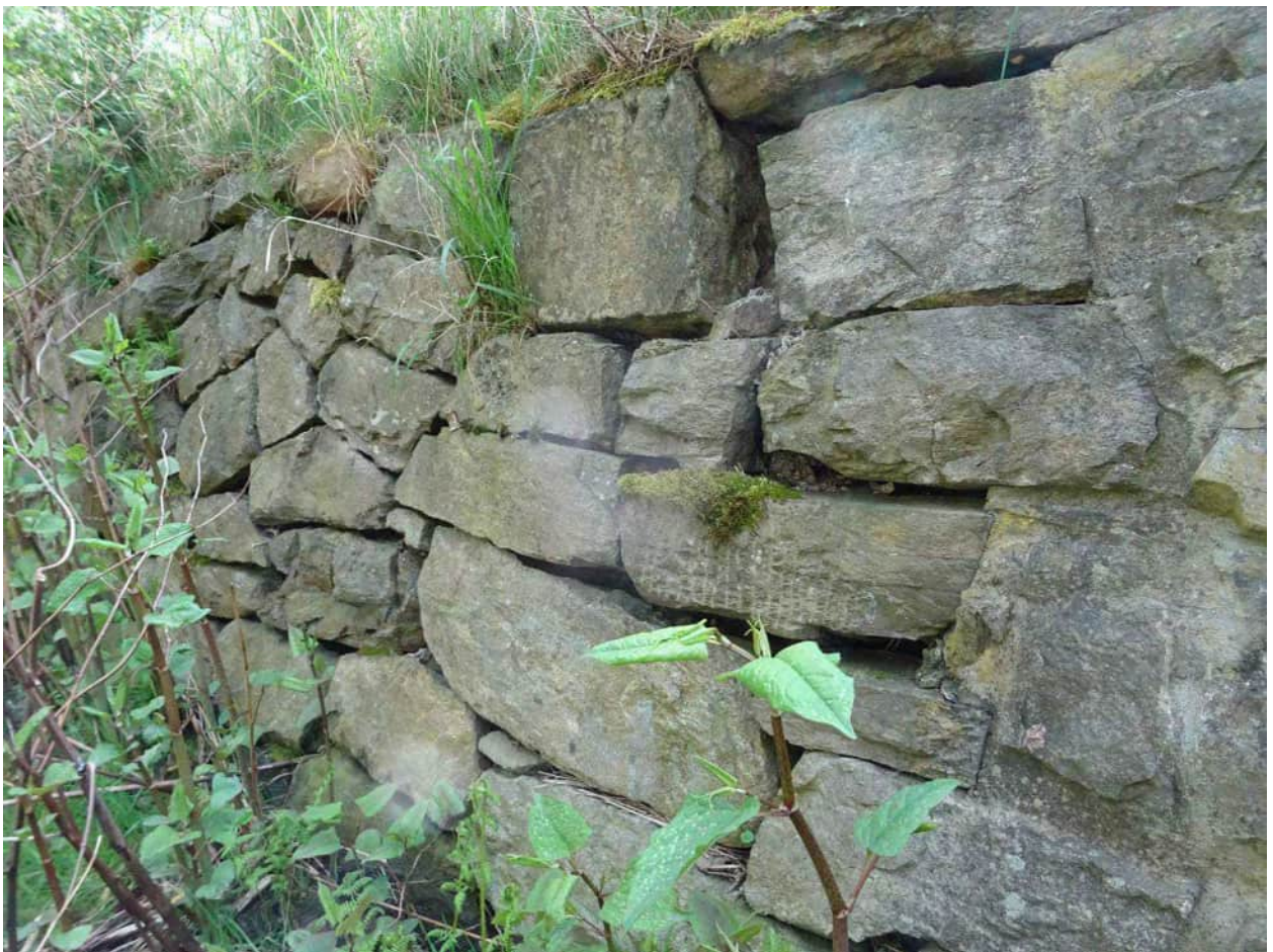
Abb. 10: Die Flügelmauer NW ist als Trockenmauer errichtet (Potenzial Nischenbrüter), jedoch mangels wertgebender Vegetation nicht als besonders geschütztes Biotop einzustufen.
