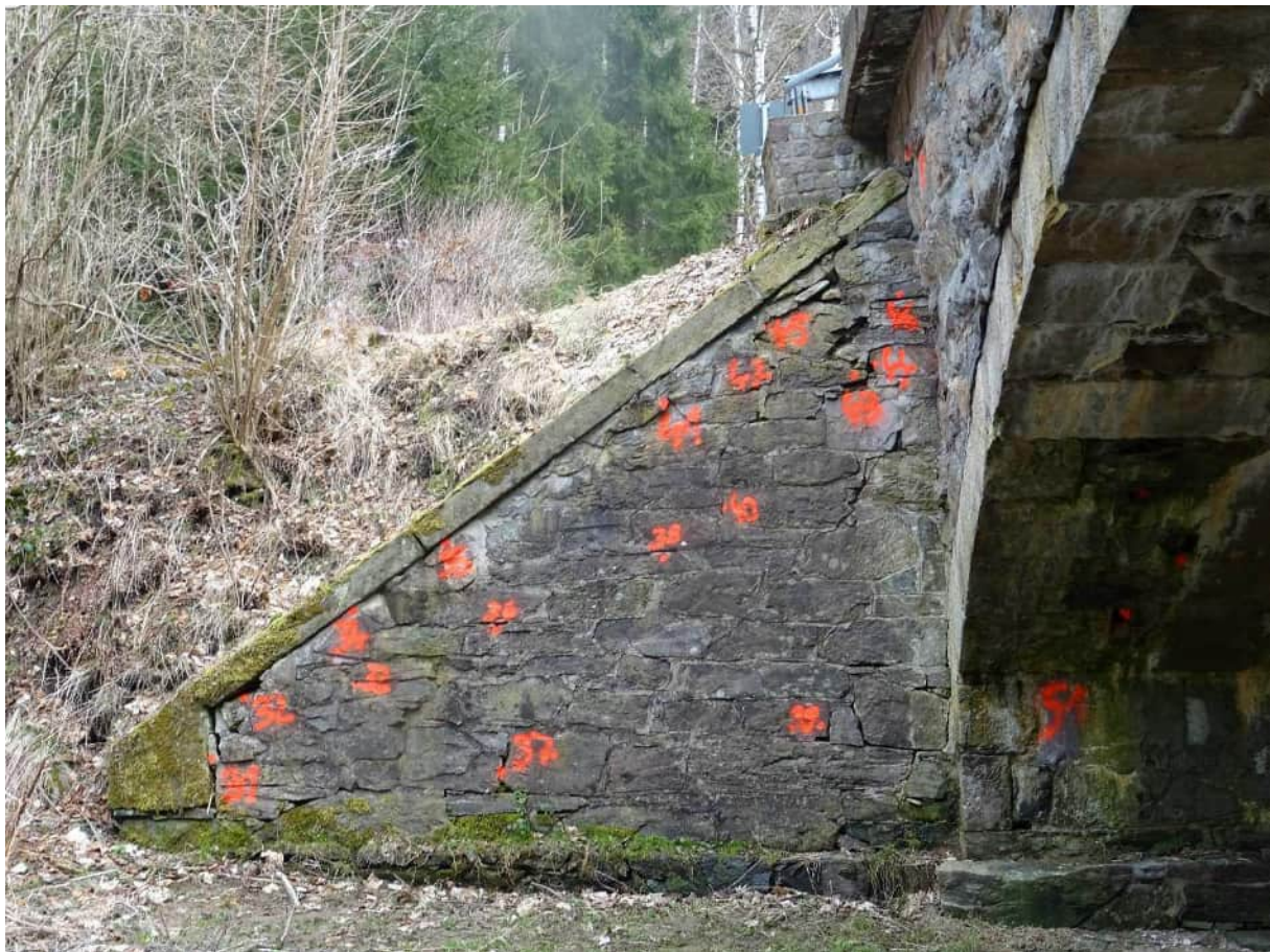
Abb. 43: Ostufer mit Flügel Nordost (F NO) und Stirnwand NO, Strukturen 31-50
