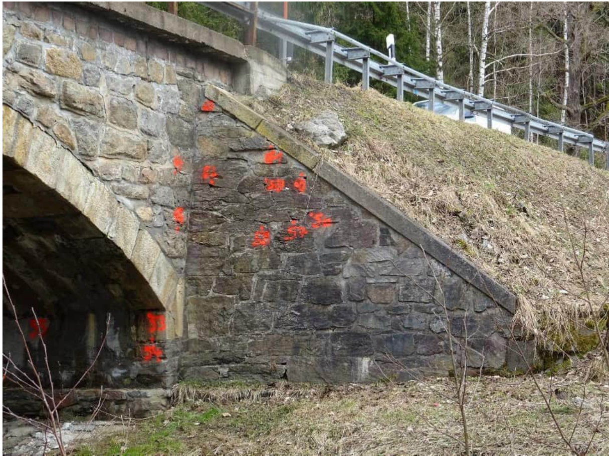
Abb. 45: Ostufer mit Flügel Südost (F SO) und Stirnwand SO, Strukturen 56-65
