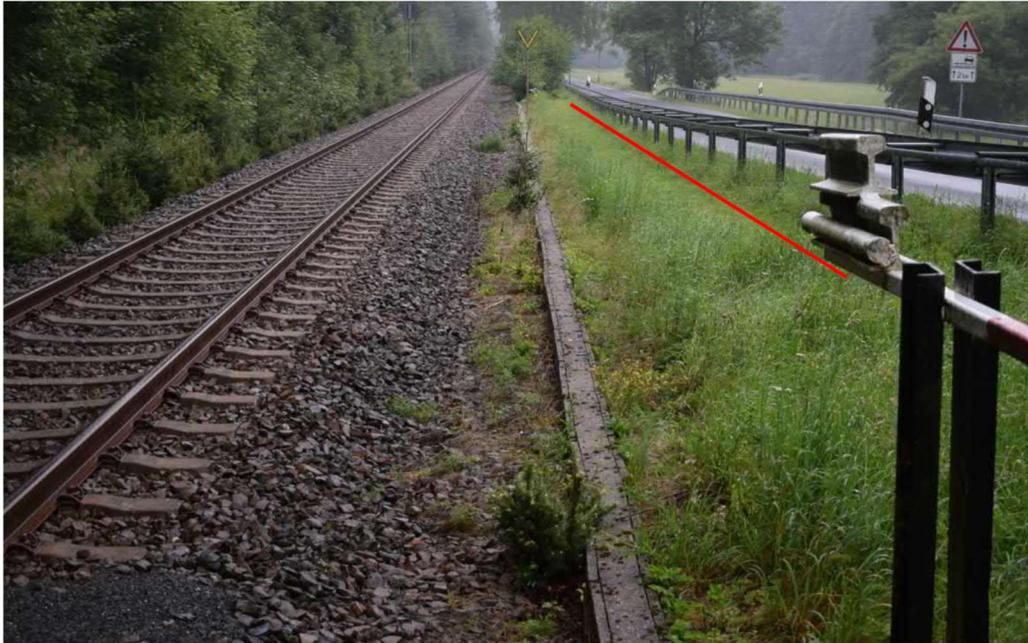
Im Bereich der künftigen Baustelle ist, um den Eisenbahnbetrieb nicht zu stören, eine feste Absperrung einzuplanen. Es darf zu keiner Zeit zu Einragungen in den Regellichtraum Bahn durch Baufahrzeuge oder der gleichen sowie ein Betreten des Gefahrenraumes kommen.
