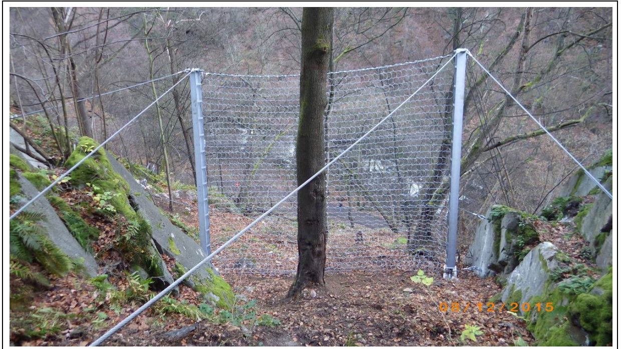
Abb. 1.1-1: Steinschlagschutzzaunsystem im aufgebauten Zustand (Quelle: GEOPLAN GmbH)
