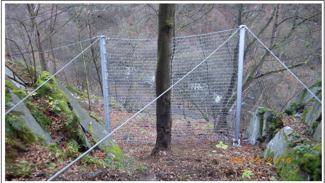
Abb. 5.2-1: Steinschlagschutzzaunsystem im aufgebauten Zustand (Quelle: GEOPLAN GmbH)
