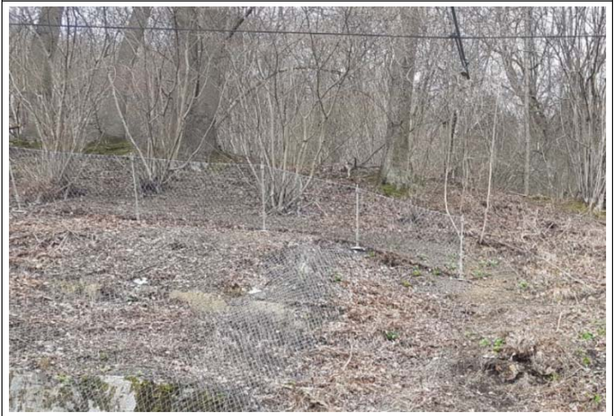
Abb. 3.2-2: ca. 1 m hoher Steherzaun im aufgebauten Zustand (Quelle: GEOPLAN GmbH)
