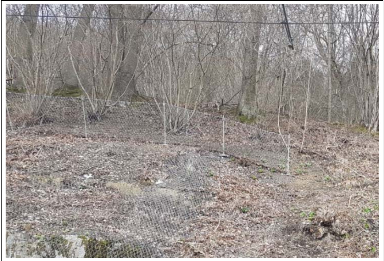
Abb. 5.2-2: ca. 1 m hoher Steherzaun im aufgebauten Zustand (Quelle: GEOPLAN GmbH)
