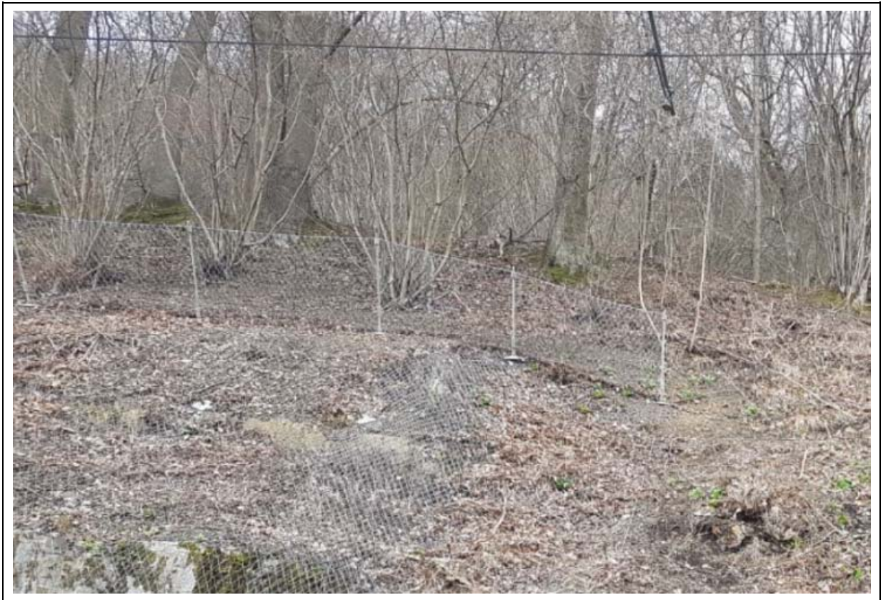
Abb. 3.1-2: ca. 1 m hoher Steherzaun im aufgebauten Zustand (Quelle: GEOPLAN GmbH)
