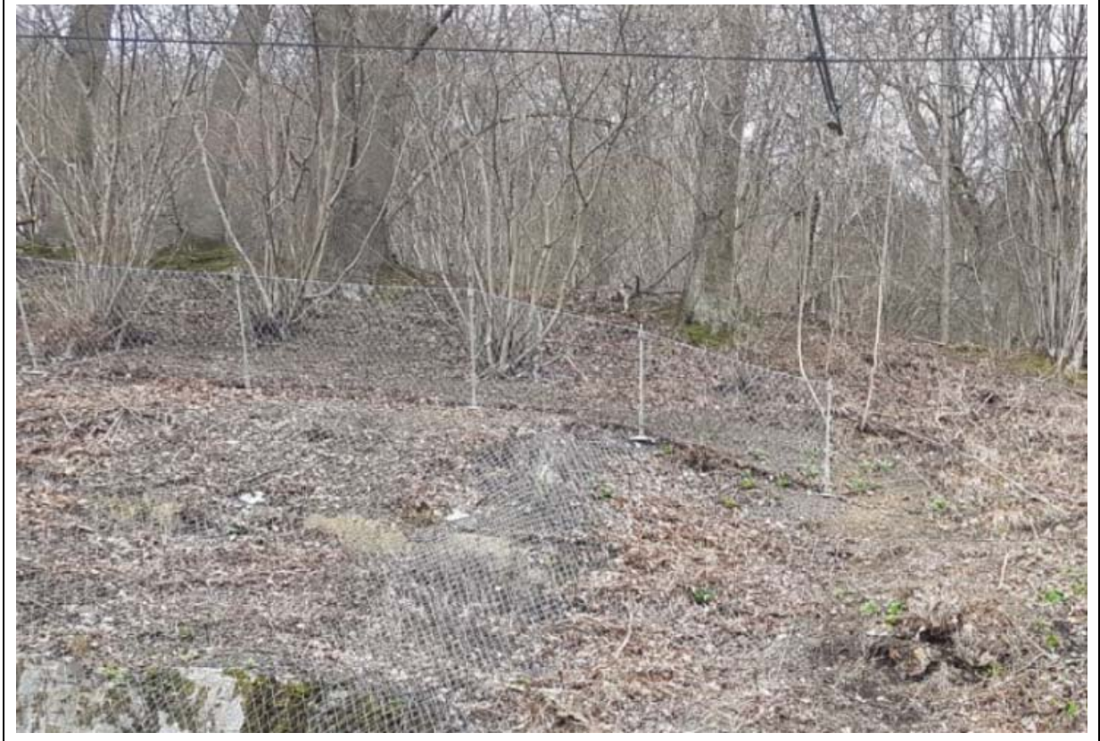
Abb. 1.1-2: ca. 1 m hoher Steherzaun im aufgebauten Zustand (Quelle: GEOPLAN GmbH)
