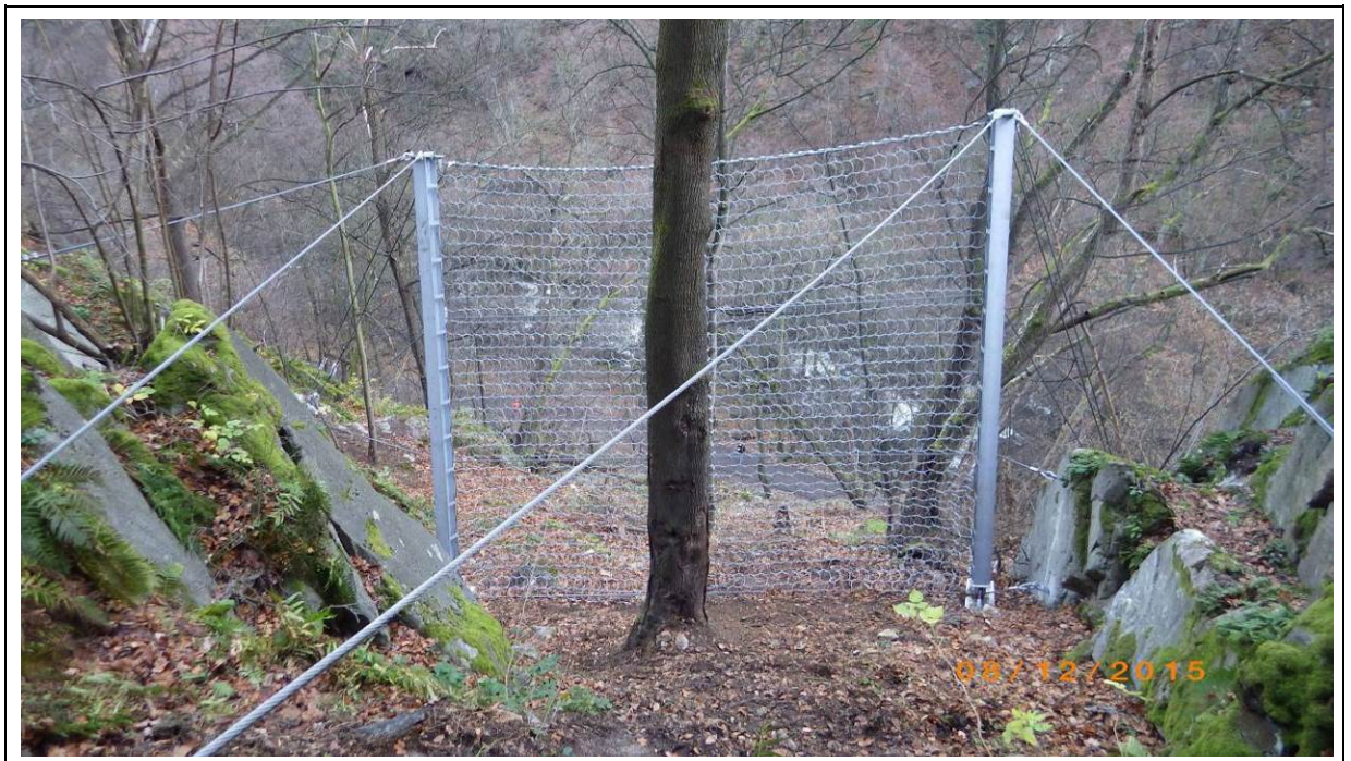
Abb. 3.1-1: Steinschlagschutzzäunsystem im aufgebauten Zustand (Quelle: GEOPLAN GmbH)
