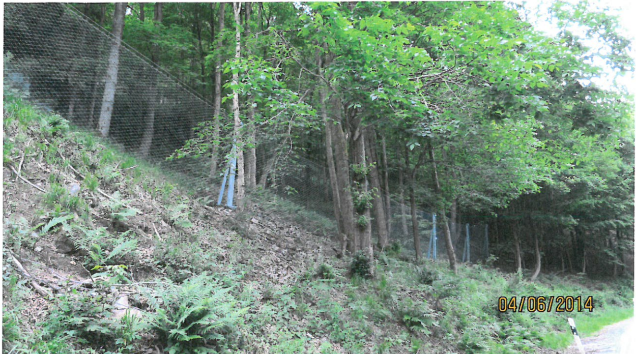
Abbildung 4 : Einbau Steinschlagschutzzaun am Hangfuß in Waldbestand
