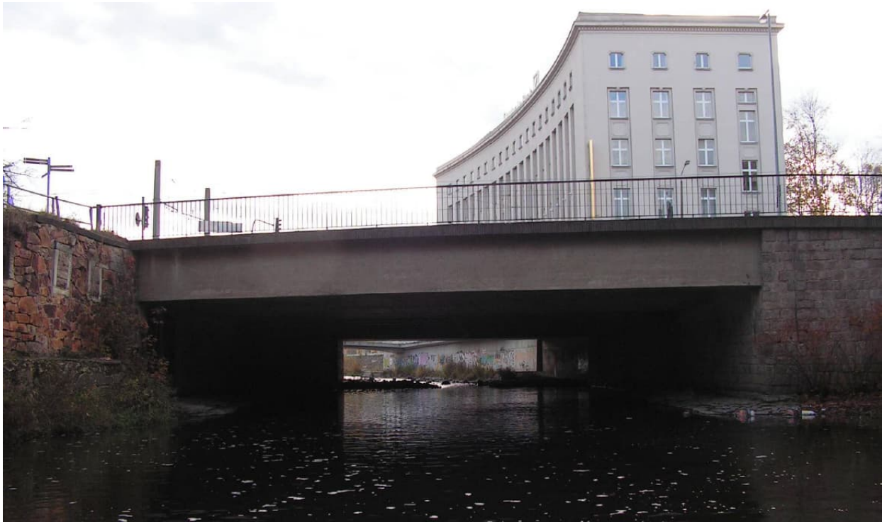
Abbildung 3-13 Brücke Falkeplatz; Teilbauwerk 3 15
