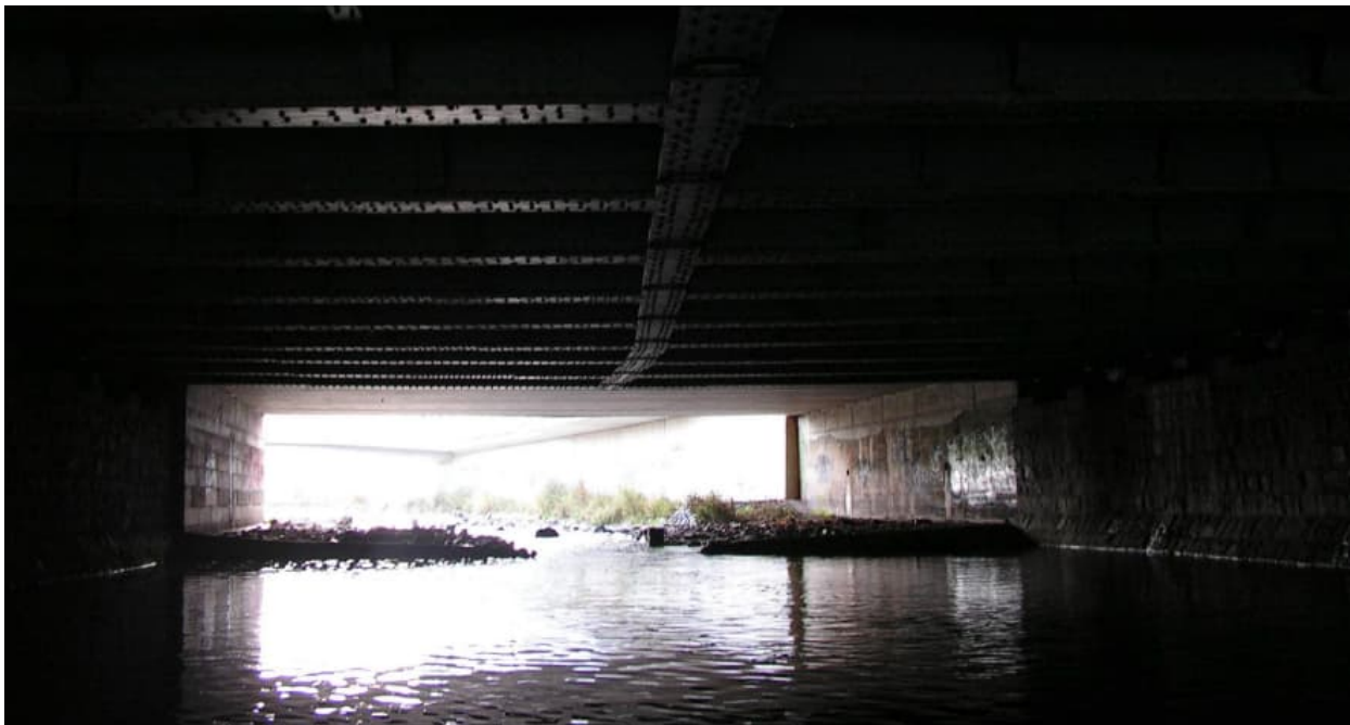
Abbildung 3-12 Brücke Falkeplatz; Teilbauwerk 2 14
