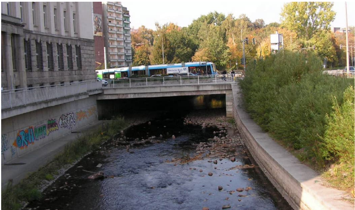
Abbildung 3-11 Brücke Falkeplatz; Teilbauwerk 1 13
