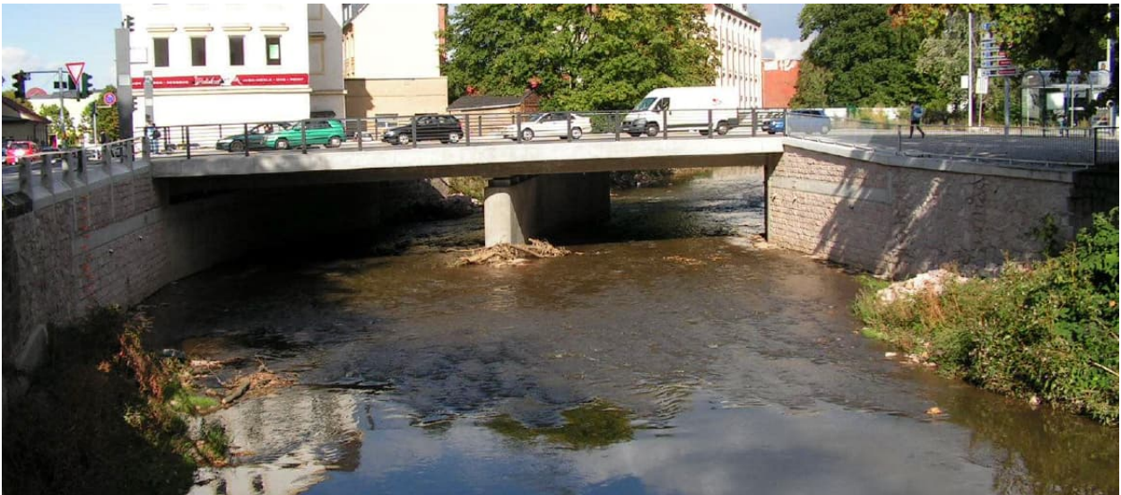
Abbildung 3-3 Brücke Hartmannstraße; Bestand; Aufnahme vom 19.09.2012 4
