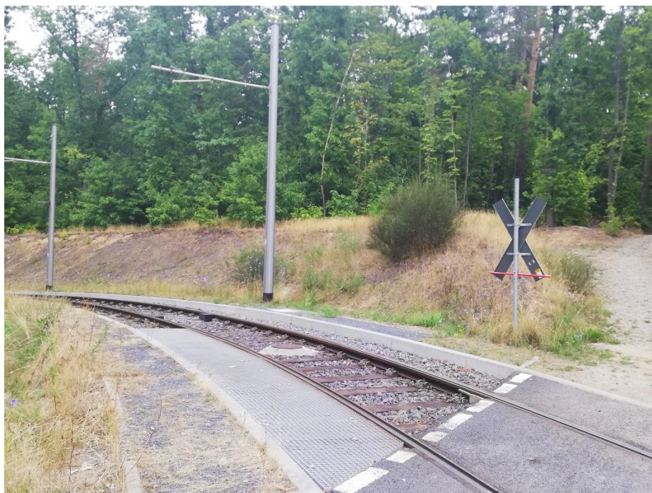
Abbildung 15: Gleisanlage (Teil der Straßenbahn-Wendeschleife) und Ruderalflur trockenwarmer Standorte
