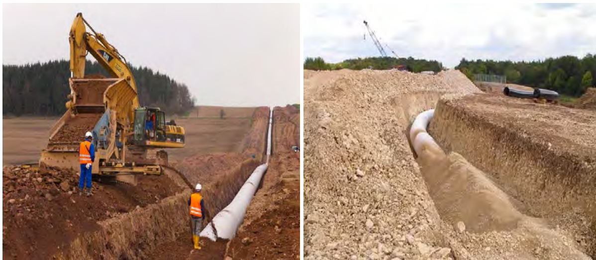
Abbildung 35: Teilverfüllung des Grabens
