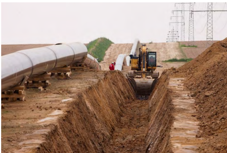
Abbildung 32: Ausheben des Grabens
