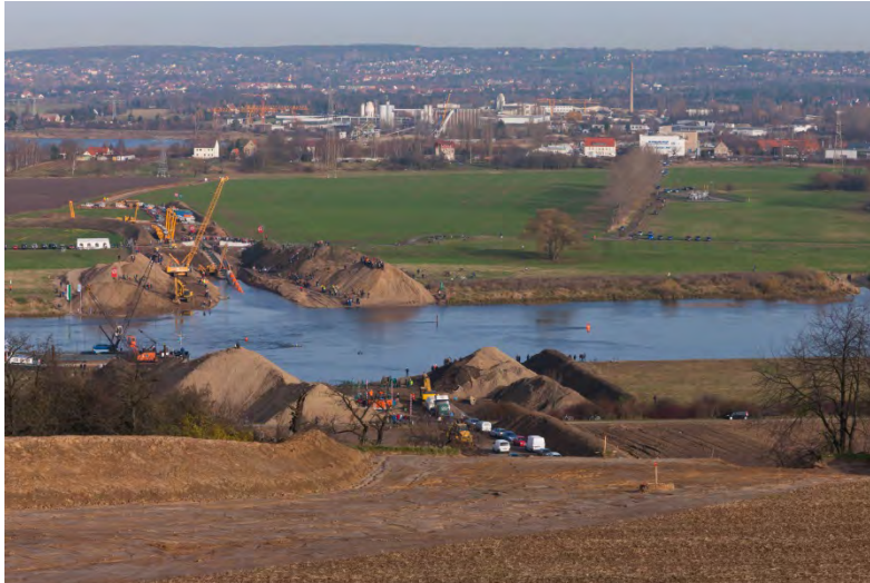
Abbildung 30: Kreuzung von Gewässern (hier: Elbedüker der OPAL bei Coswig)
