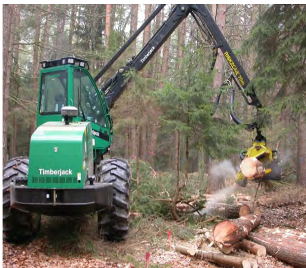
Abbildung 25: Räumen der Trasse (a+b)
