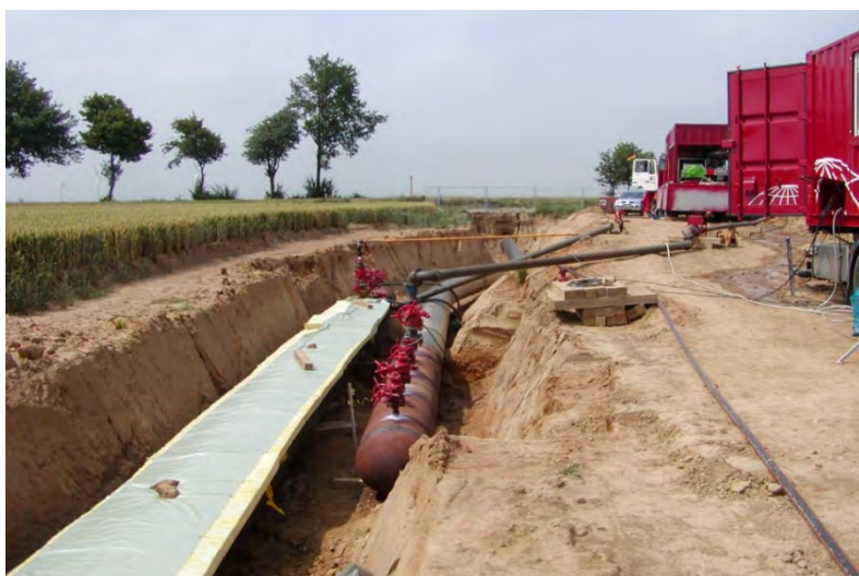
Abbildung 36: Wasserdruckprüfung
