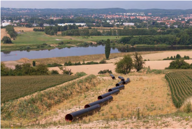
Abbildung 28: Aufreihen der Rohre im Trassenabschnitt
