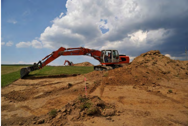
Abbildung 26: Abtragen des Oberbodens
