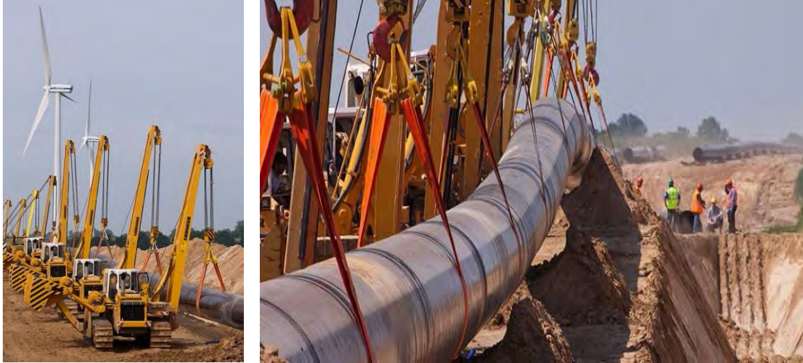
Abbildung 33: Absenken des Rohrstranges
