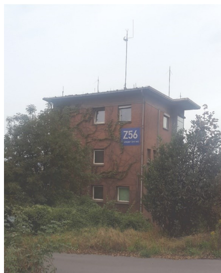
Abbildung 7-11: Ansicht der Messstation auf dem Gelände der Dillinger Hütte mit Blick in Richtung Nordwesten
